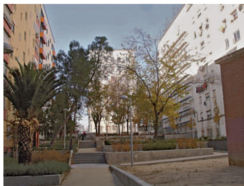
Fig. 12/ Supresión de barreras arquitectónicas en las obras de urbanización
