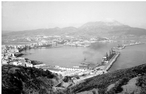
FIG. 2/ Vista de Ceuta desde el monte Hacho en los años treinta. De izquierda a derecha se observa la ciudad histórica, desarrollada en el istmo peninsular que une al monte Hacho con el Campo Exterior, y la zona portuaria
