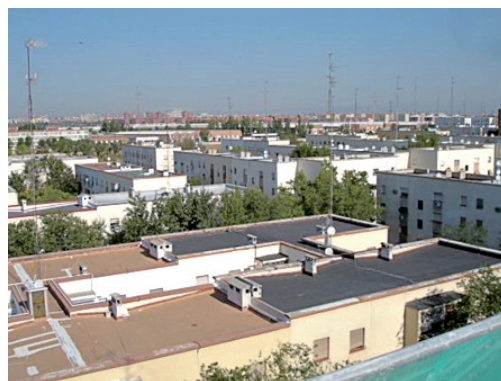
Fig. 3/ Imagen general del barrio
