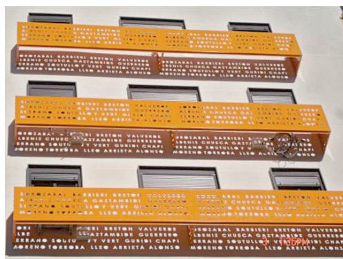
Fig. 13/ Rehabilitación (vista parcial) de edificio en Ciudad de los Ángeles
