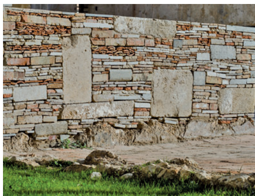
FIG. 9, 10/ Detalle de los muros construidos con los escombros de la demolición del convento aparejados en seco (Vicente A. Jiménez).
