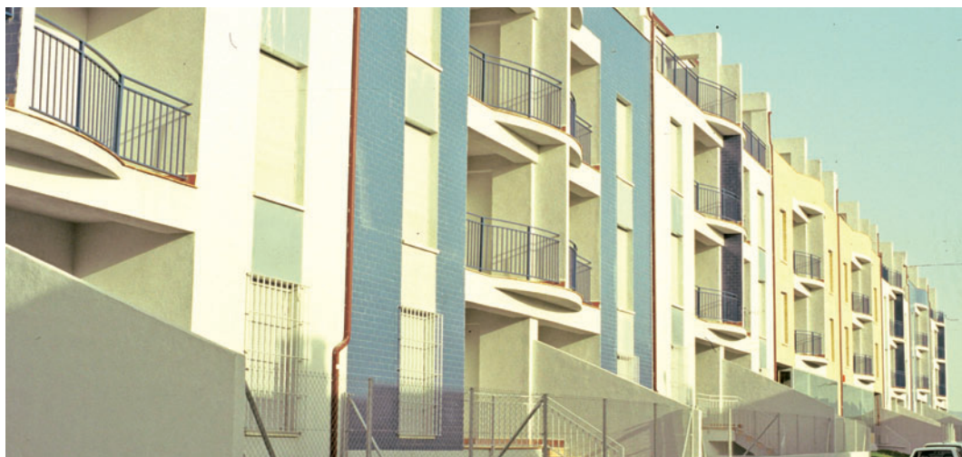
1998. Maracena. Provincia de Granada. Vivienda Obrera.
