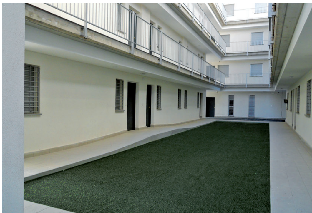
Amortiguador bioclimático en ejecución. Lámina de agua.
