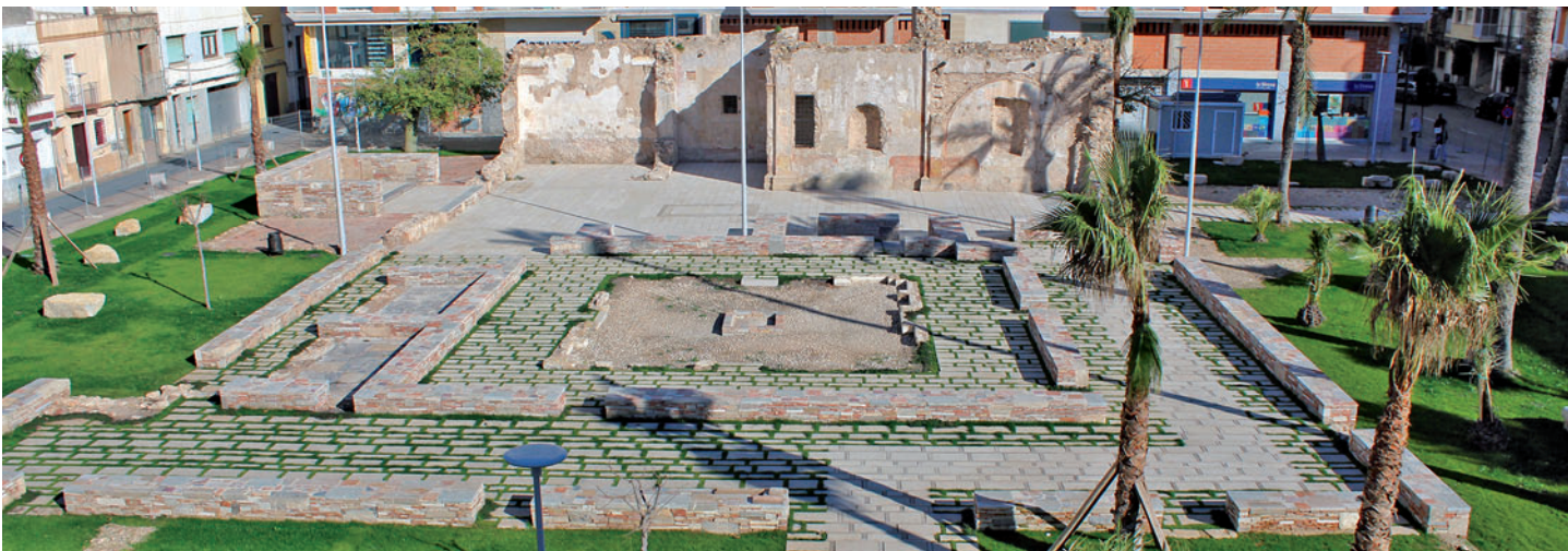
Encabezamiento. Vista aérea del jardín, una vez terminado, hacia el muro remanente de la iglesia
