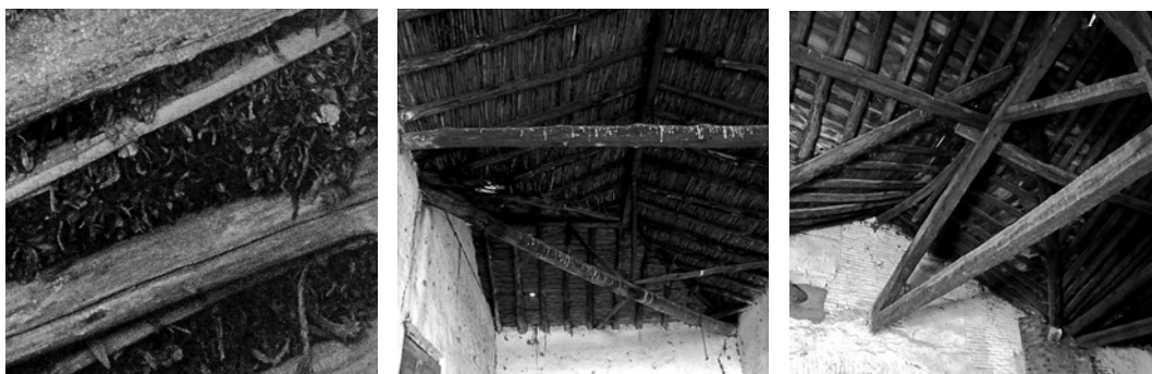
FIG. 13/ Imágenes de entrevigado en jara, cañizo y tabla ripia pertenecientes a edificaciones en estribaciones, rañas y vega respectivamente
