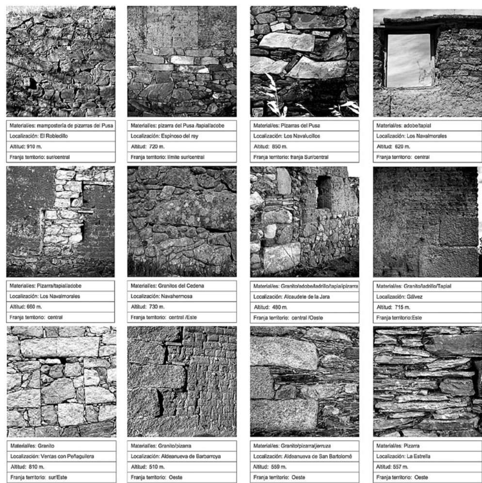
Fig. 12/ Descripción de fábricas de muros en el área de estudio en un recorrido de Este a Oeste
