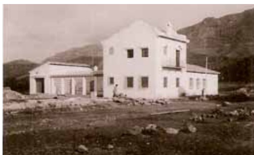
FIG. 7/ Casa del Guarda en construcción.
