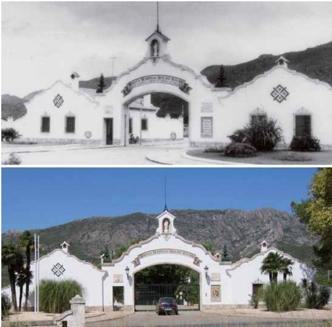
FIG. 1/ Entrada al conjunto. Origen y estado actual.
