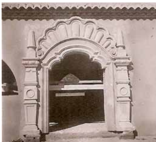
FIG. 8/ Casa del Guarda en construcción.
