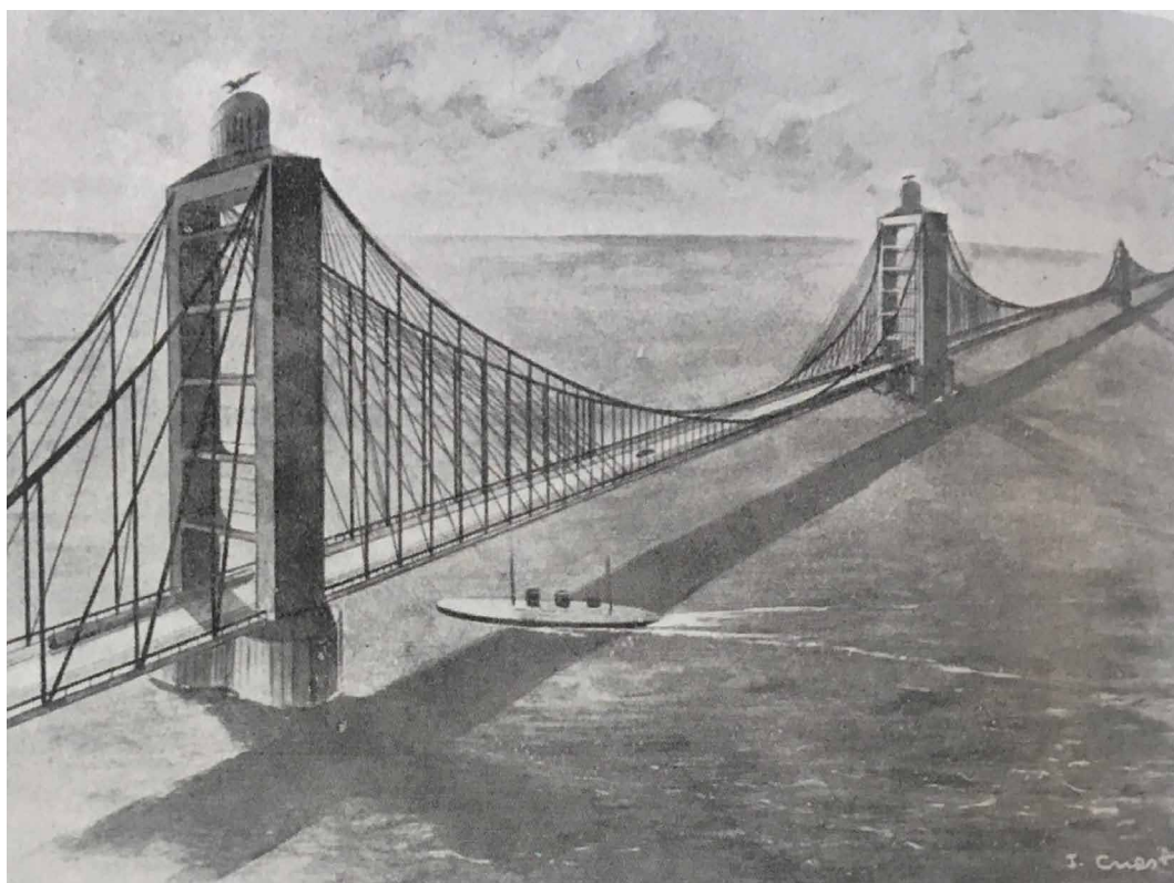
Fig. 6/ Boceto del posible puente colgante sobre el Estrecho de Gibraltar propuesto por Peña Boeuf.
