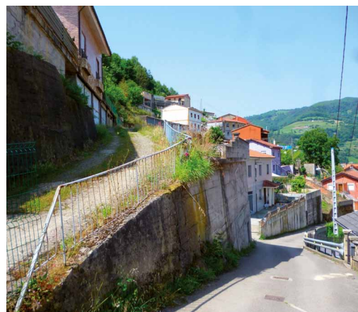
Fig. 9/ Rampas y muros de contención en Aguáin.
