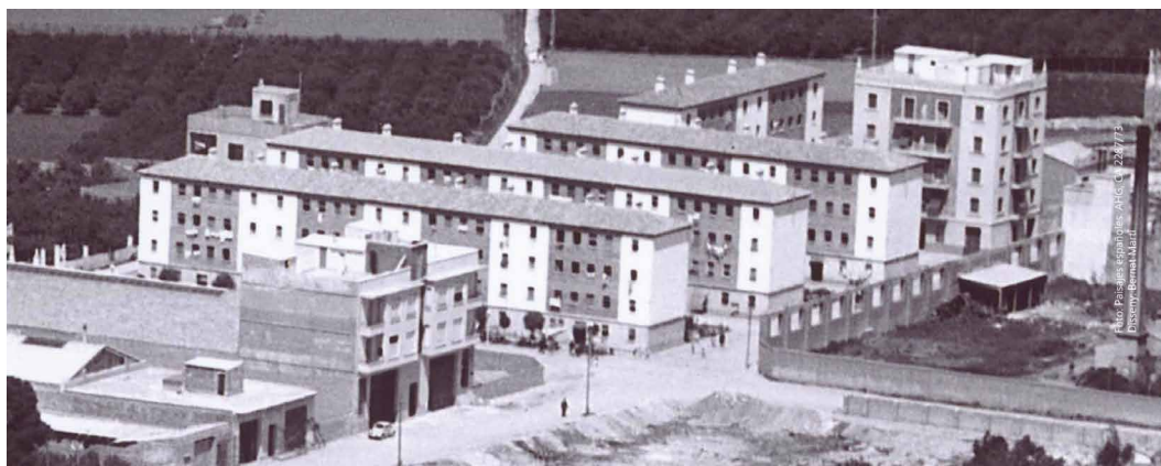
FIG. 13/ Finalización de las obras. Año 1950.
