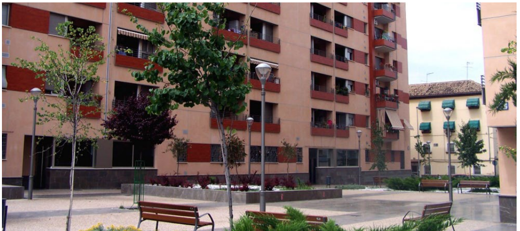
FIG. 5/ Imagen de los nuevos edificios y espacios libres del barrio de Santa Adela.
