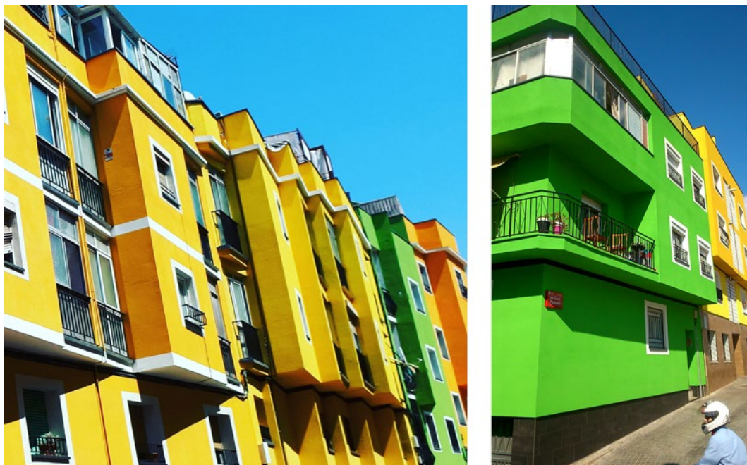
Fig. 7/ Rehabilitación de envoltantes e imagen urbana de la intervención en Santa Coloma de Gramenet.
