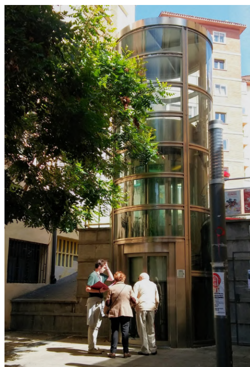
FIG. 3/ Ascensor en el barrio de La Milagrosa (Pamplona), calle Isaac Albéniz
