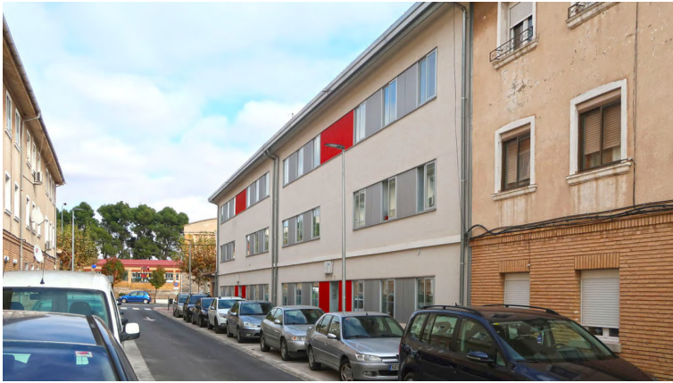
FIG.6./ Resultados de la rehabilitación de los edificios piloto en los Bloques de los años 50.
