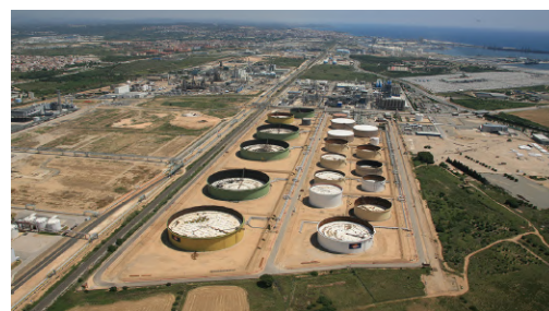
FIG. 1/ Vista aérea oblicua, de oeste a este, del polígono industrial “Entrevías” y del clúster químico, el puerto y los barrios del Ponent de Tarragona.
