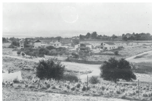
FIG. 7/ El Pinar de La Muela, suelo urbano “consolidado por la edificación”.
