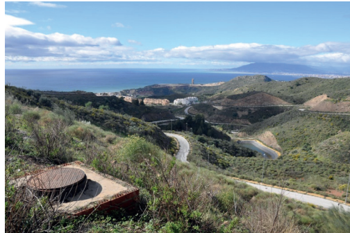
FIG. 2/ Urbanización Parque Victoria (cuencas de los arroyos Piletas y Polo Zamora).
