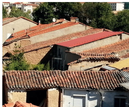
FIG. 2/ Antiguos corrales. Arquitectura tradicional en Cabañales.
