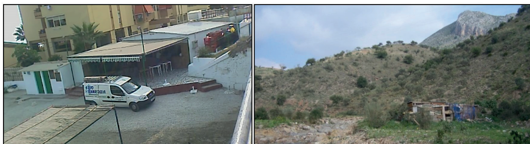
FIG. 7/ Imágenes de un local de restauración en el mismo cauce del arroyo Granadillo, en Rincón de la Victoria (izda.) y de una edificación precaria en la llanura de inundación del arroyo Jaboneros (dcha.).
