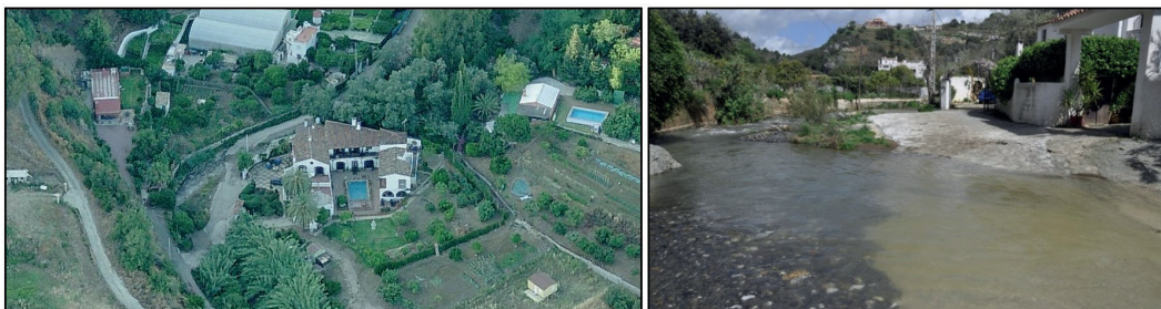
FIG. 6/ Imagen área de una antigua casa-cortijo reconvertida en hotel rural, en la cuenca del Río de la Cala. En una de las visitas de campo, el hotel rural aparecía incomunicado por la crecida del río, al existir una única vía de salida.
