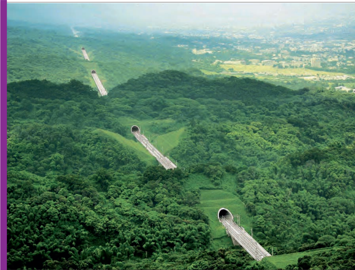
La línea taiwanesa Taipei-Kaohsiung discurre en su tramo norte a través de 49 kilómetros de túneles construidos para salvar una complicada orografía.
