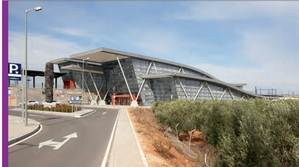
Estructura de la estación Antequera-Santa Ana (arriba) y fachada de la estación de Málaga.
