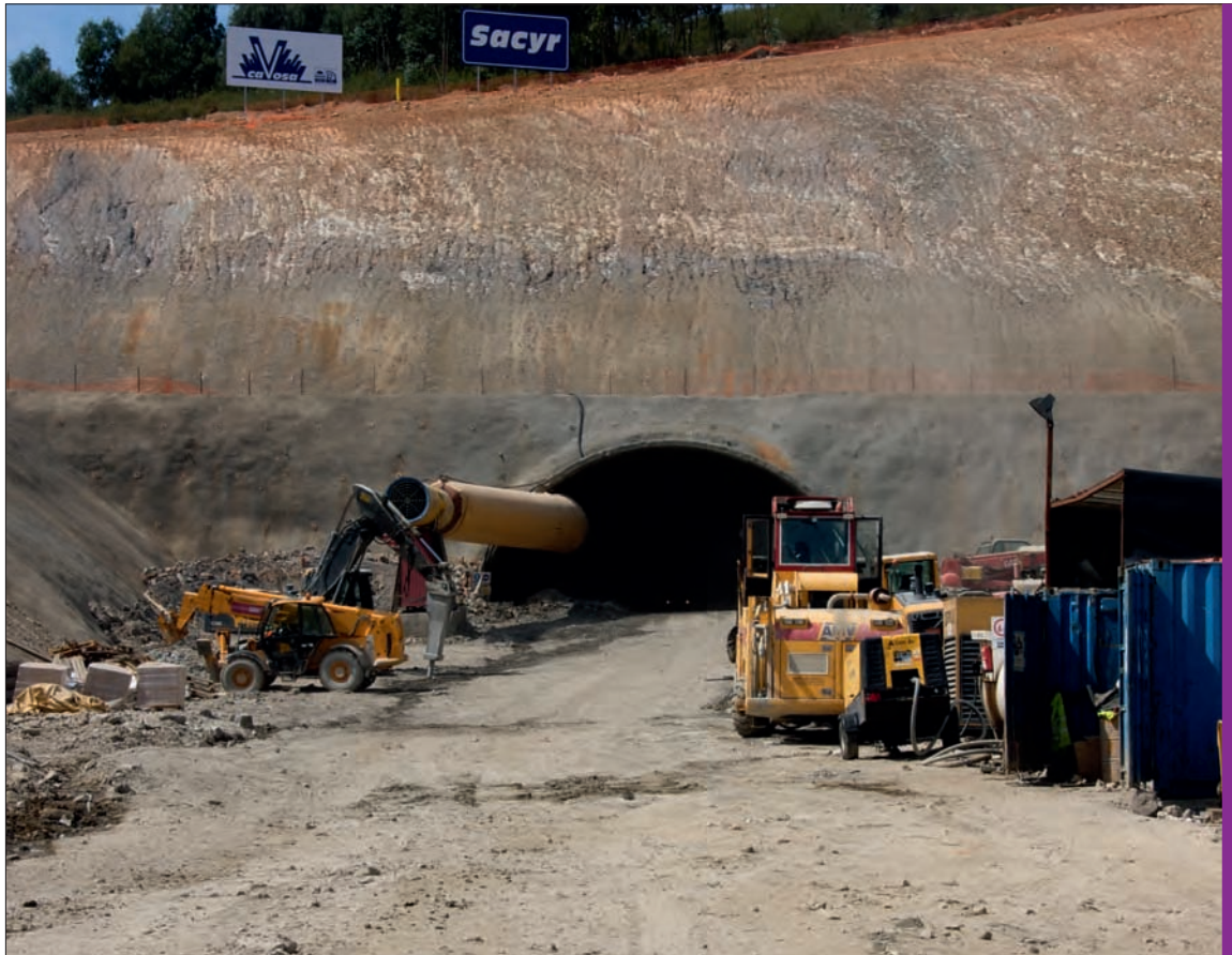
Boca del túnel de Puente Viejo (1.000 metros) bajo la sierra de San Pedro, uno de los escasos subterráneos de la línea.
