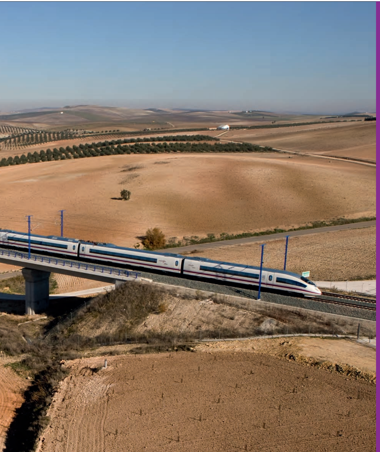
Un tren S 103 circula sobre un viaducto de la línea Córdoba-Málaga, en servicio desde finales de 2007.
