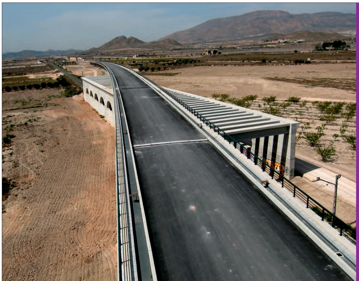
Cruce de vías a distinto nivel mediante una pérgola en el subtramo Monforte del Cid-La Alcoraya, cerca de Alicante. Debajo. viaducto del Vinalopó, de 1.481 metros de longitud, en el subtramo Elda-Monóvar.
