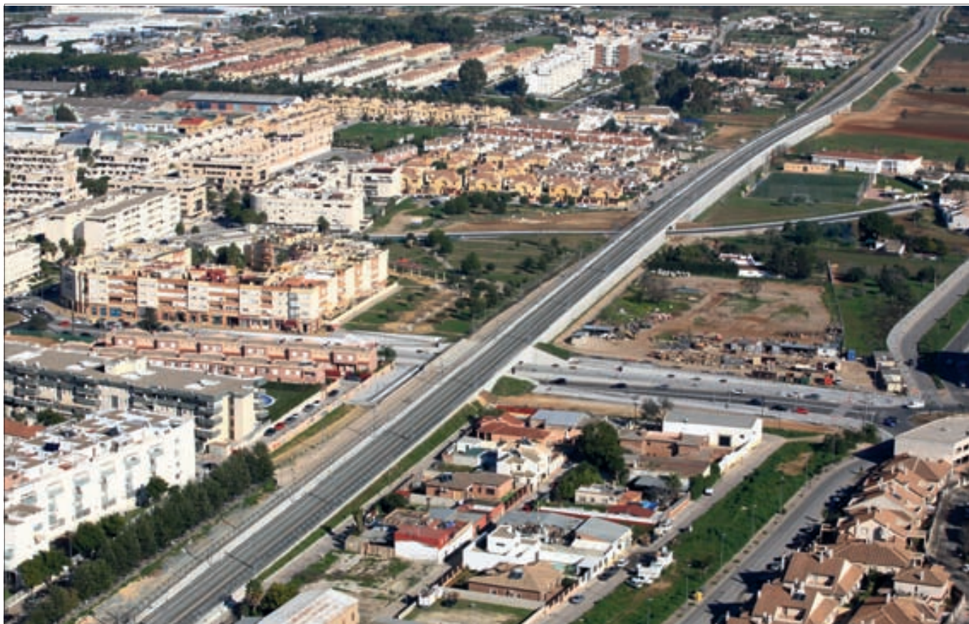
El tramo más urbano se desarrolla sobre terraplén o viaductos. Foto inferior, paso superior de Guadalquivir, en el origen del subtramo.
