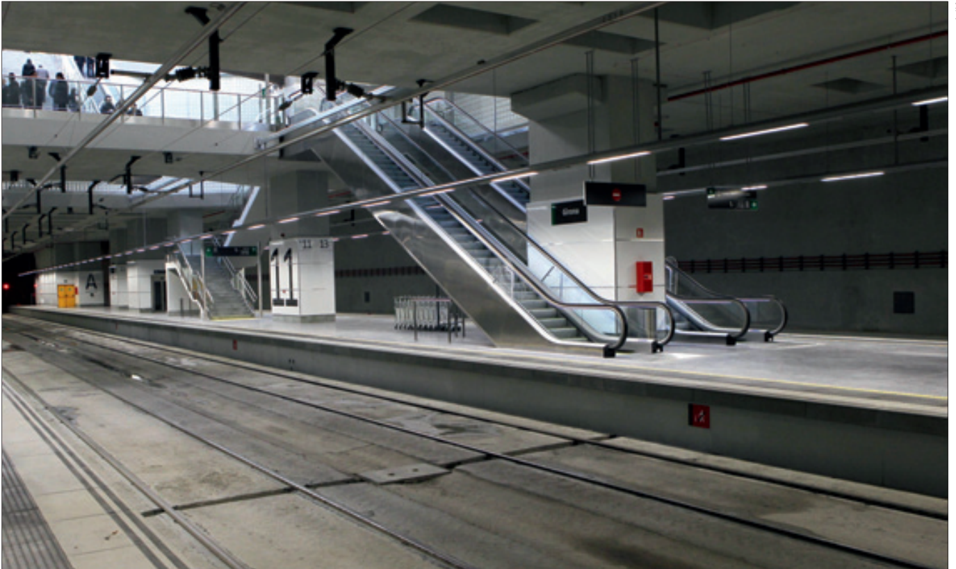
► Vías y andenes de la estación de alta velocidad de Girona, estructura dividida en cuatro niveles.
