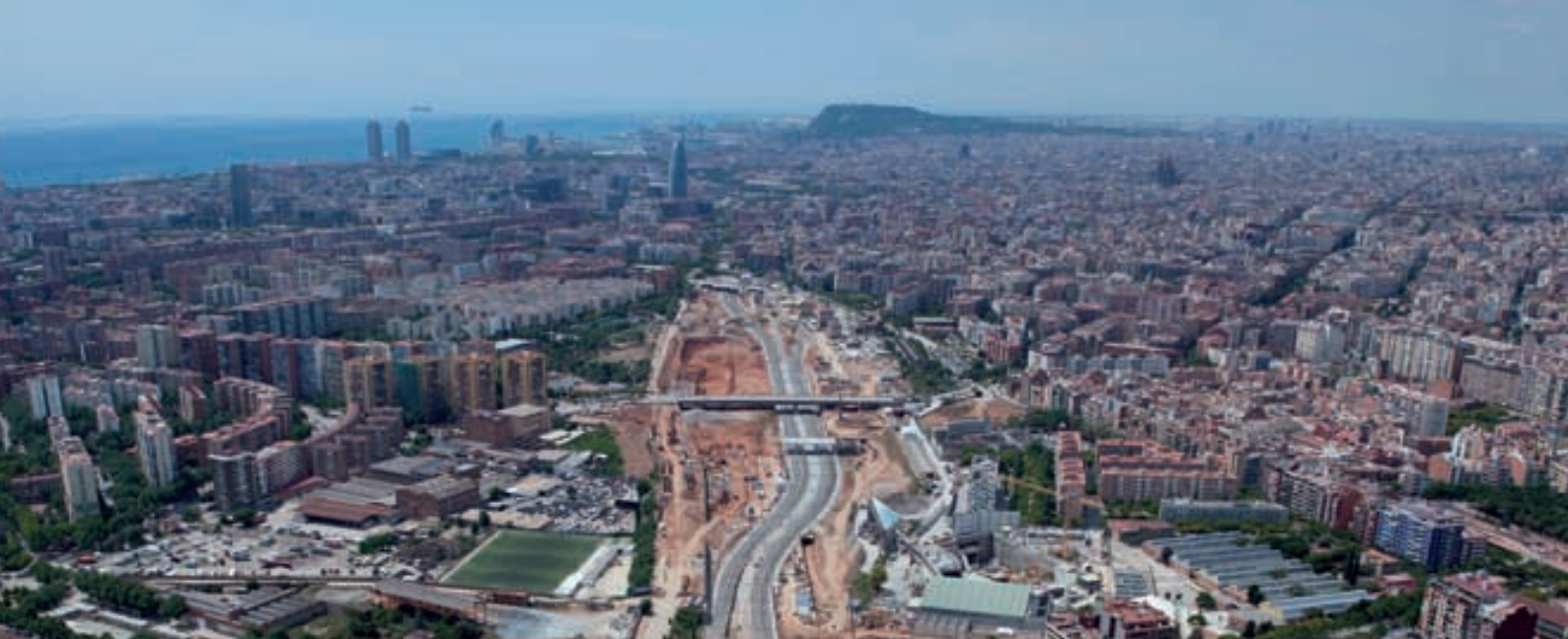
Construcción de los accesos a la estación de La Sagrera, Barcelona.
