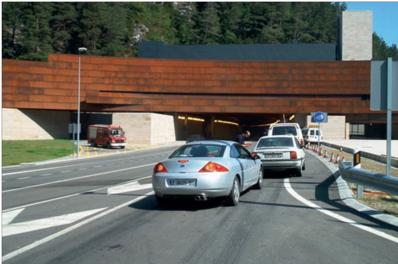
Vehículos accediendo por la boca española del túnel.
