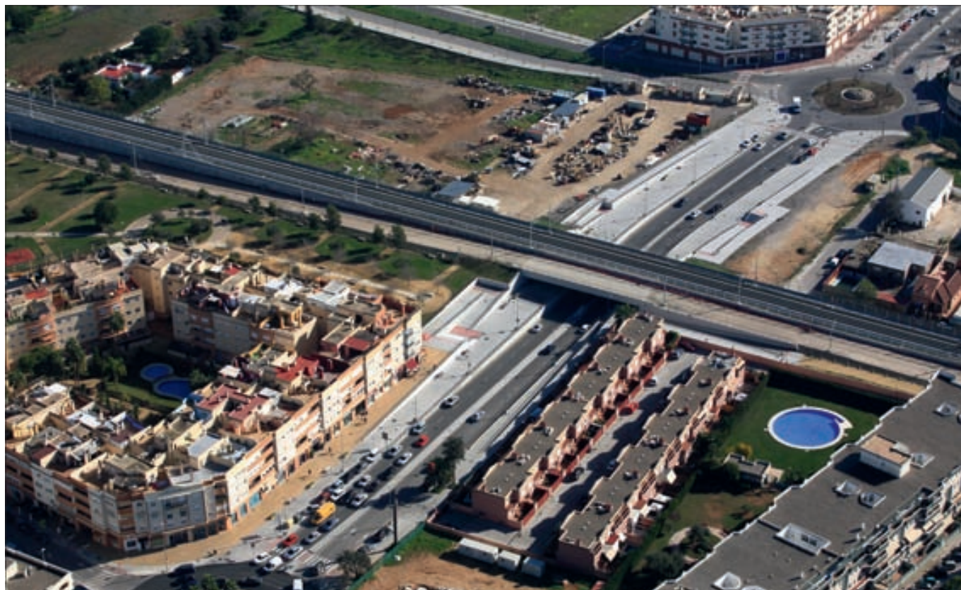
▮ Viaducto sobre uno de los nuevos viales en Jerez de la Frontera. Debajo, tren de la línea de Cercanías Cádiz-Jerez.
