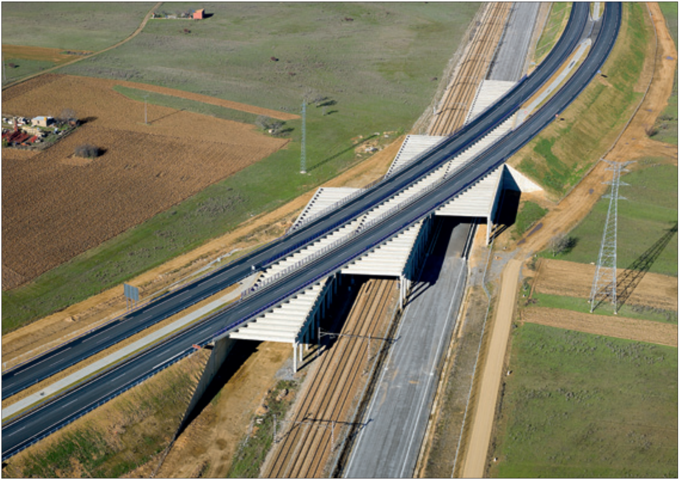
► Pérgola de tres vanos, de 300 metros de longitud, que salva la línea férrea convencional y su ampliación y la línea de alta velocidad.
