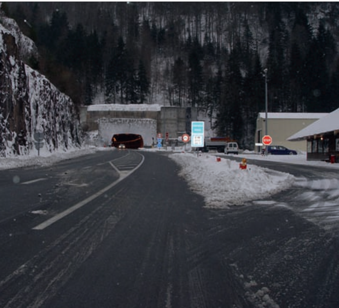
► Vista de la boca francesa del túnel de Somport y su carretera de acceso, la RN-134.
