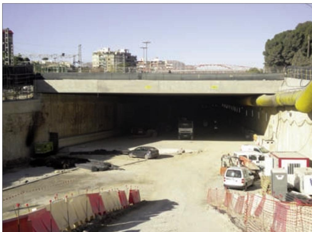
► *Boca del cajón soterrado en Alicante, estructura ya construida y actualmente en fase de equipamiento interior.*
