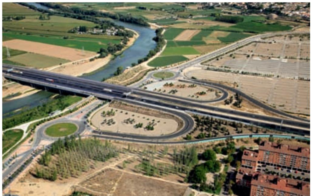
► La remodelación del enlace de Ranillas ha incluido la construcción de dos puentes sobre el Ebro paralelos a los existentes.
