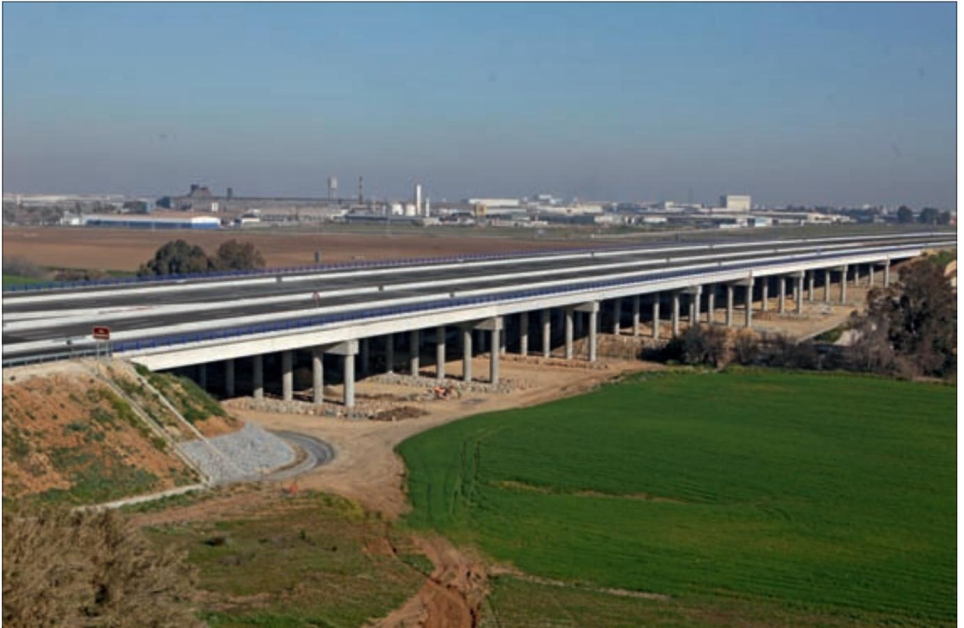
► Vista lateral del viaducto sobre el río Guadaíra, cuyo tablero se apoya sobre pilas circulares de tipo pórtico.
