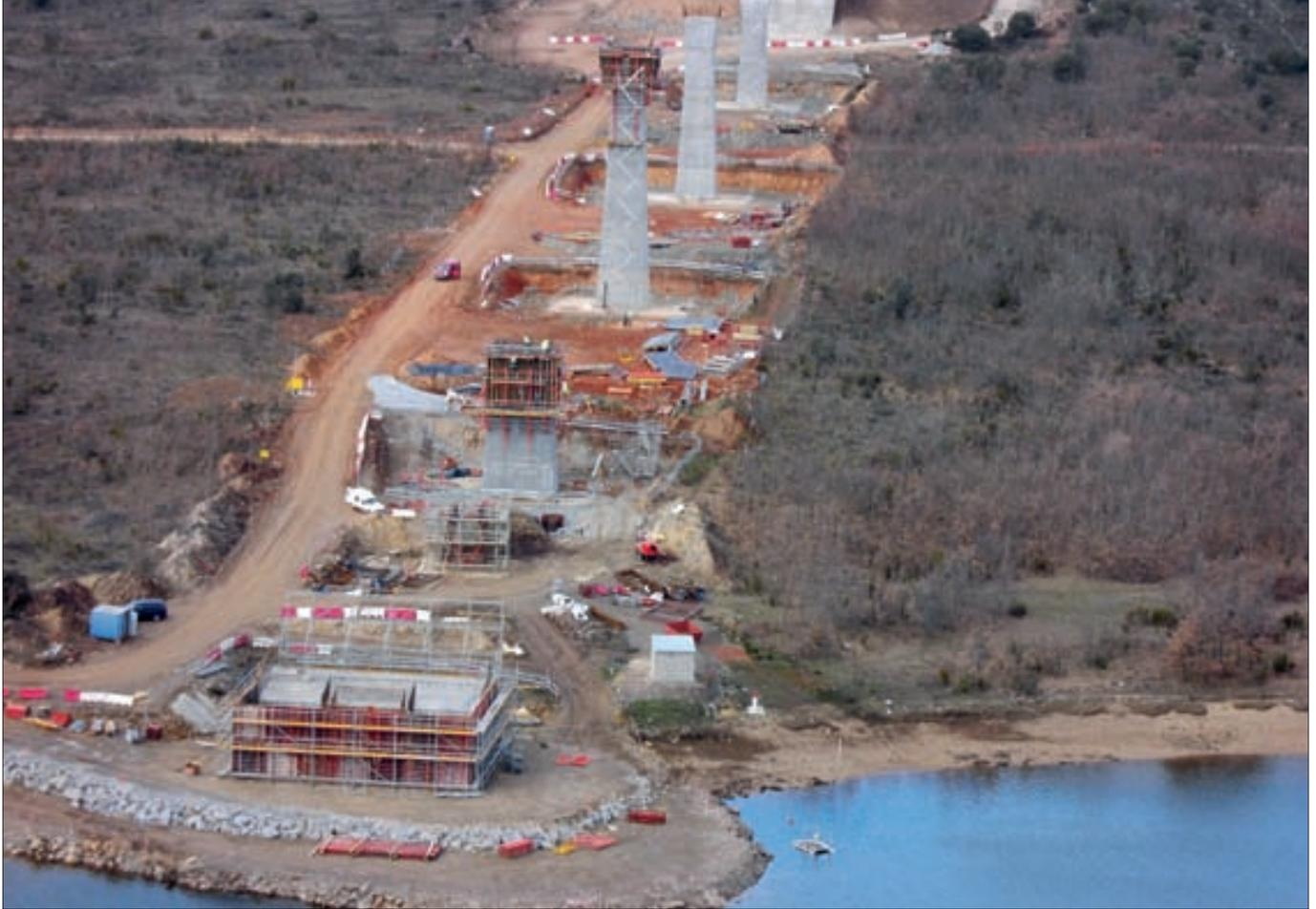
► Ejecución de pilas del viaducto sobre el río Tera (700 metros de longitud), en el subtramo Otero de Bodas-Cernadilla (Zamora).
