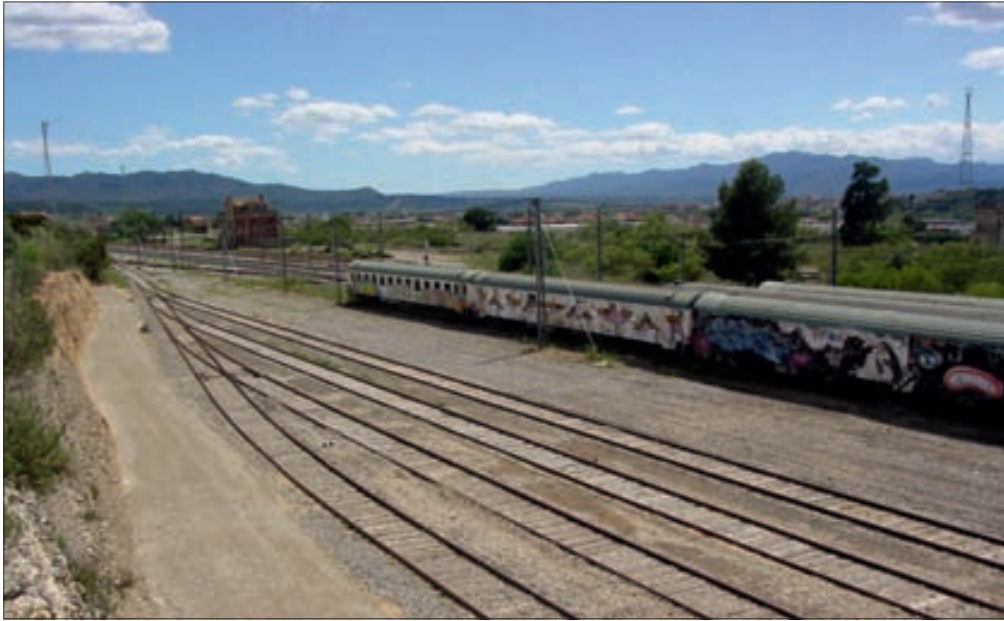
De arriba abajo, las cuatro vías que conducen a la cochera, torre de enclavamiento y autoridades sobre un tren durante la inauguración.
