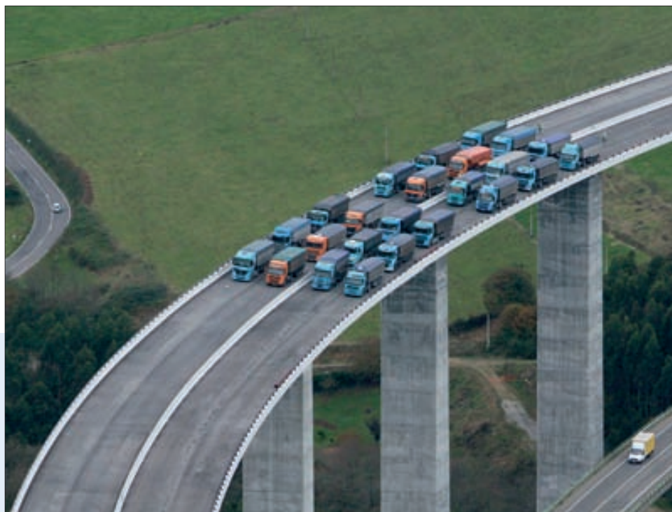
Ampliación del tablero del viaducto mediante carro portaencofrados y prueba de carga del viaducto con camiones.
