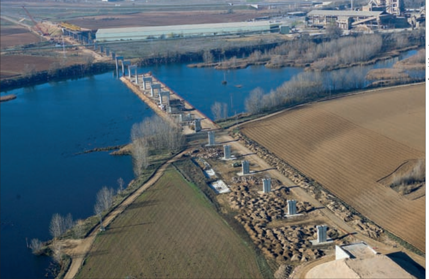
▶ Ejecución del tablero del viaducto sobre el río Pisuerga (1.128 metros) en el ramal Valladolid-Burgos del Nudo de Venta de Baños (Palencia).
