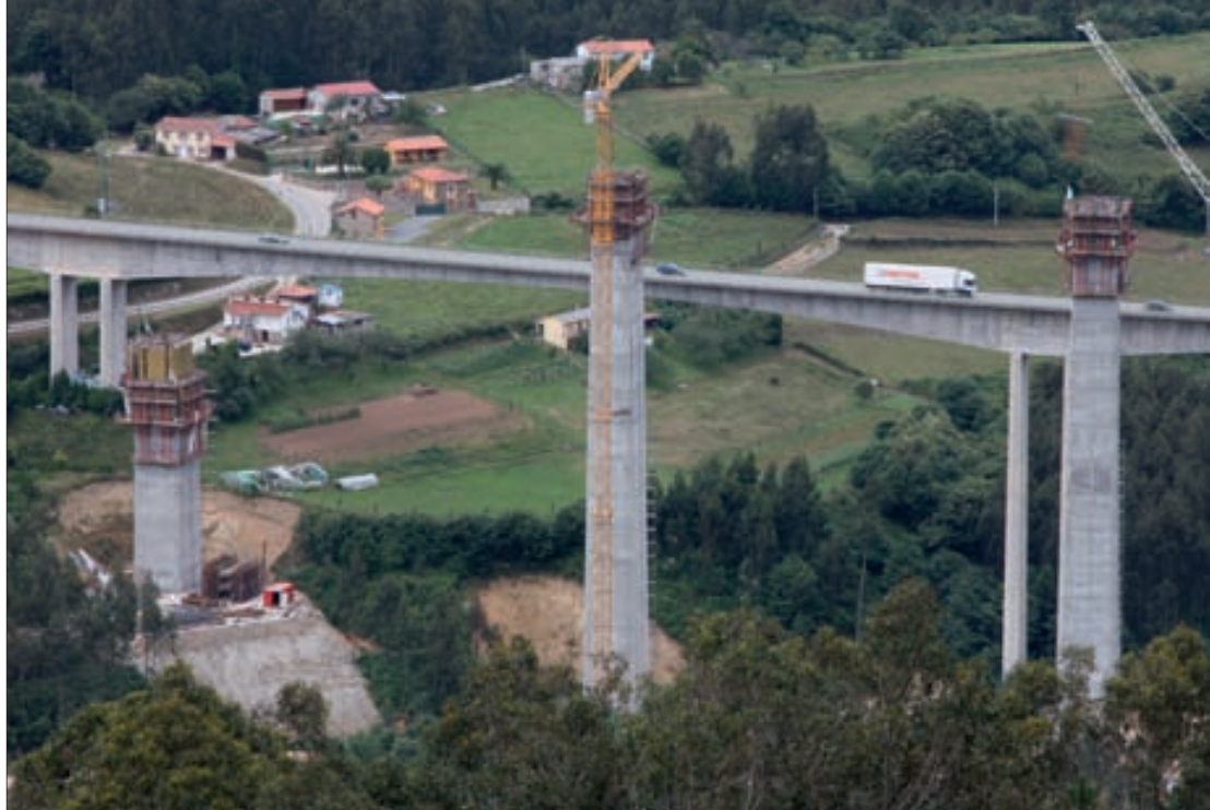
► Ejecución de pilas del viaducto y colocación de dovelas mediante cimbra autolanzable.
