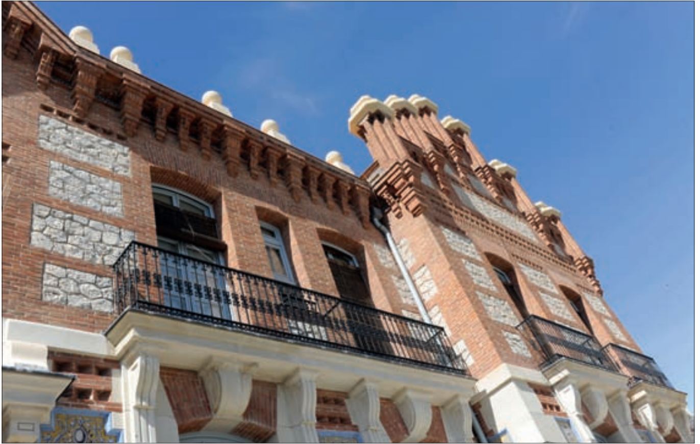
► La fachada de la estación ha sido sometida a una limpieza en seco y se han recuperado o sustituido los elementos en mal estado.
