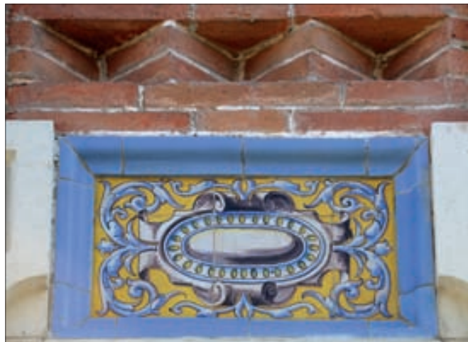
► Detalle de la azulejería de la estación de Aranjuez.
