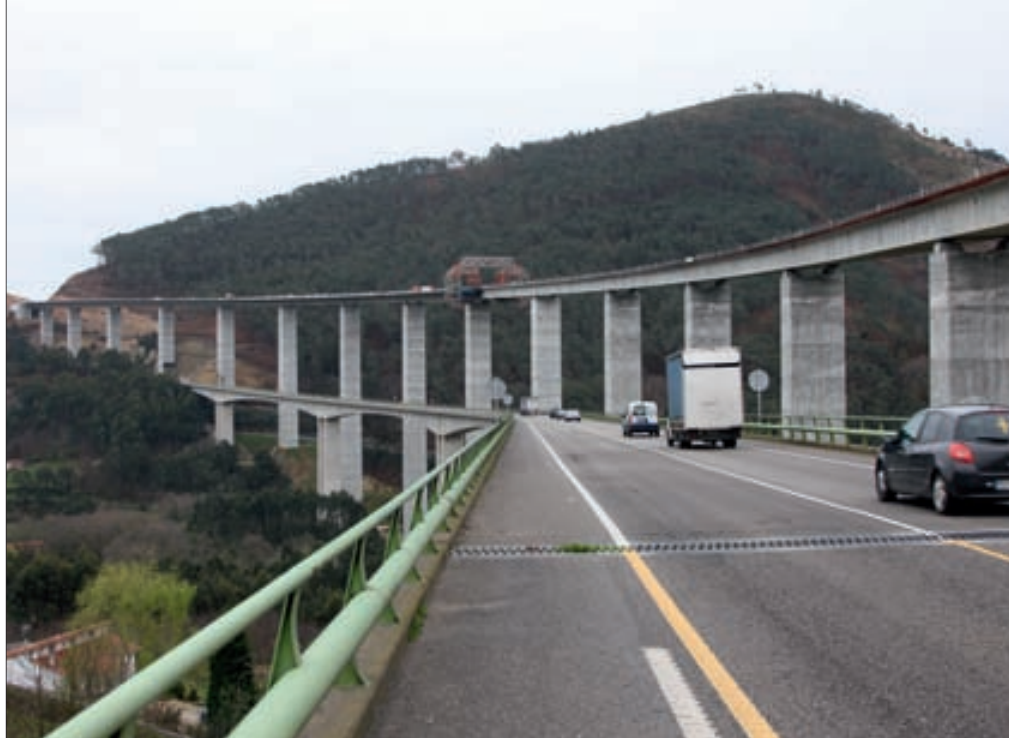
► Vista del nuevo viaducto de la autovía desde el existente en la carretera nacional N-632.
