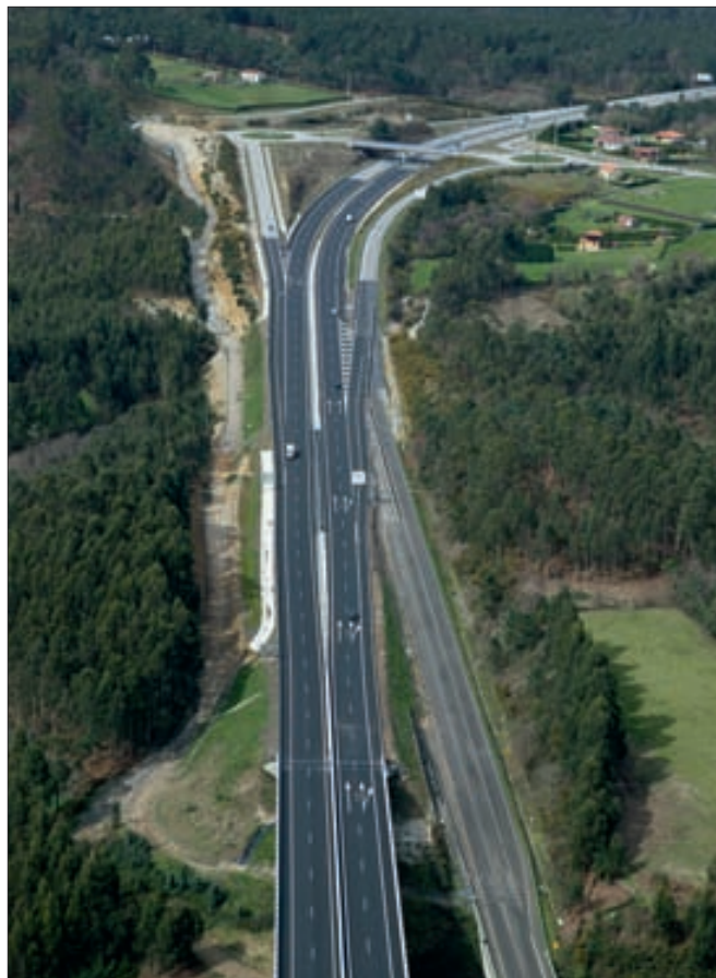
▸ Conexión del nuevo tramo con el contiguo Novellana-Las Dueñas.
