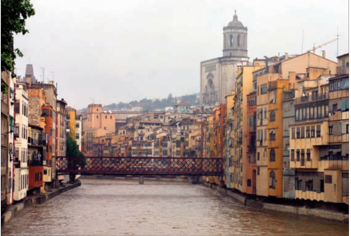
► Las viviendas con más de 50 años de antigüedad deberán superar a partir de 2019 un Informe de Evaluación de los Edificios.
