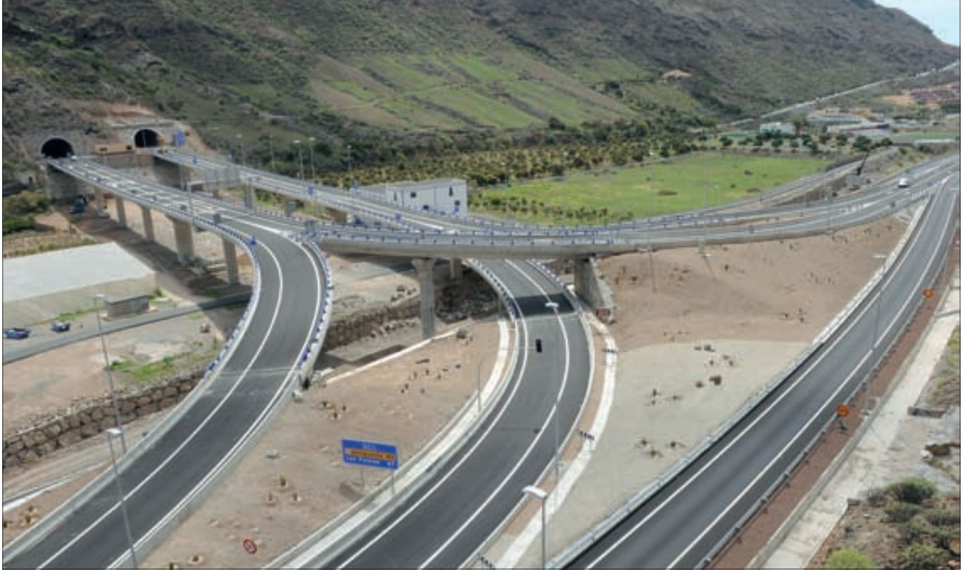
▶ A la salida del túnel de Mogán se encuentra el enlace final del tramo, con varias estructuras a distinto nivel para conectar con la carretera GC-200.
