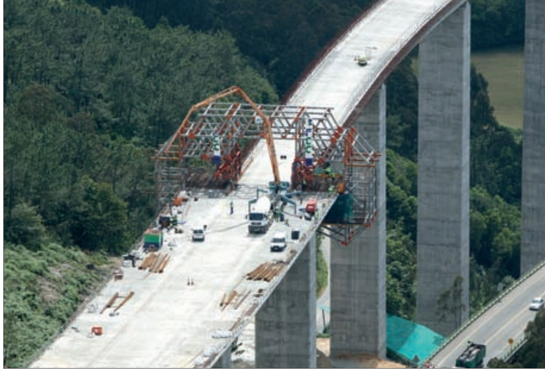
Ampliación del tablero del viaducto mediante carro portaencofrados y prueba de carga del viaducto con camiones.
