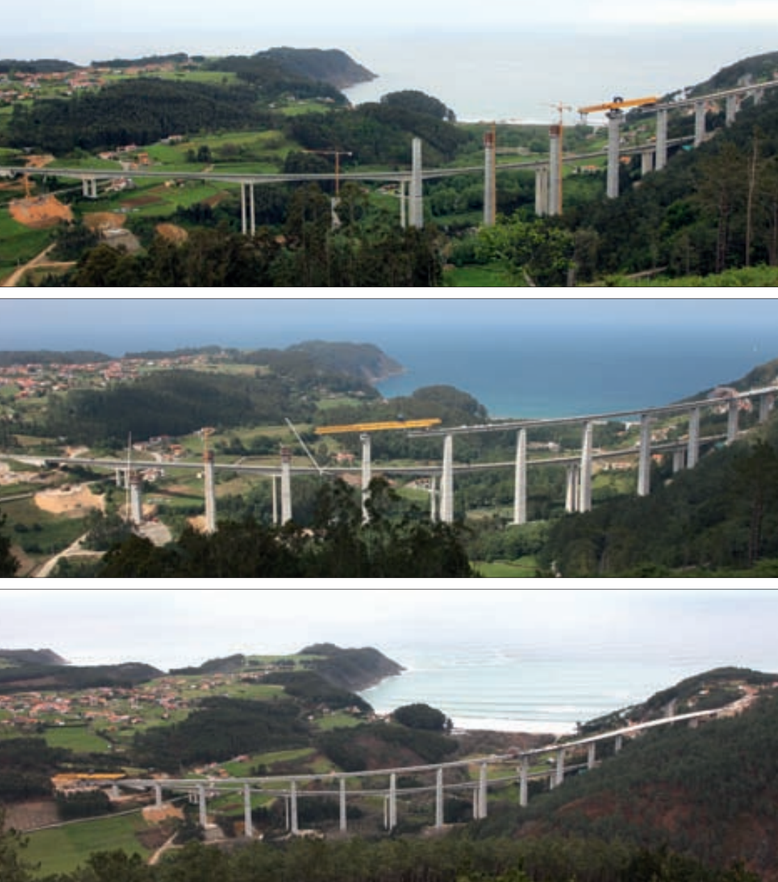
► Secuencia de fases de la construcción del viaducto de la Concha de Artedo.
