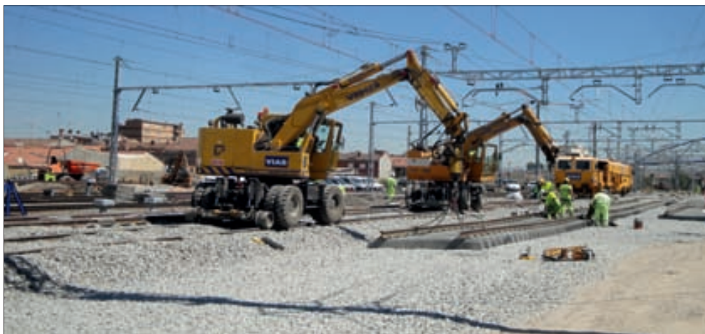
Trabajos de montaje de vías convencionales en la estación de Venta de Baños.
