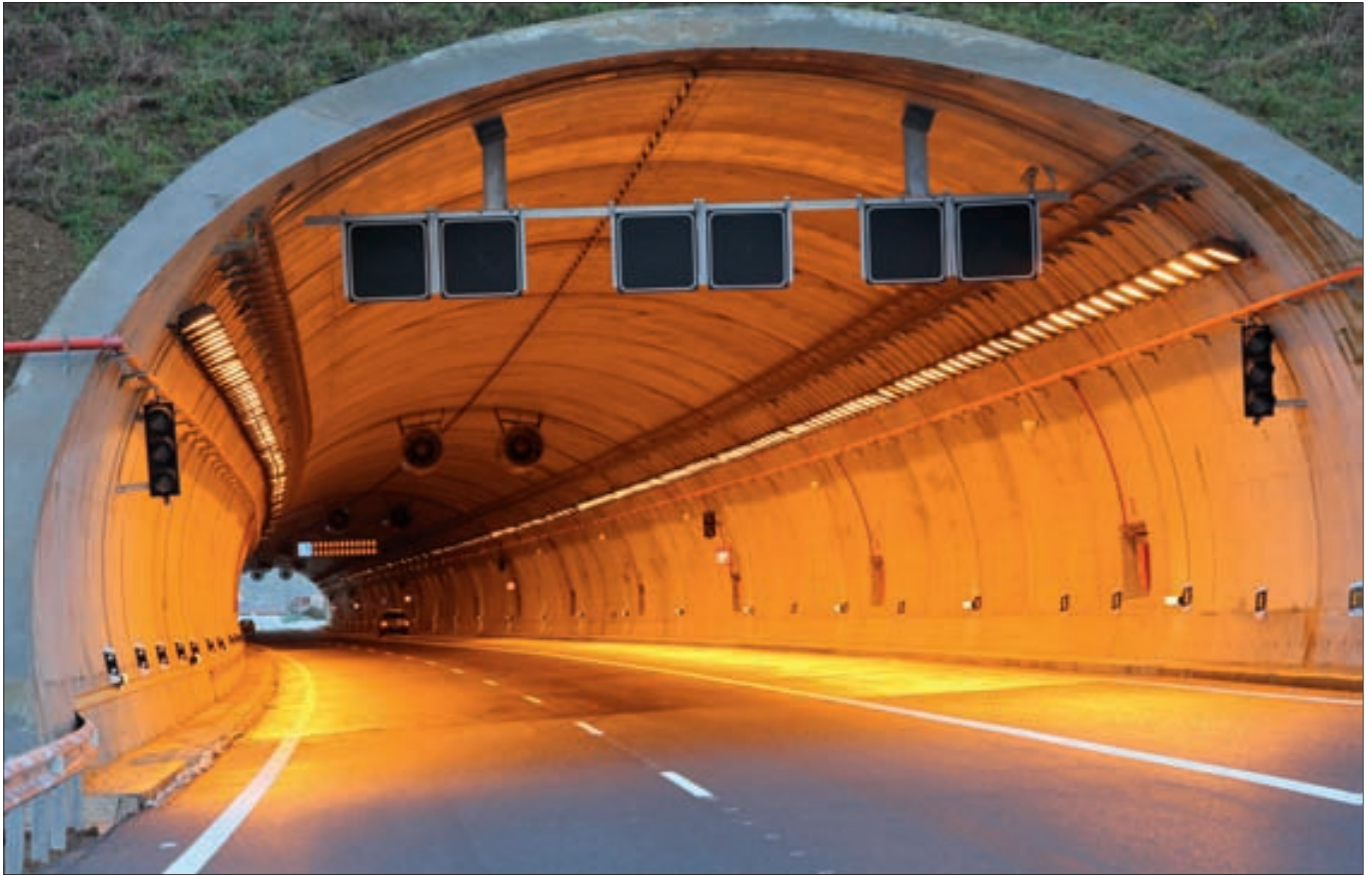
▮ Túnel de San Juan, de 280 metros de longitud, uno de los dos construidos en el trazado. Debajo, viaducto de Piñera.
