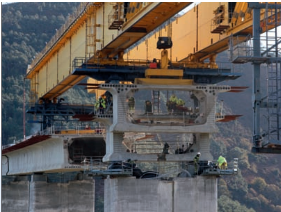
► Ejecución de pilas del viaducto y colocación de dovelas mediante cimbra autolanzable.
