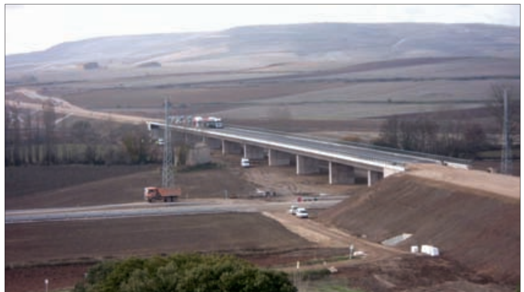
Prueba de carga del viaducto de Hormazueta, en el subtramo Villazoque-Estépar (Burgos).
