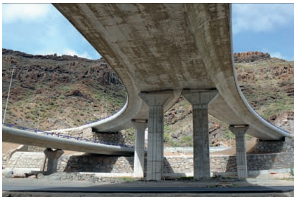
▶ Enlace de tipo trompeta en el barranco de Taurito, entre las bocas de los túneles de Tauro y Taurito. Debajo, vista inferior del viaducto final del tramo.
