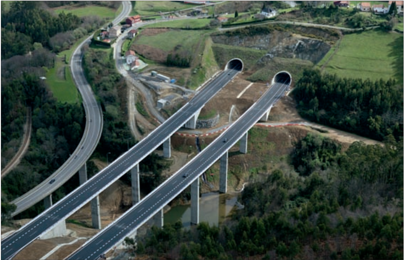
▸ Viaducto de Santa Olaya y boca del túnel de Somao, con la carretera nacional N-632 a la izquierda.
