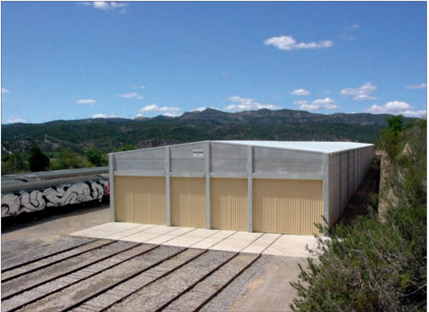
► La nueva cochera-taller es una nave de 3.250 m 2 de superficie donde se estacionan y rehabilitan los trenes históricos.
