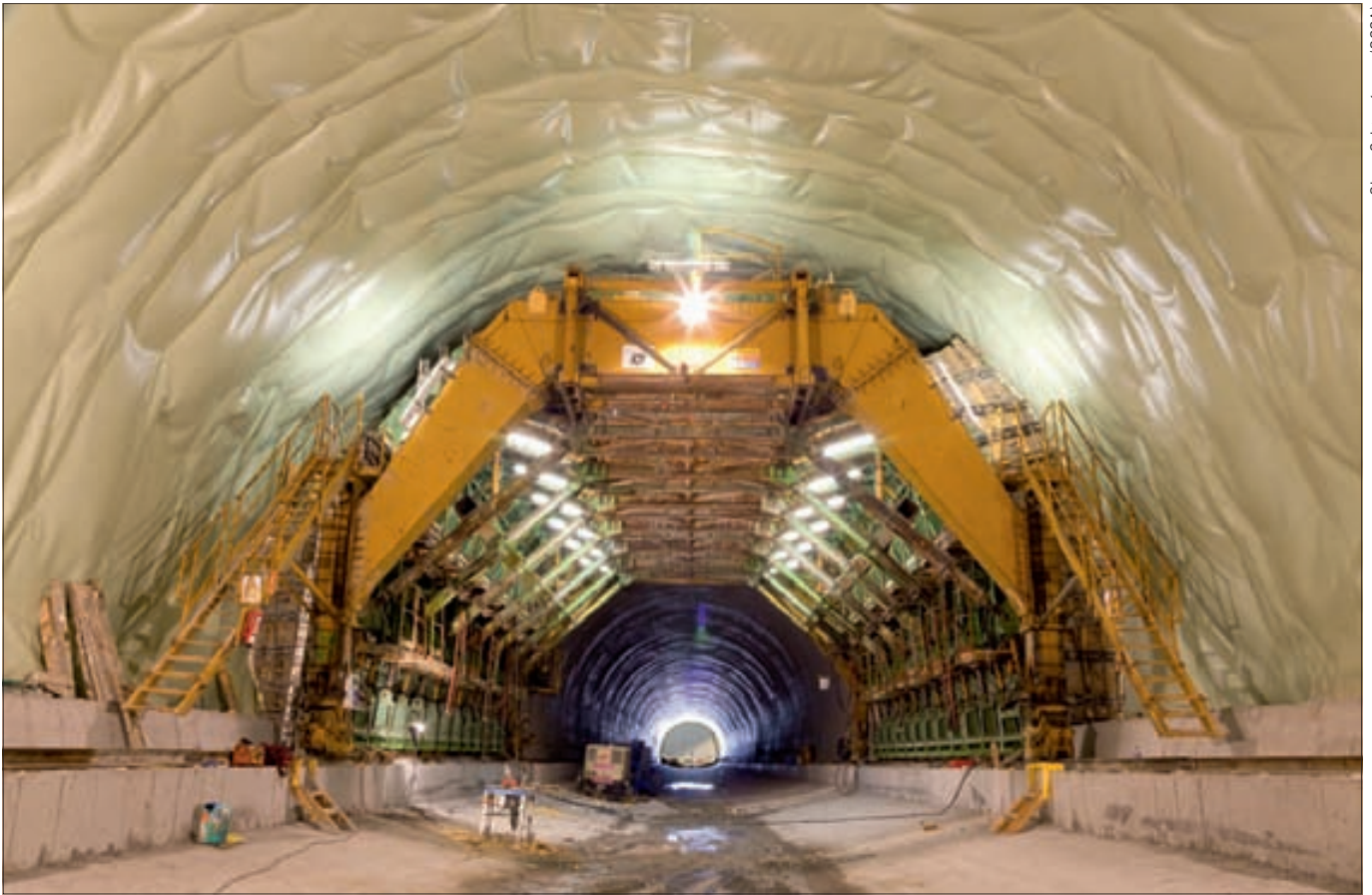
► Revestimiento del túnel de Udalaiz, segundo más largo del eje Vitoria-Bilbao, en el tramo Mondragón-Elorrio.
