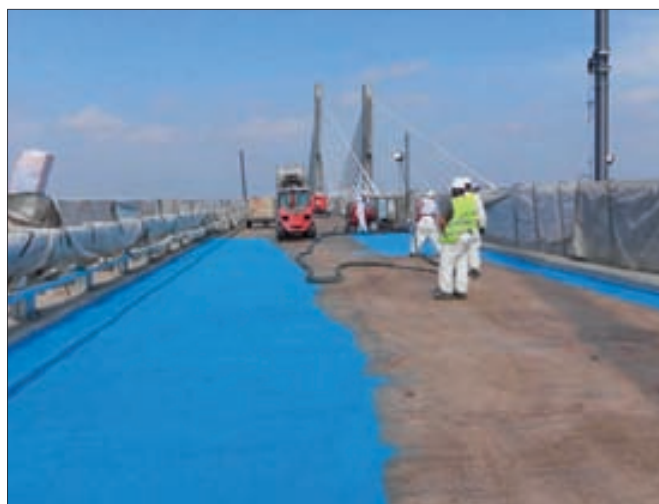
► Vista general, montaje de vías y trabajos en el tablero del puente.
