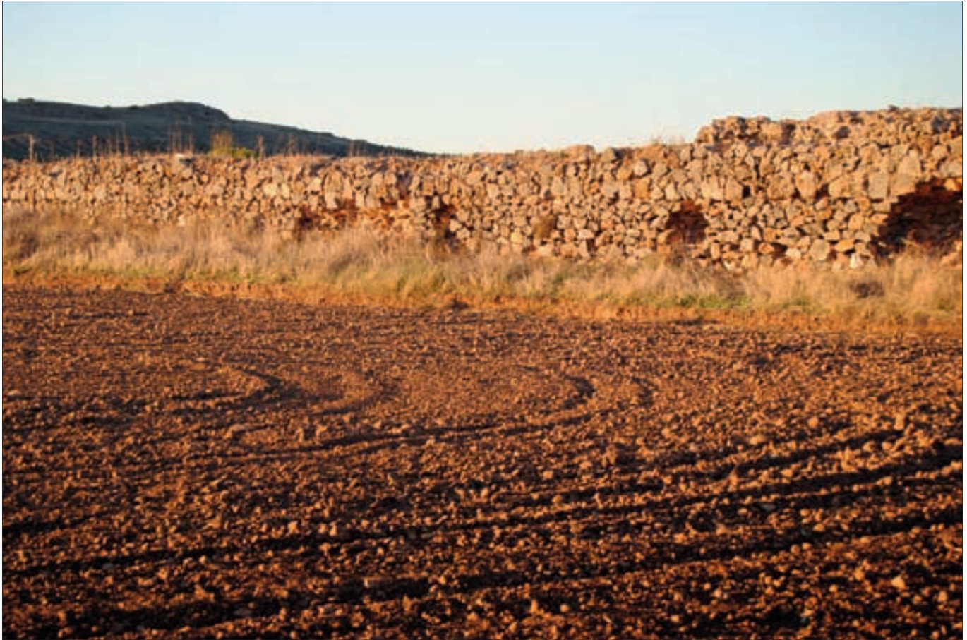
▮ Arriba, muro de la presa, formado por mampostería en los paramentos y hormigón en el núcleo. Debajo, boca de uno de los aliviaderos de la presa.
