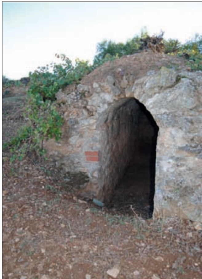
▮ Arriba, muro de la presa, formado por mampostería en los paramentos y hormigón en el núcleo. Debajo, boca de uno de los aliviaderos de la presa.
