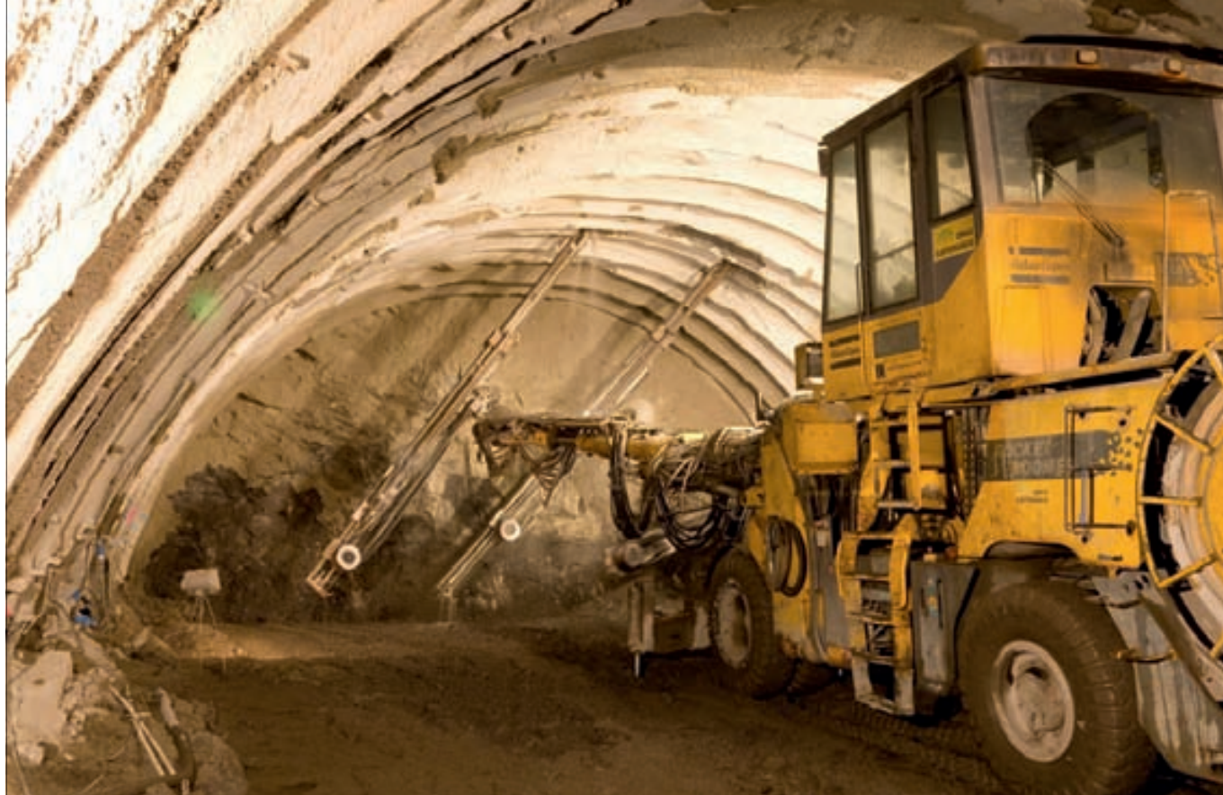
► Todos los túneles de la Y vasca se ejecutan según el nuevo método austriaco. En la imagen, excavación en avance del túnel de Udalaiz.
