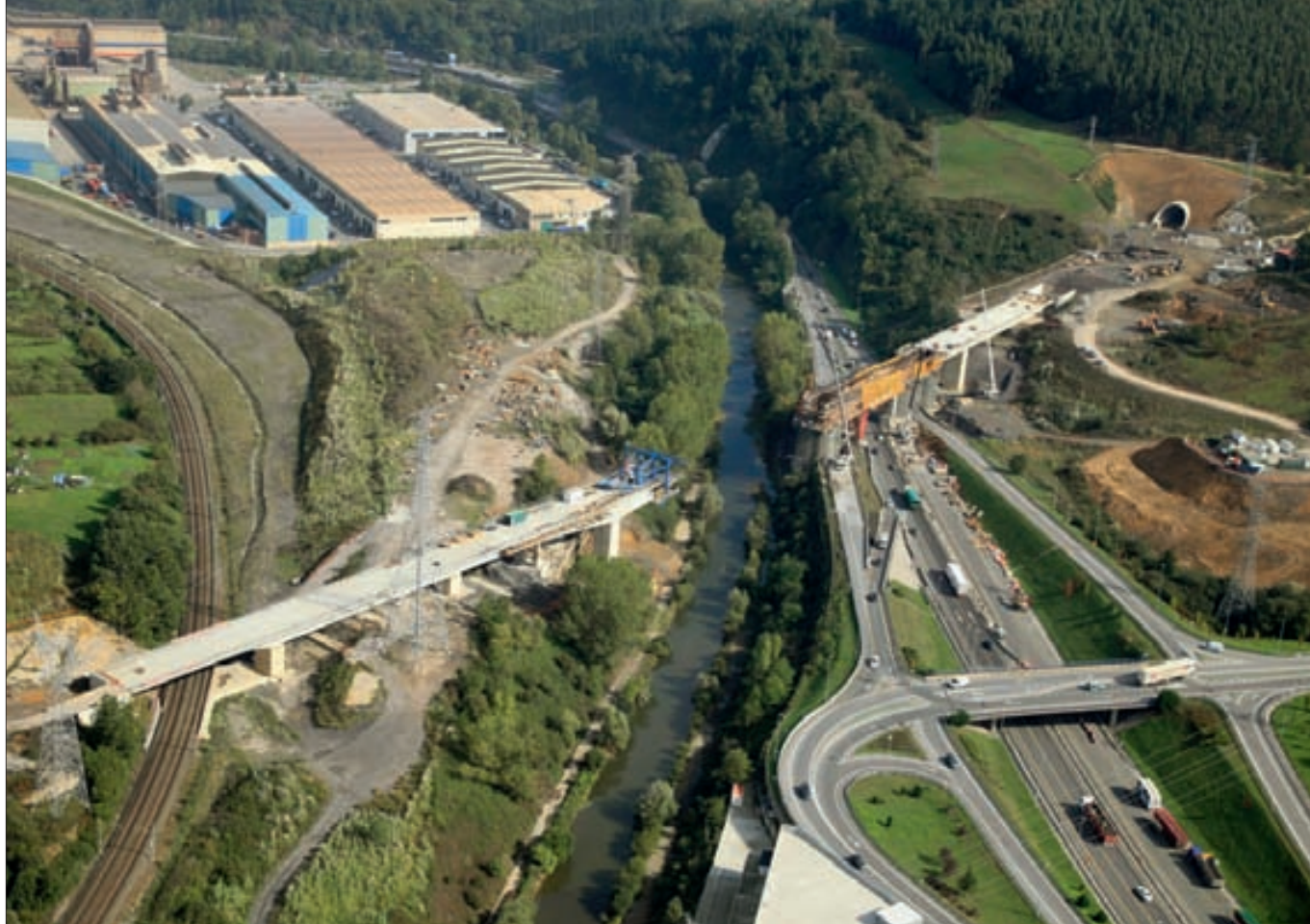
▶ Ejecución del viaducto (438 metros) sobre el río Nervión, la línea férrea Castejón-Bilbao y la carretera BI-625, en el tramo Galdakao-Basauri.
