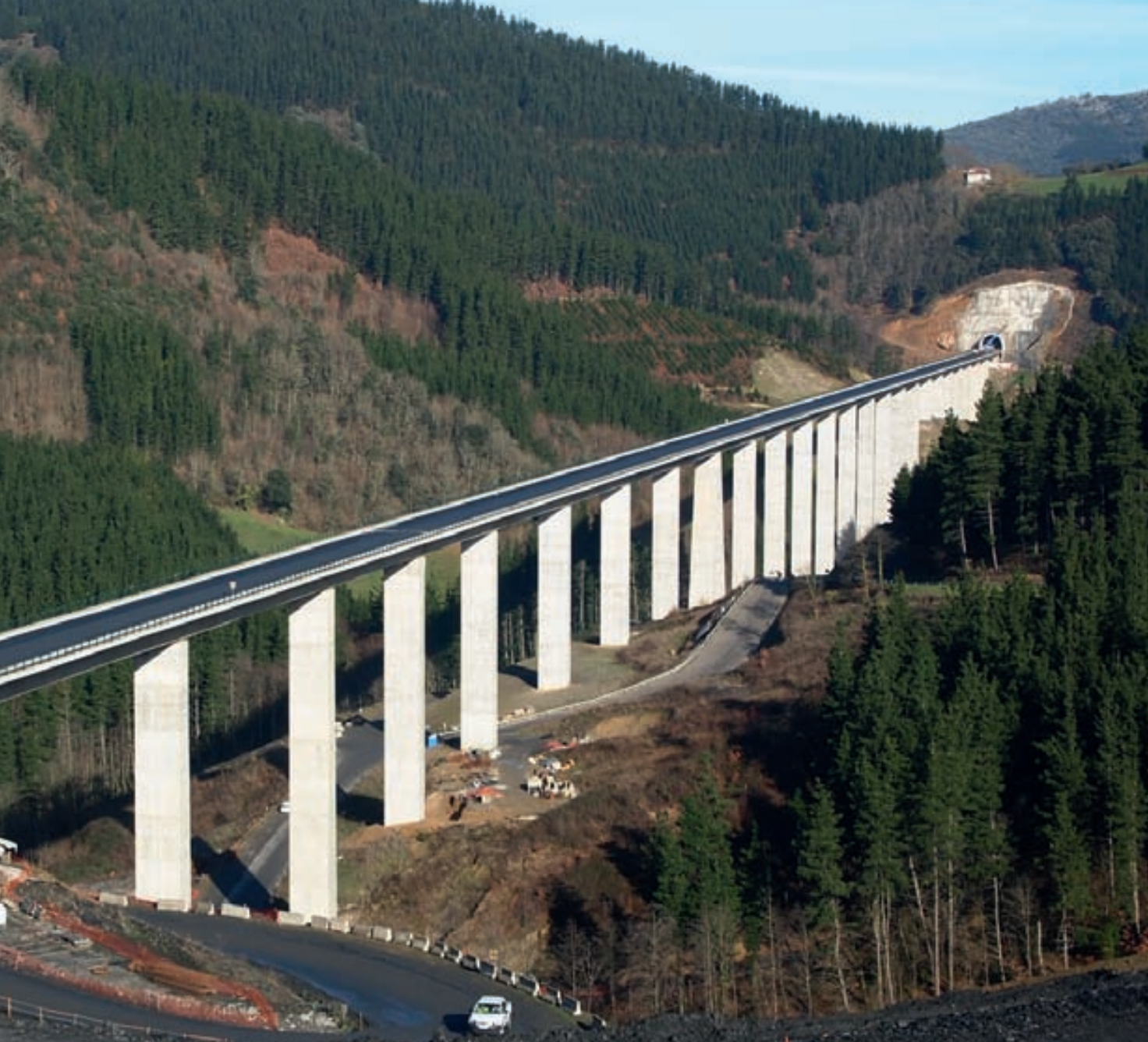
▮ Viaducto sobre la carretera A-2620, en el tramo Aramaio-Mondragón, de 1.392 metros de longitud y altura máxima de pilas de 83 metros.
