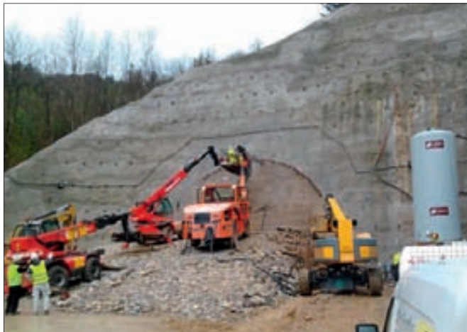
► Inicio de la excavación del túnel de Aduna.
