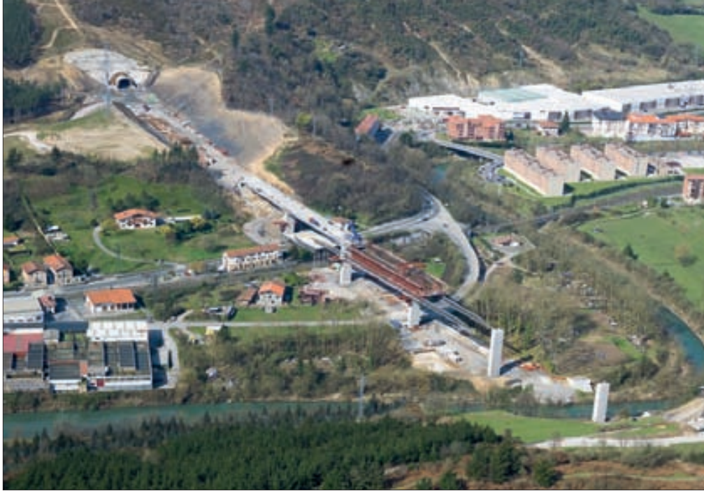
▶ Ejecución con cimbra autoportante del viaducto sobre el río Ibaizabal, en el tramo Amorebieta-Amorebieta.
