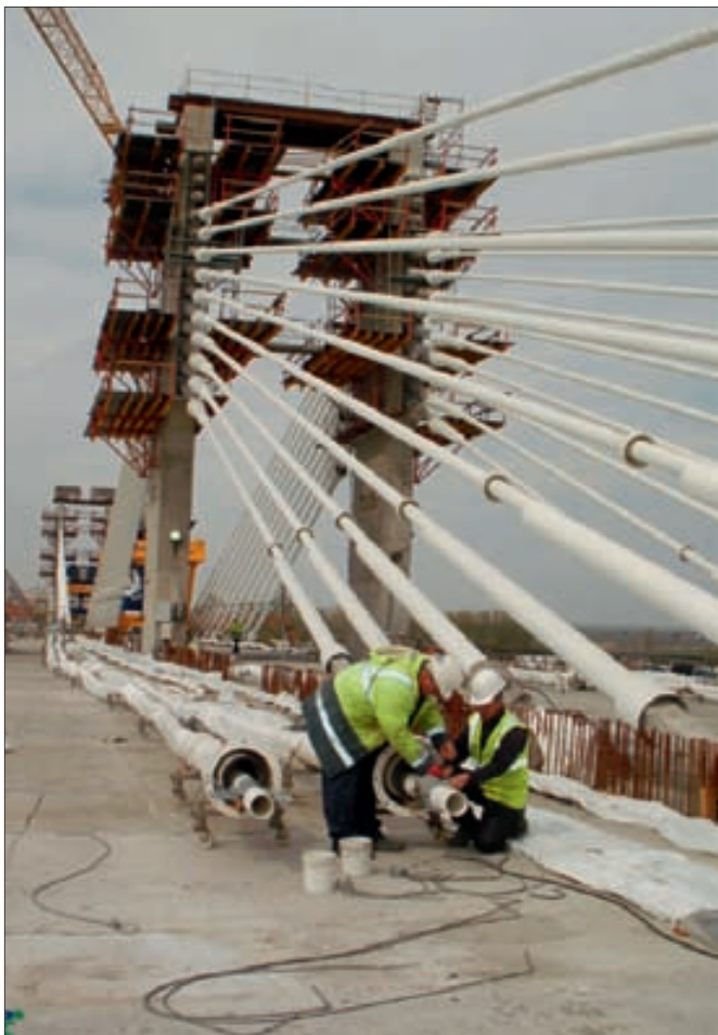
▶ Avance del tablero, traslado de dovela y montaje de tirantes.
