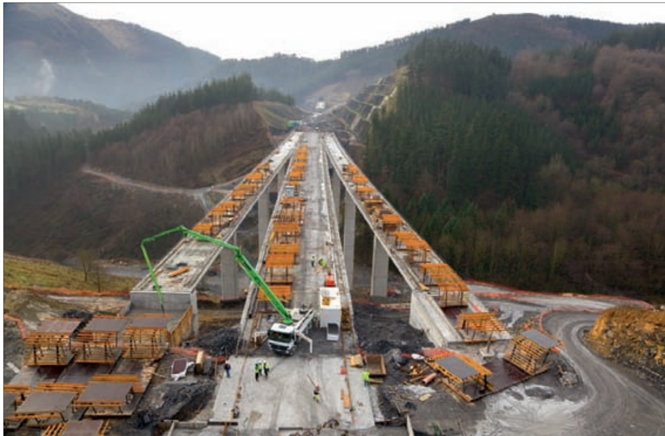
► Ejecución del viaducto de Gabandi, con tres tableros, en el tramo Mondragón-Elorrio.
