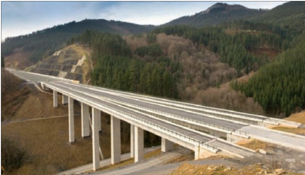
▶ Viaducto de Gabaundi, con una inusual disposición de tres tableros, en el tramo Mondragón-Elorrio.
