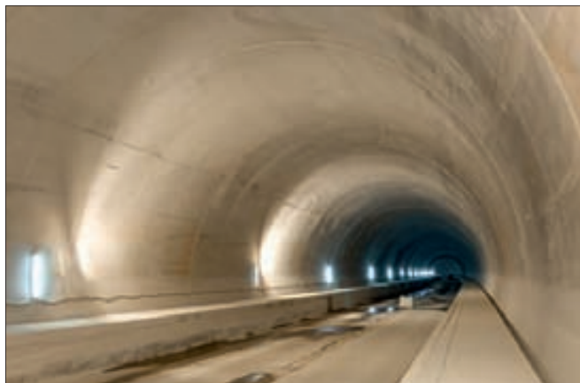
▶ Sección definitiva de 85 m 2 del túnel de Udalaiz.
