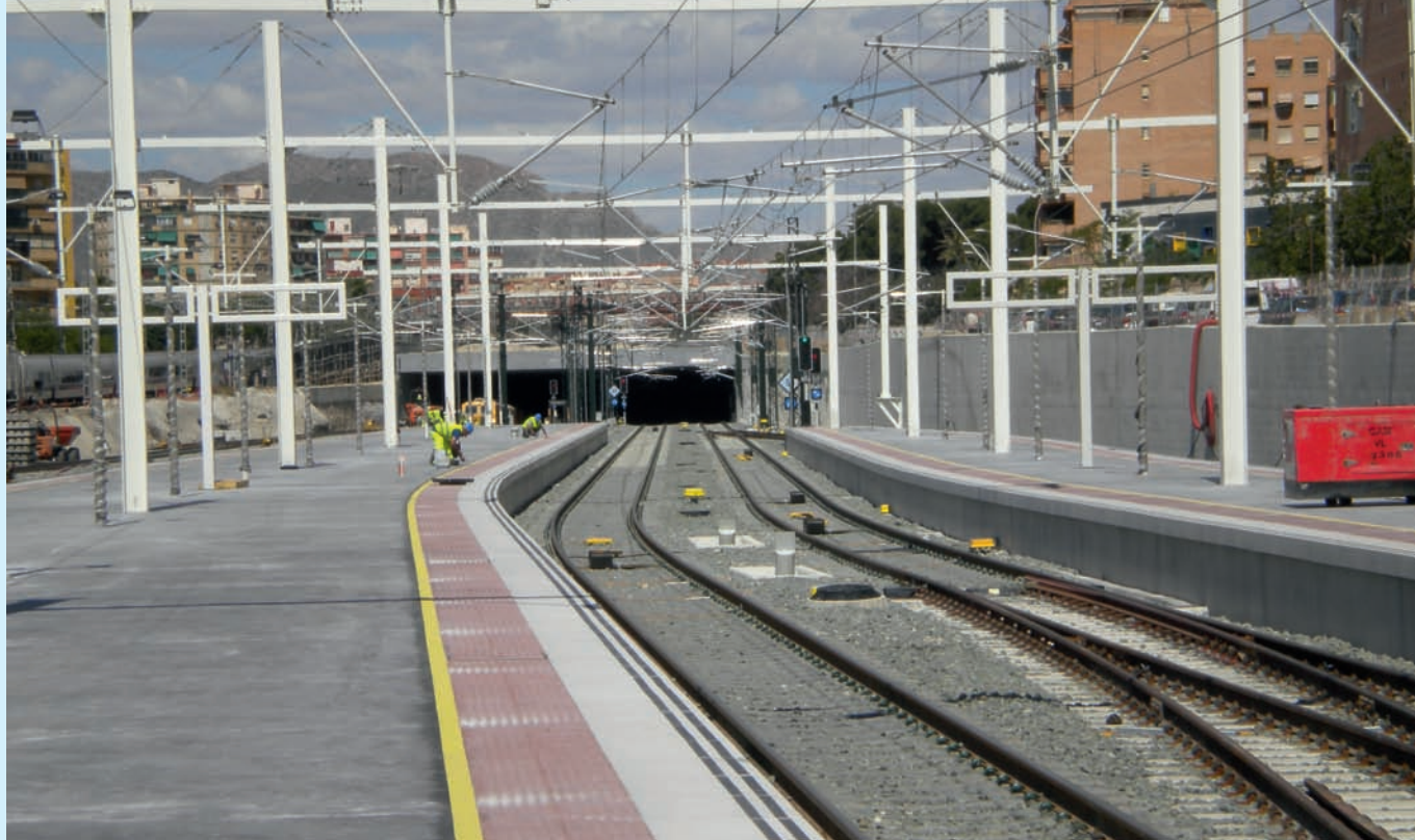
► Inicio del soterramiento de Alicante visto desde los nuevos andenes. Debajo, unidad de S 100 estacionada en la misma estación.
