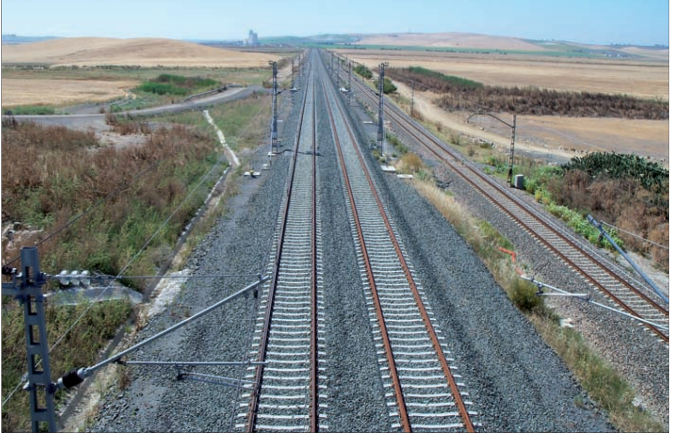
► Vista de la nueva plataforma con doble vía de alta velocidad en paralelo a la vía única de ancho convencional, ya sin servicio.
