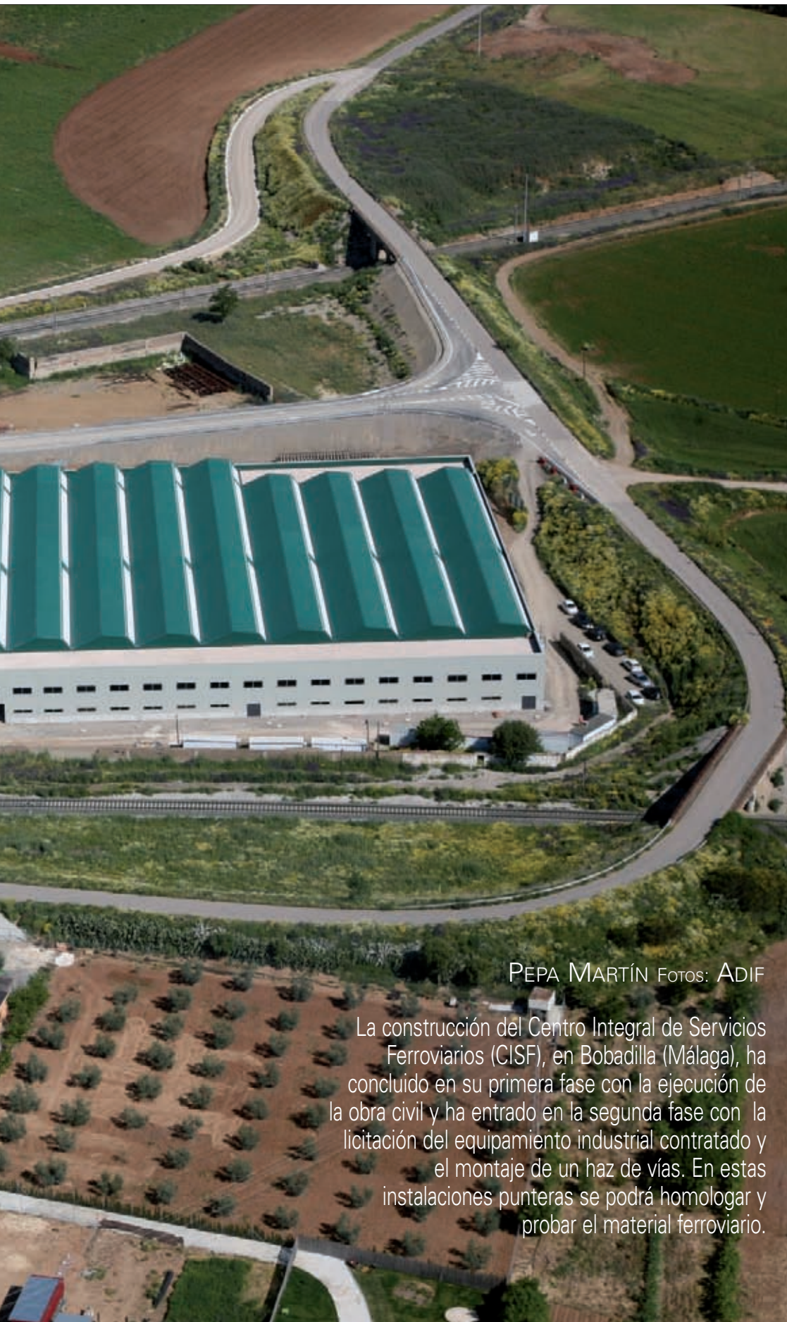
▮ Vista aérea de la nave principal del CISF, muy cerca de la estación de Bobadilla.
