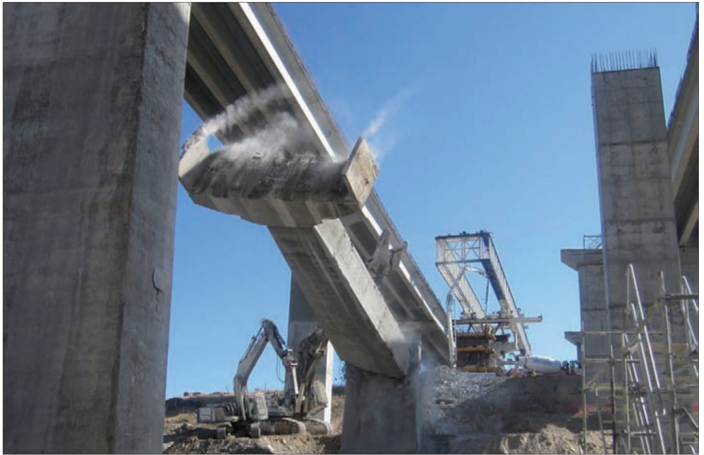
Demolición de pila de uno de los viaductos originales.
