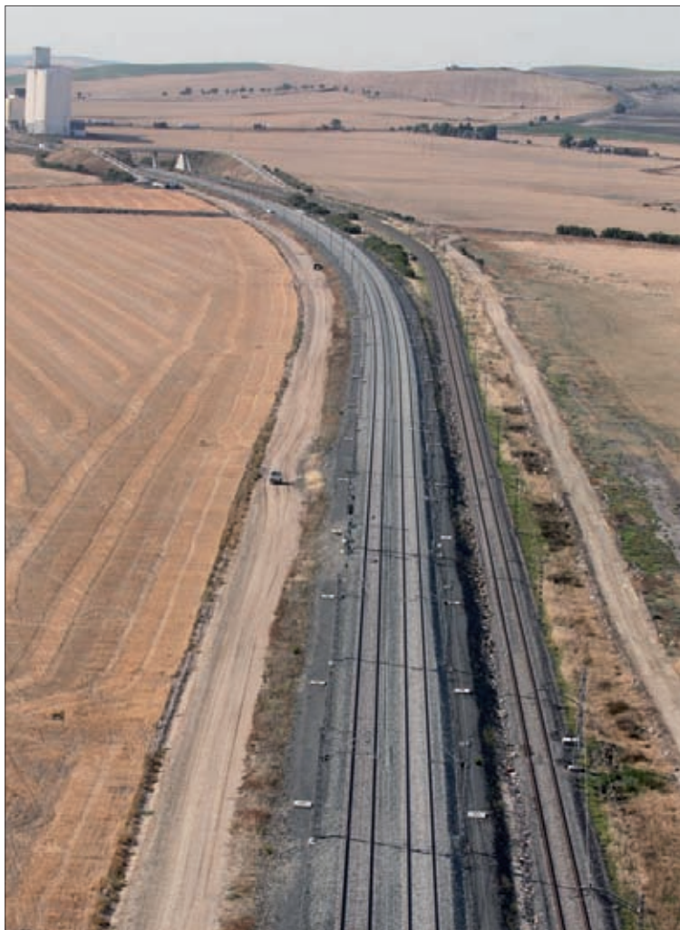
► La nueva plataforma ferroviaria discurre bien en variante (izquierda) o en paralelo al trazado de la línea convencional (derecha).
