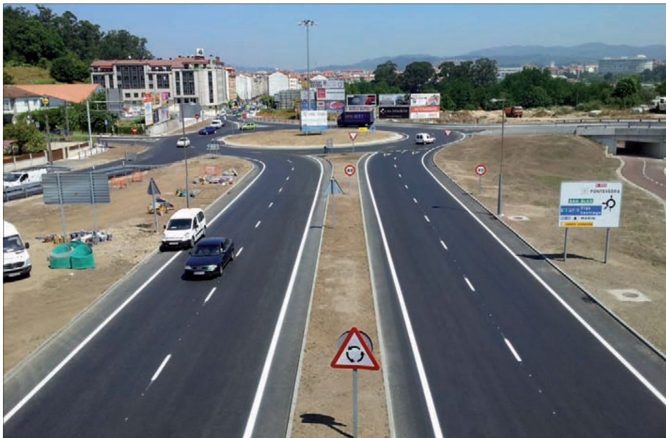
► Vista de eje que conduce a una de las glorietas del enlace, dotado con dos carriles por sentido, tras las obras de remodelación.
