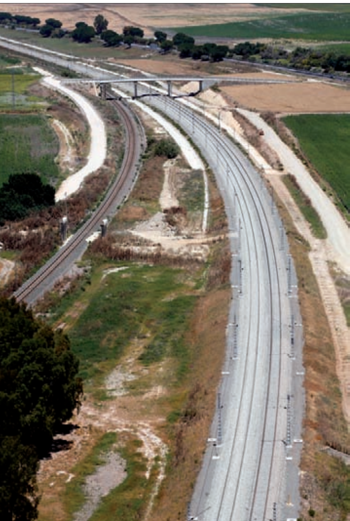
► La nueva plataforma ferroviaria discurre bien en variante (izquierda) o en paralelo al trazado de la línea convencional (derecha).
