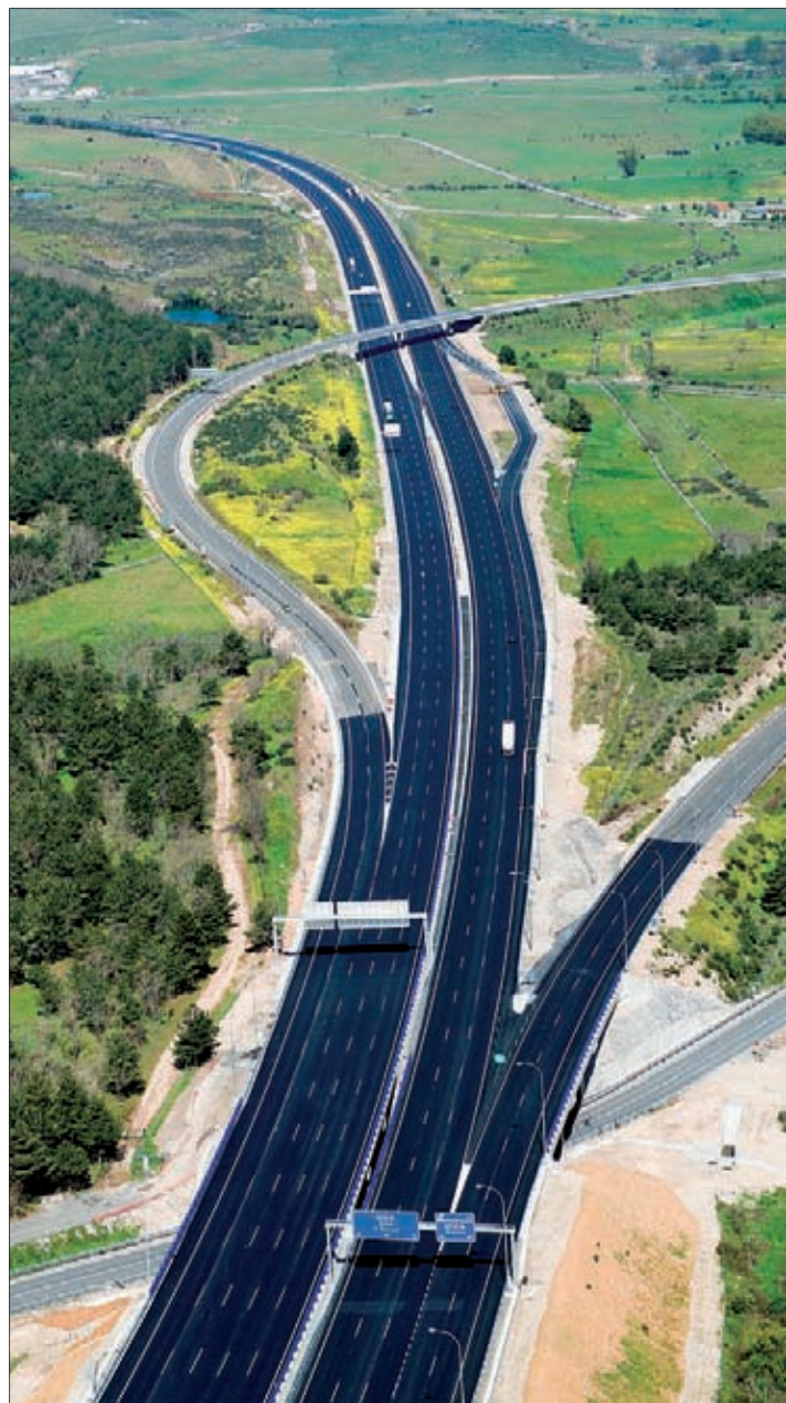
► Vista aérea del pk 61, en la conexión de la AP-6 con la AP-61, antes de la actuación (con dos carriles por sentido) y después (con tres carriles).
