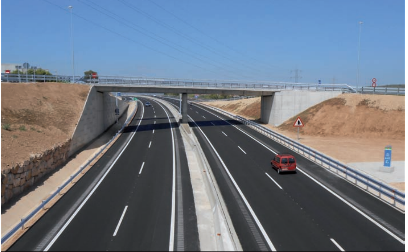
En el trazado se han construido nueve pasos superiores para garantizar la permeabilidad territorial y dar continuidad a las vías interceptadas.
