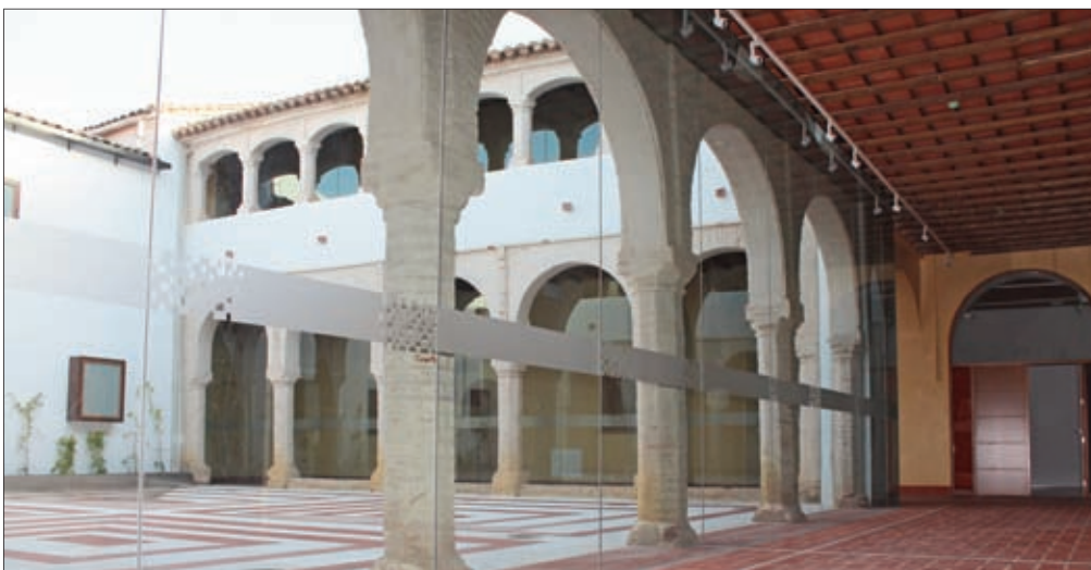
▮ Vestíbulos cubiertos de cristal, una de los resultados de la reforma del Palacio Episcopal de Llerena.
