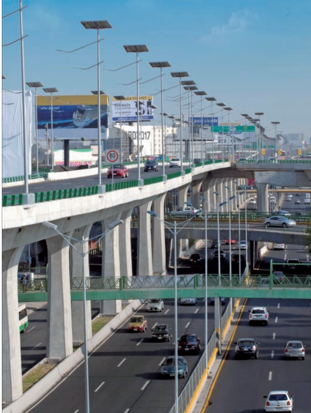
► Viaducto Bicentenario, estructura elevada de 10 km de longitud sobre un autopista de la capital mexicana.
