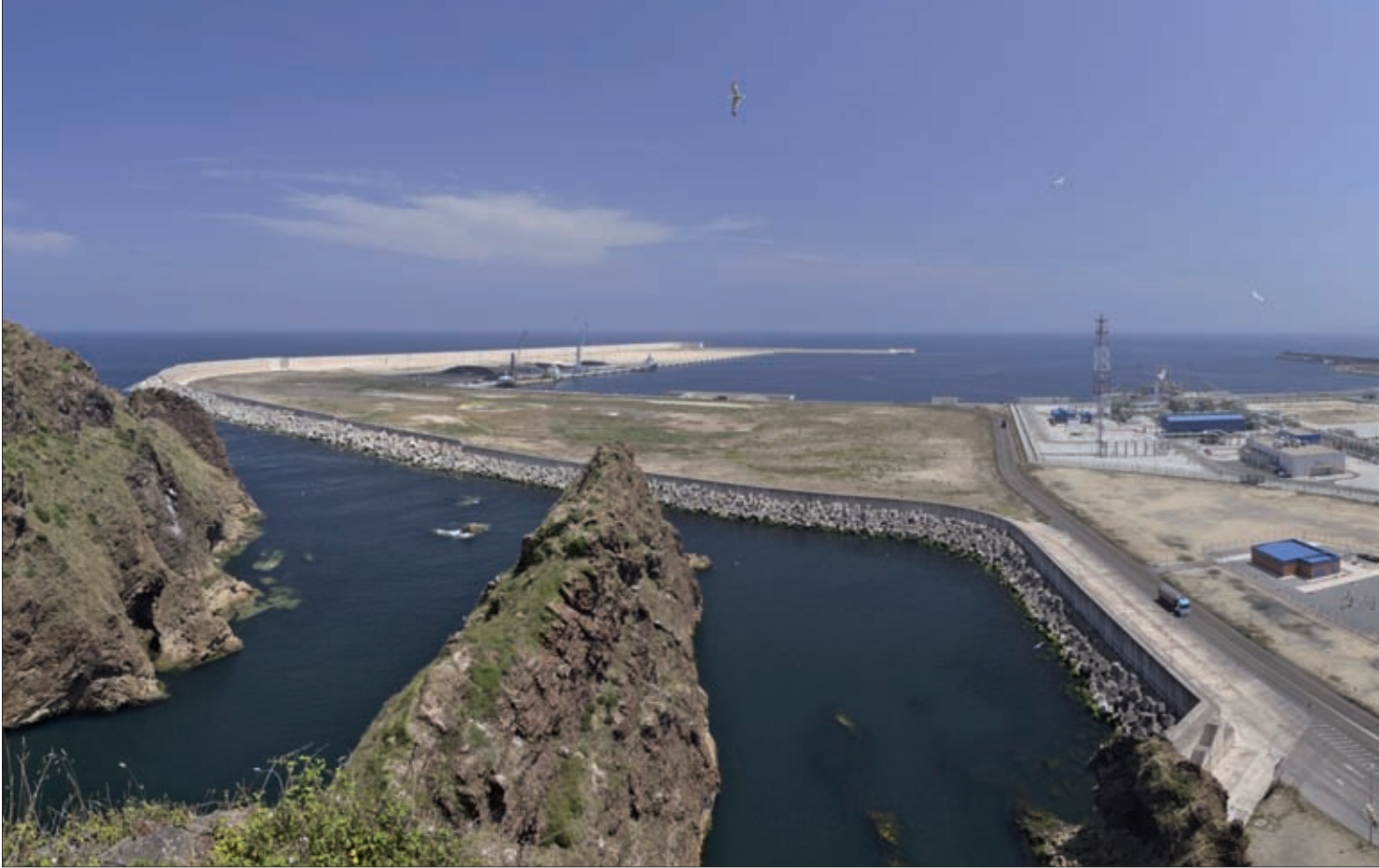
► Blue Change investiga el uso de GNL como combustible en la propulsión de buques. En la foto, depósitos de GNL en el puerto de Gijón.
