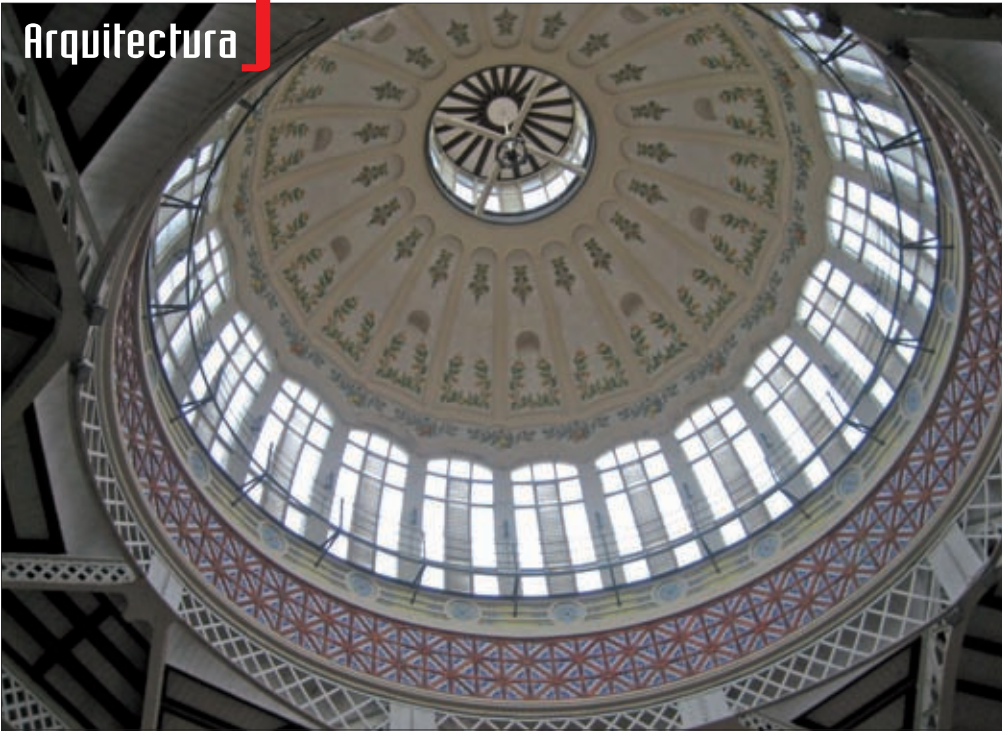
▮ Cúpula del Mercado Central de Valencia, con detalles de gusto modernista.
