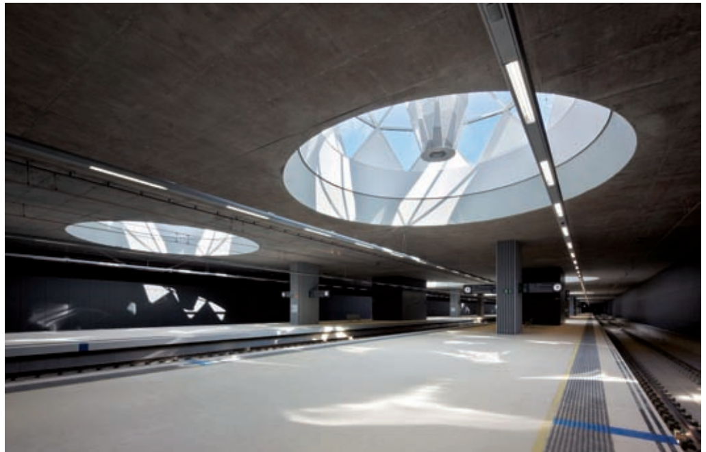
► La luz natural accede a la playa de vías de la estación de Logroño mediante grandes lucernarios.
