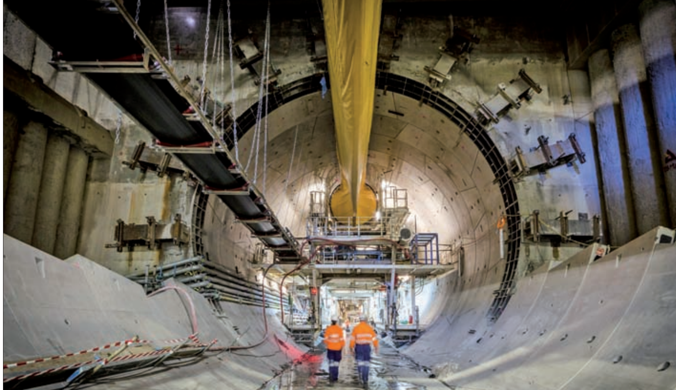
► El túnel de Legacy Way en Brisbane (Australia), construido mediante tuneladora, es una de las grandes obras con sello español en Australia.
