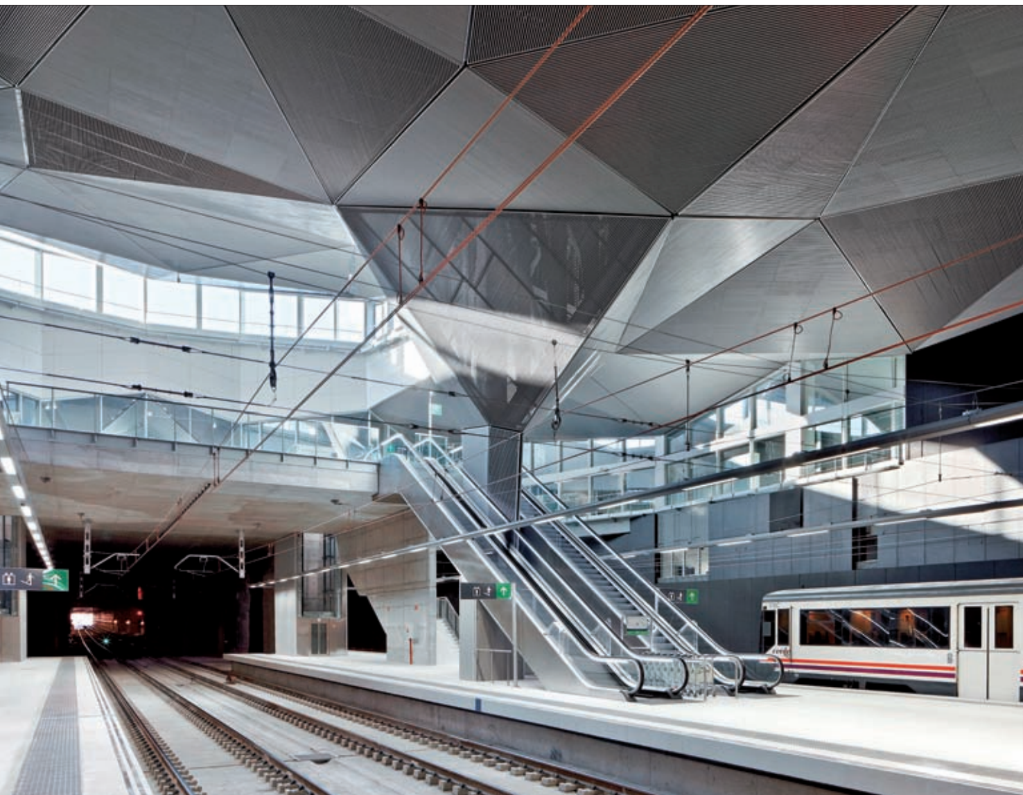
Andenes y vías de la estación de Logroño, en servicio desde julio de 2012.
