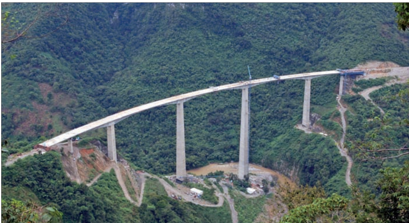
▶ Viaducto de San Marcos, principal estructura de la autopista de peaje Nueva Necaxa-Ávila Camacho, en el estado de Puebla (México).
