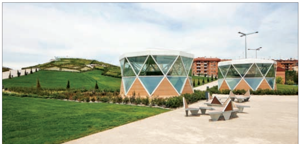
► El nuevo parque lineal sobre la estación rompe el efecto barrera que generaban las vías en su superficie.
