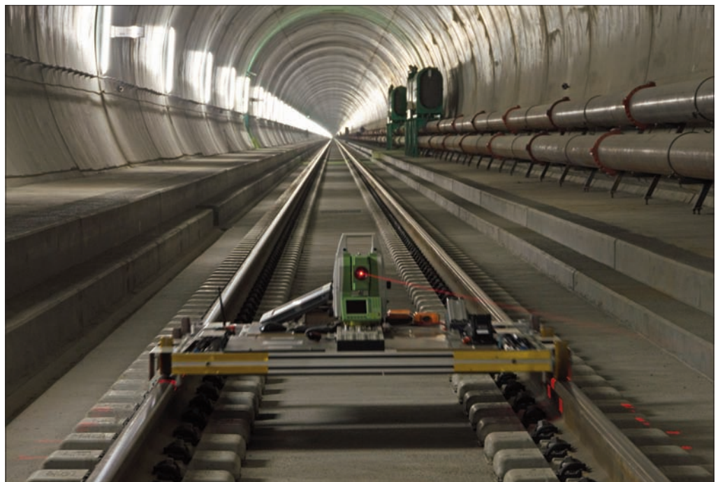
► Interior del túnel ferroviario de San Gotardo, ya construido, que comunicará Suiza e Italia.
