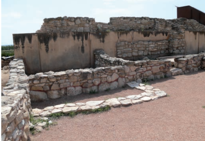
► Zona central del baluarte oriental.
