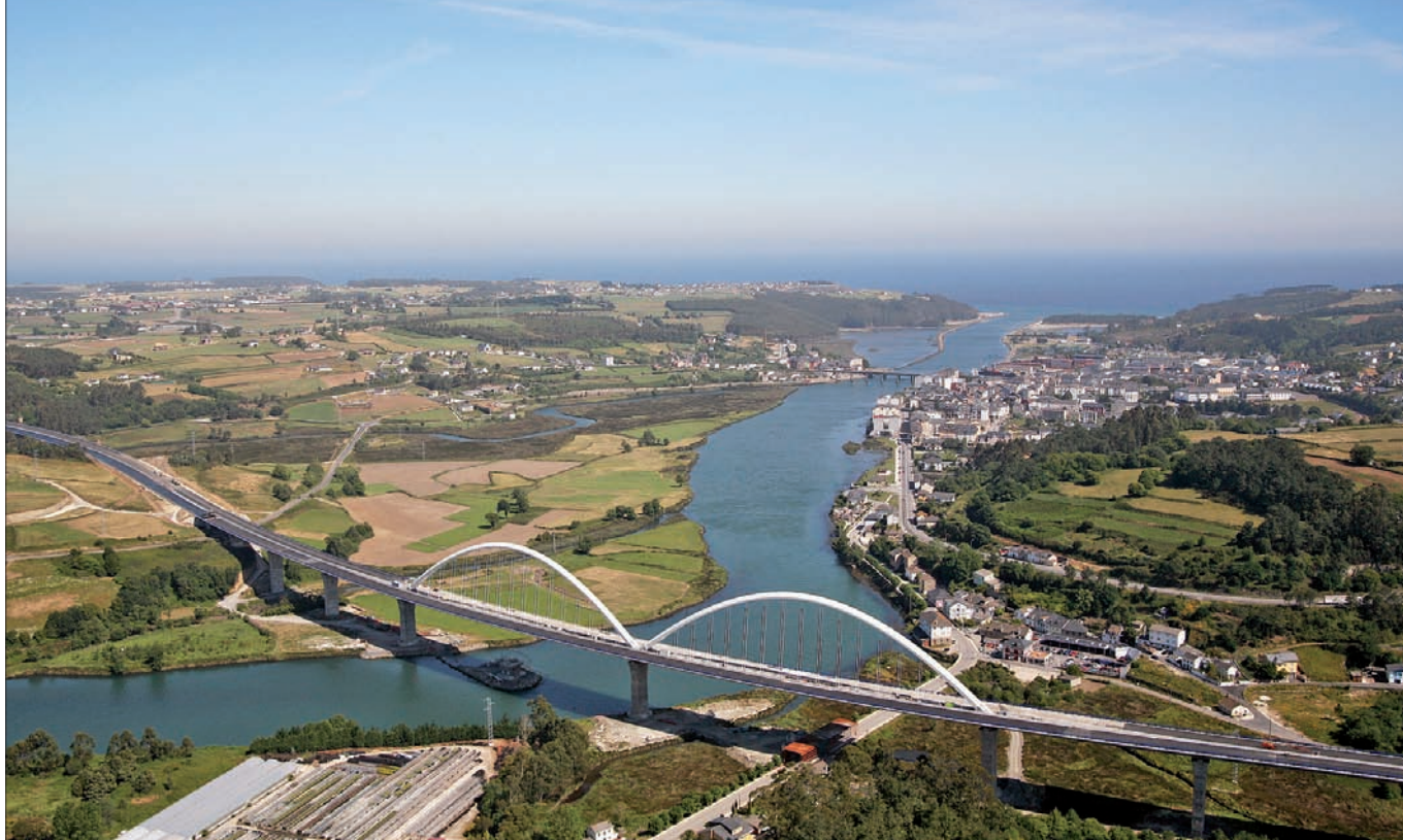
► Imagen aérea de la ría de Navia (Asturias) y de un viaducto de la autovía del Cantábrico.
