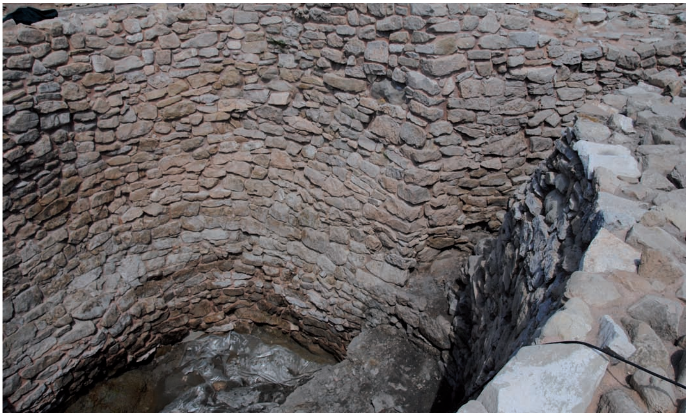
► Interior del aljibe o cisterna de Els Vilars, una infraestructura de carácter estratégico para la supervivencia del poblado.
