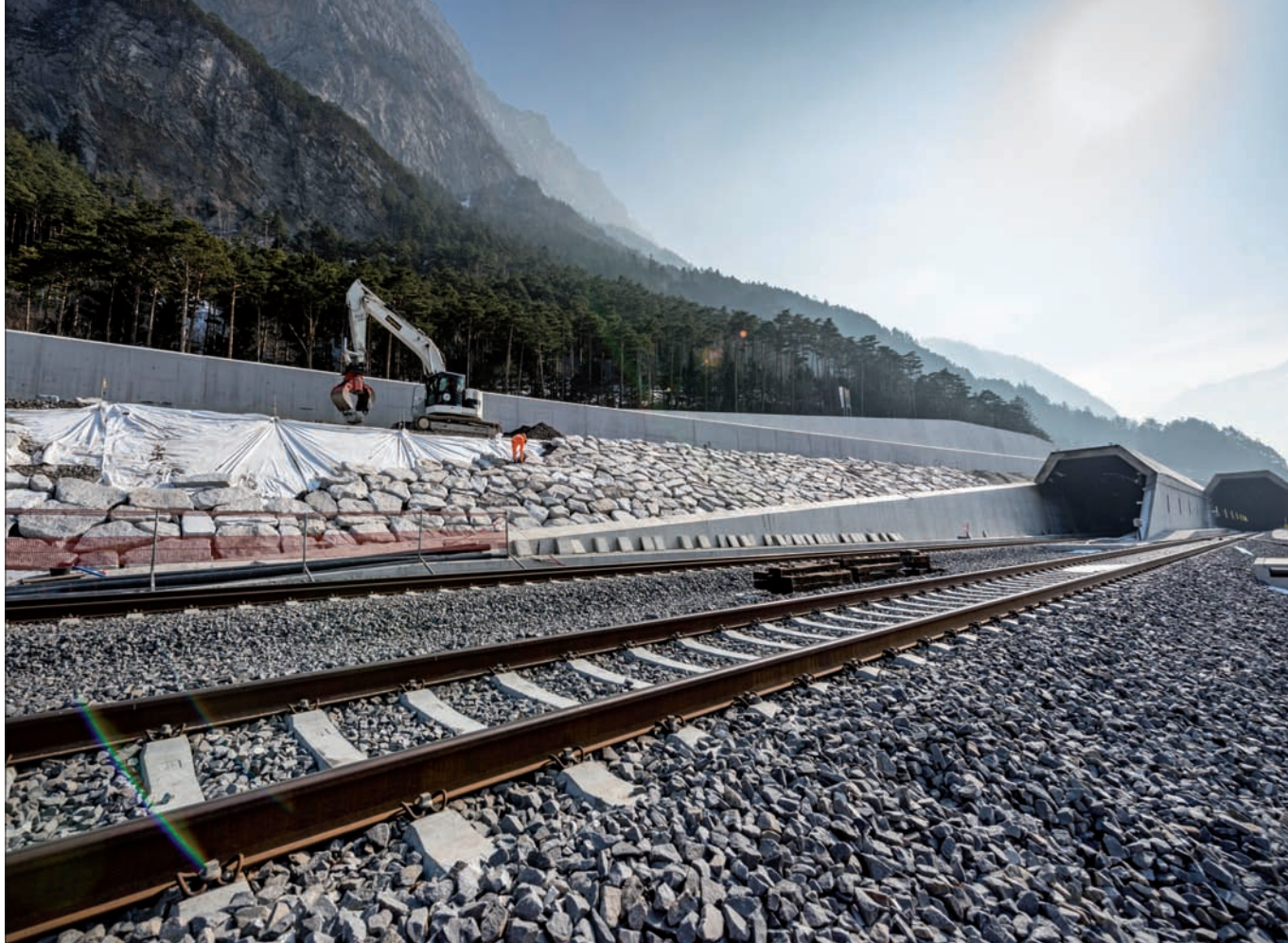
► Bocas de los túneles alpinos de San Gotardo, el mayor subterráneo ferroviario del mundo, construido con participación española.
