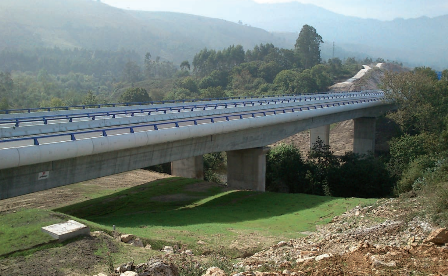
► El viaducto de Purón, de 178 metros de longitud, es la principal estructura del nuevo subtramo.
