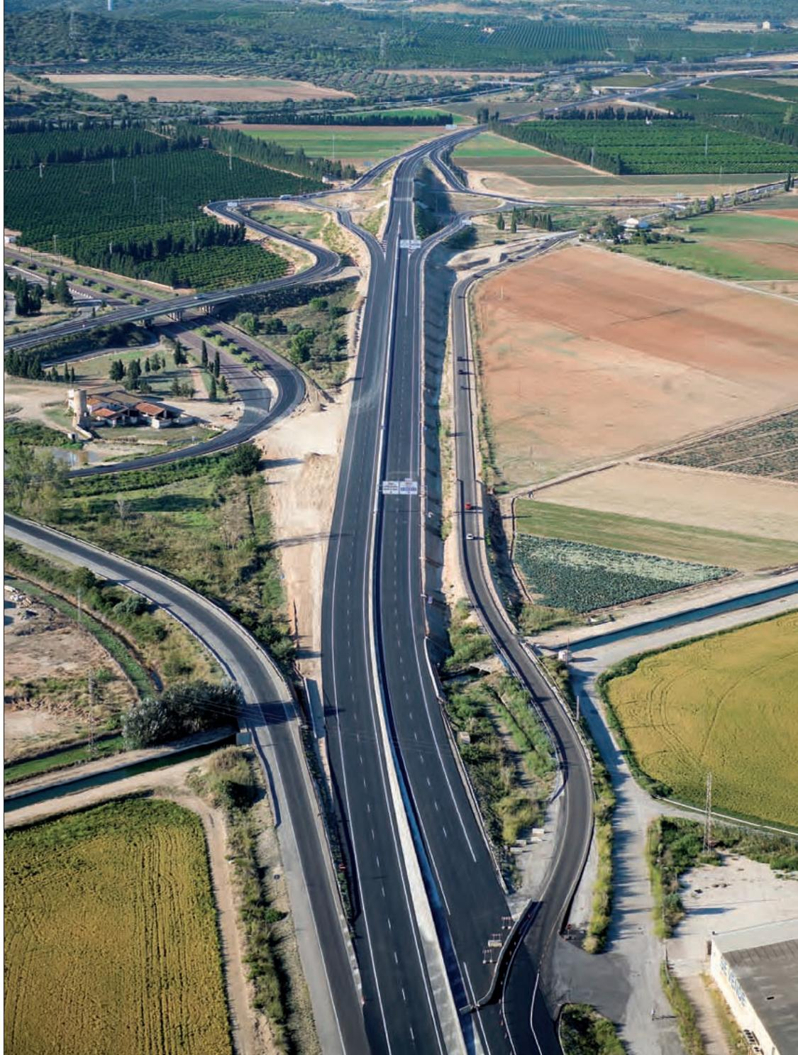
de L'Aldea y Camarles, se inicia en la salida del puente sobre el río Ebro de la anterior variante de Amposta. Se aleja de la antigua carretera N-340 para aproximarse a la autopista del Mediterráneo (AP-7), cruza el ferrocarril y discurre posteriormente entre el trazado de la autopista y el del ferrocarril, al noroeste del núcleo urbano de L'Aldea. Hacia el final del trazado se aleja de la AP-7, manteniéndose muy cercano a la línea férrea, para finalizar enlazando de nuevo con la antigua N-340.
