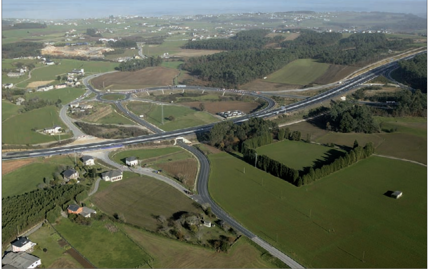
► El enlace de Polavieja, con tipología de trompeta, permite la conexión de la autovía con la carretera nacional N-634 y con la local NV-5.
