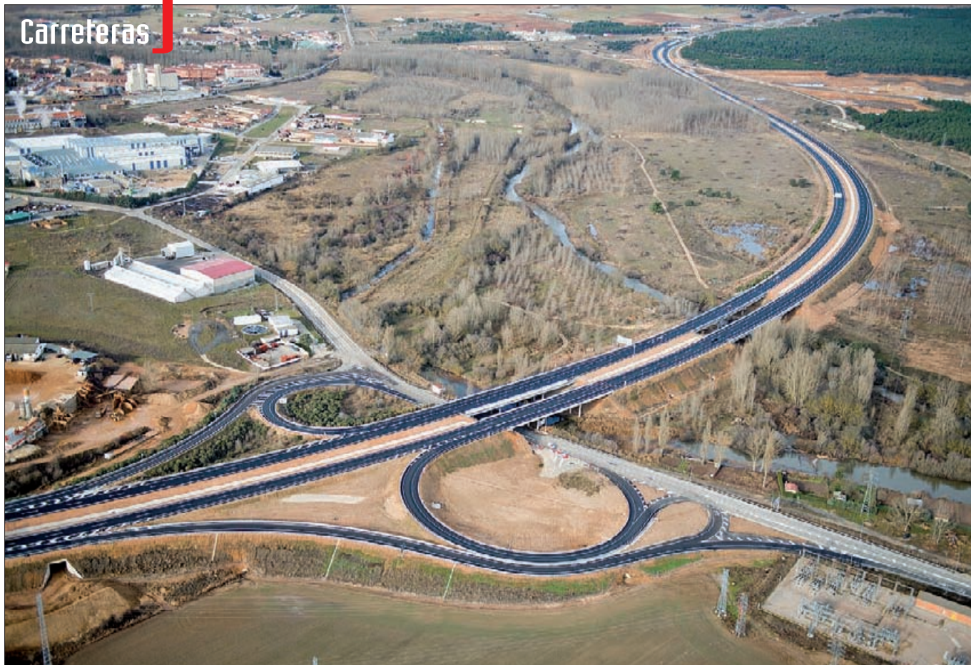
Arriba, viaducto sobre el río y canal del Duero, en la variante de Almazán. Debajo, enlace de Bordejé.
