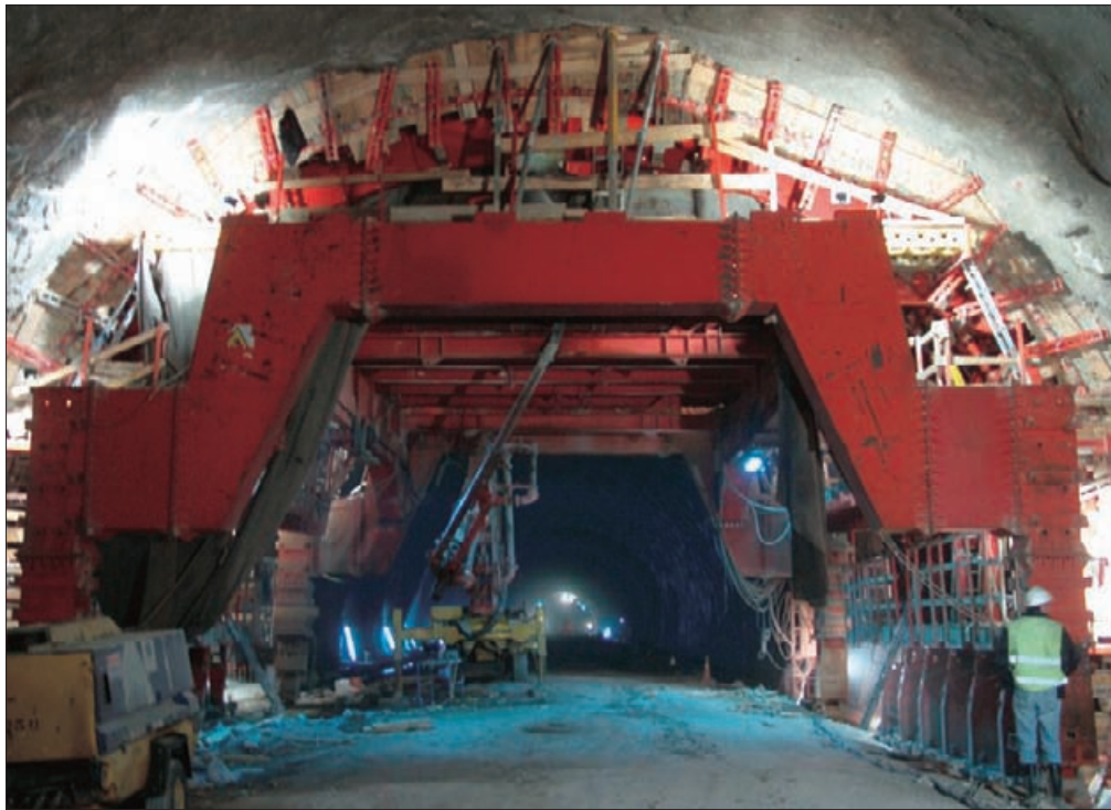
► Carro de anillos empleado en la construcción del segundo túnel.
