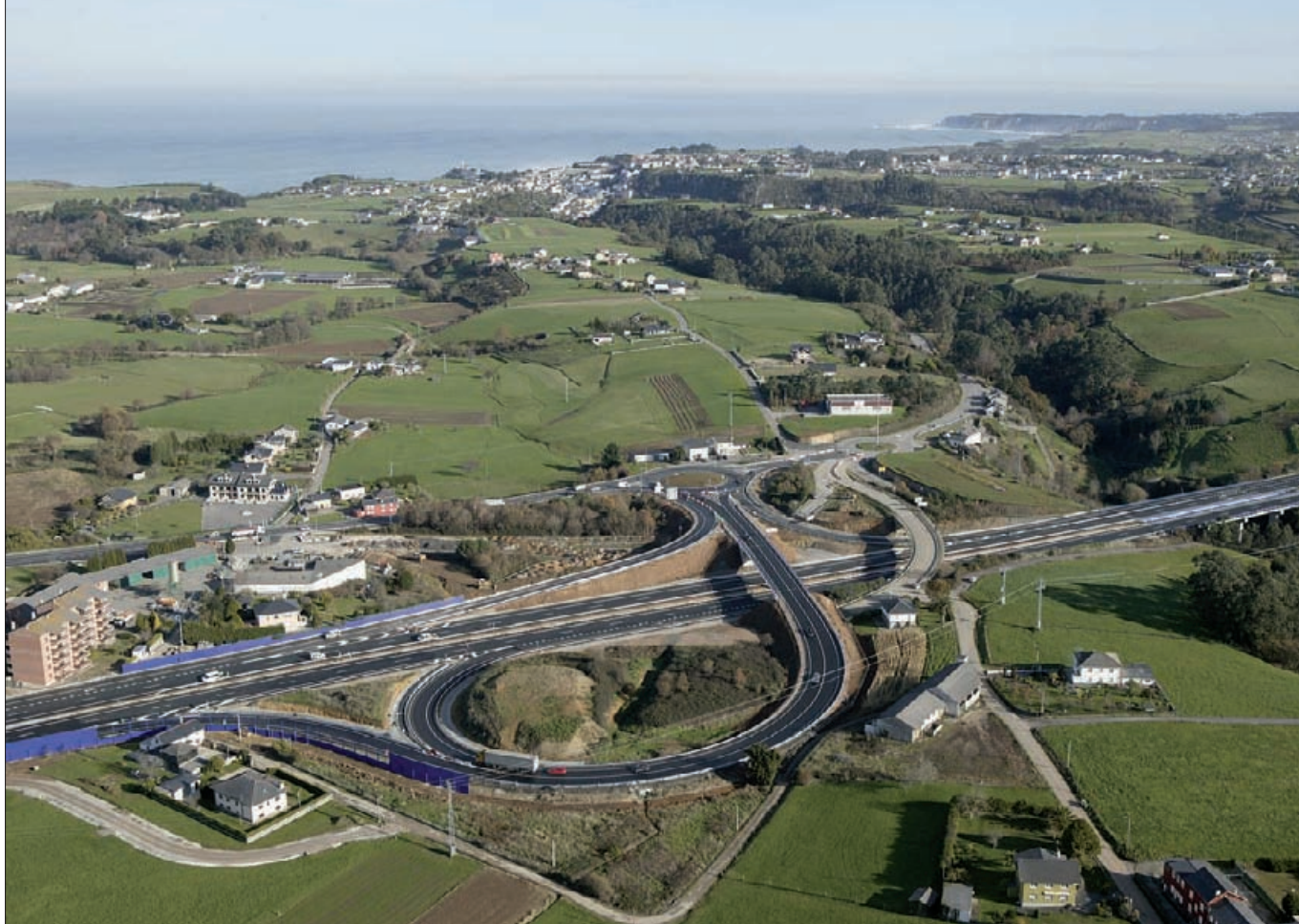
El enlace de Vistalegre, con tipología de trompeta, es uno de los dos que se disponen en el tramo Otur-Villapedre.
