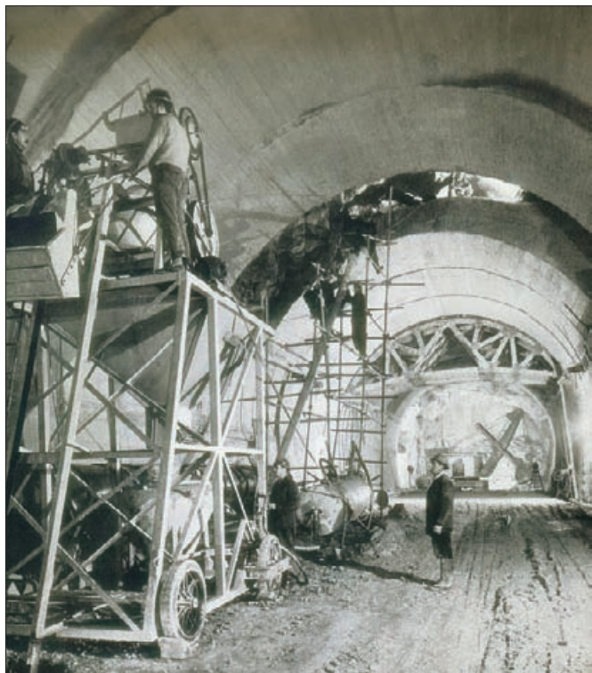
La ejecución del túnel se resolvió mediante un andamio móvil que permitía trabajar en cuatro niveles diferentes.
