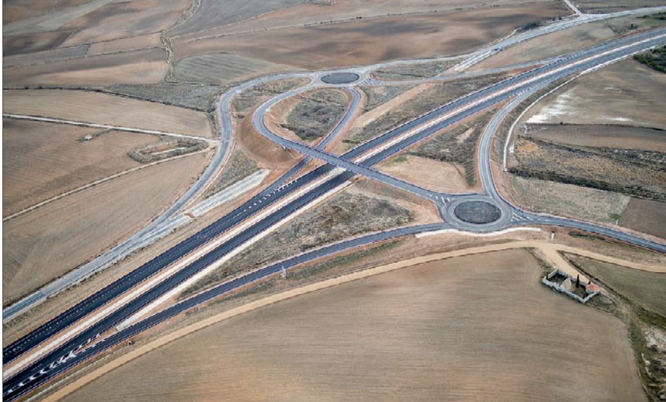
El nuevo tramo de autovía incluye siete enlaces. En la imagen, enlace de Sauquillo del Campo.
