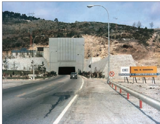
Boca del lado Madrid del primer túnel de Guadarrama.
