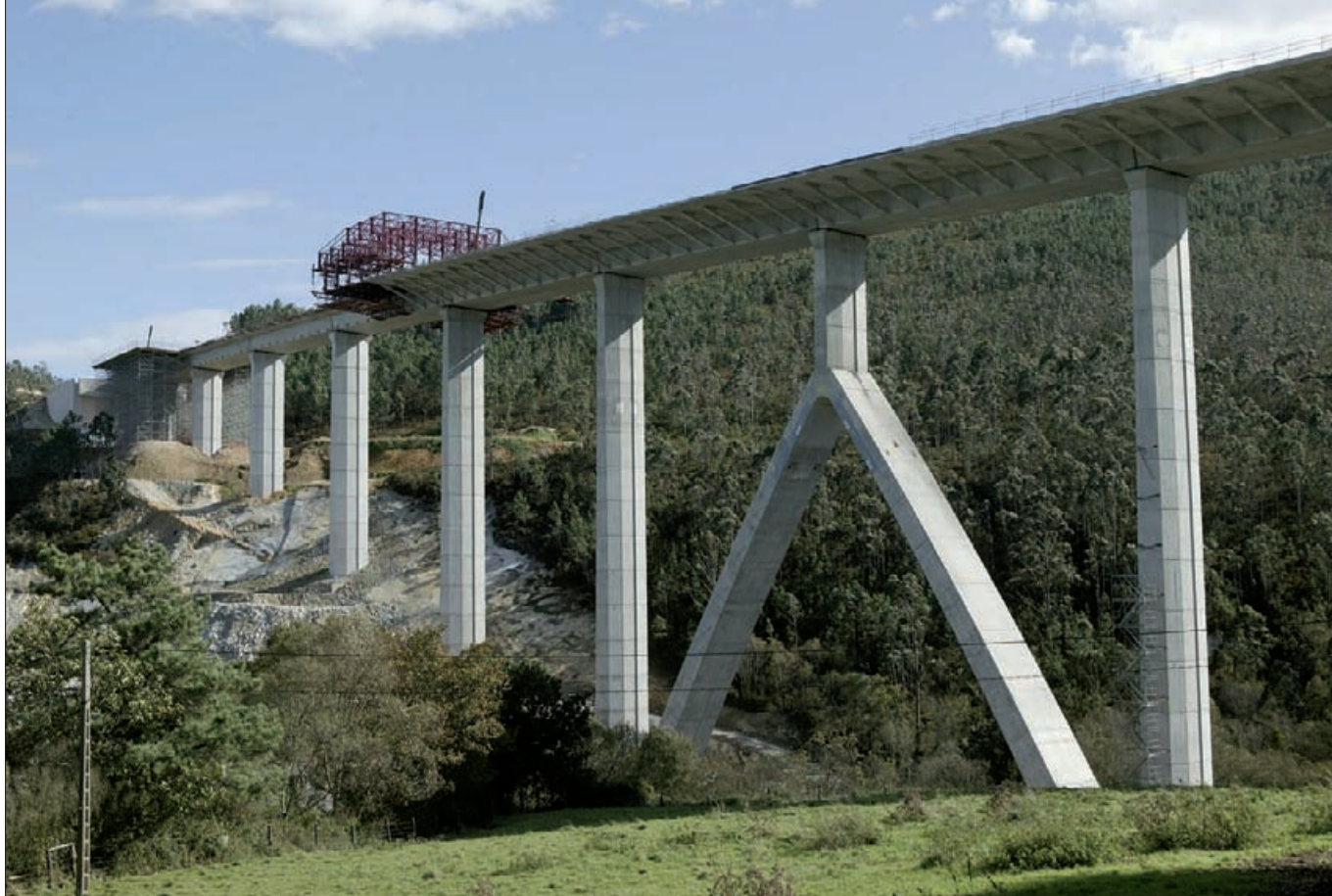
► Fase de ejecución de voladizos del viaducto sobre el río Barayo, que presenta una altura máxima de pilas de 62 metros.
