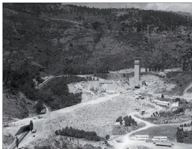
Trabajos en la boca sur del segundo túnel de Guadarrama.
