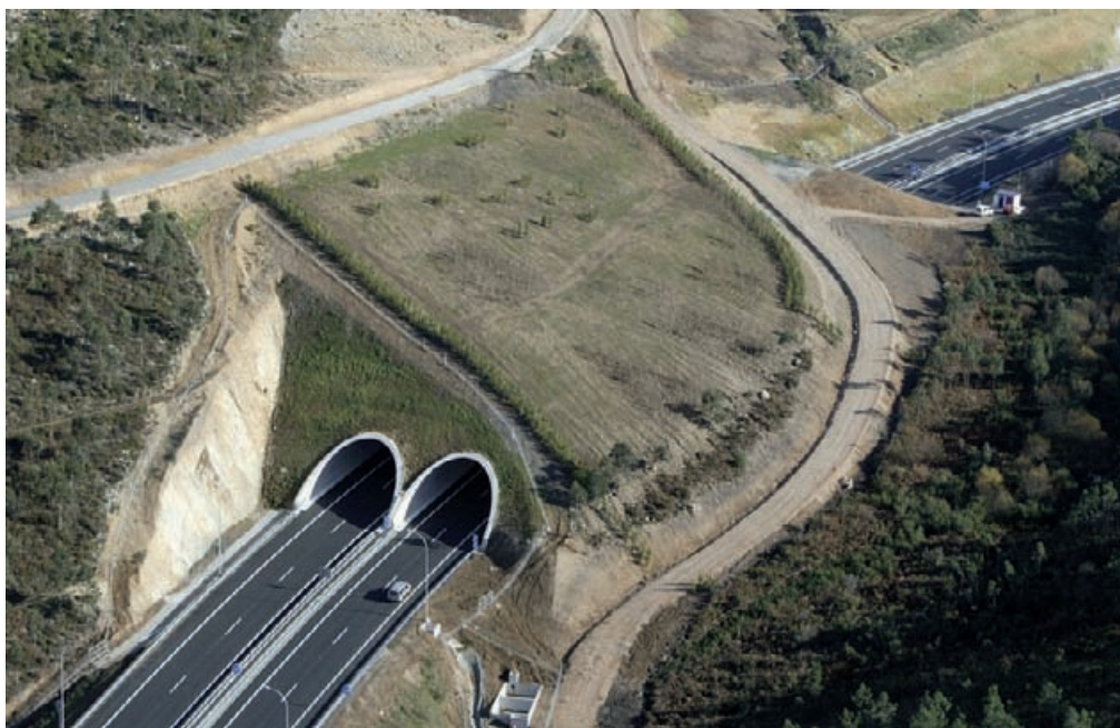
Túnel artificial de Faro, de 155 metros de longitud, construido por prescripción de la DIA.
