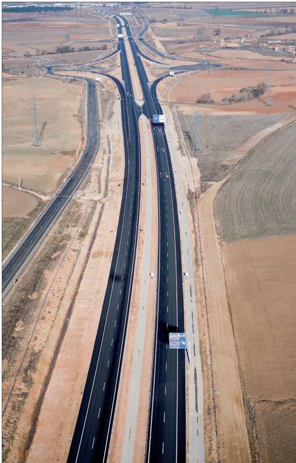
La primera parte del tramo está formada por una larga alineación recta que discurre junto a la carretera N-111.
