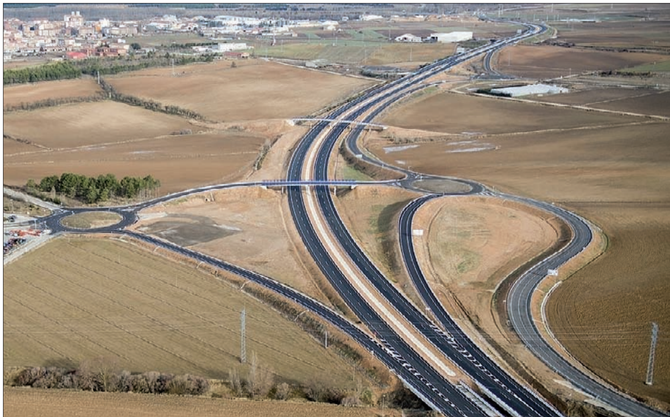
► Enlace de Almazán Sur, donde conectan las dos fases del tramo Sauquillo del Campo-Almazán.
