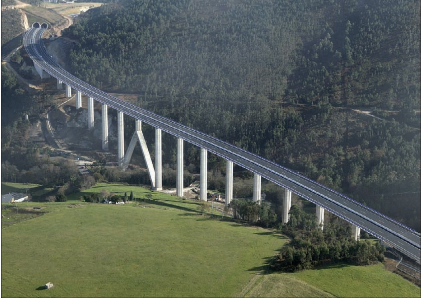
► El viaducto sobre el río Barayo, de 592 metros de longitud, es la principal estructura de ingeniería del tramo.
