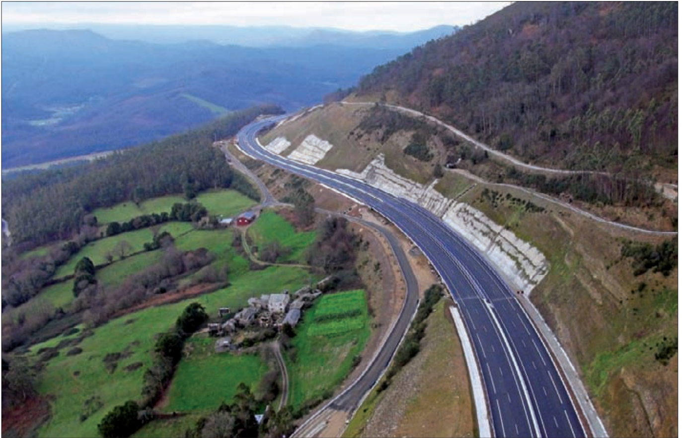
► Medidas de refuerzo de laderas ejecutadas en el tramo Mondoñedo-Lindín y viaducto de Monfadal.
