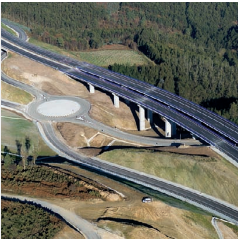
► Arriba, conexión de ambos tramos en el enlace de Lindín. Debajo, viaducto de Curros.
