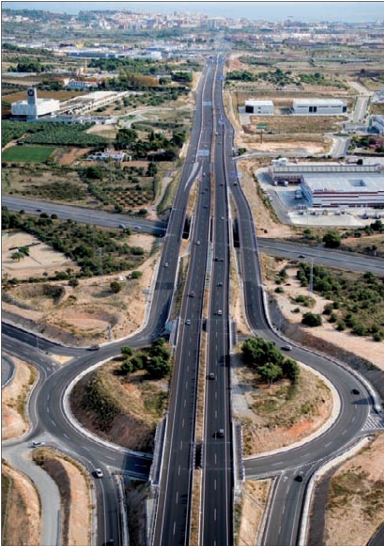
► La T-11 se amplía con sendos carriles laterales a partir del enlace con la autopista AP-7.
