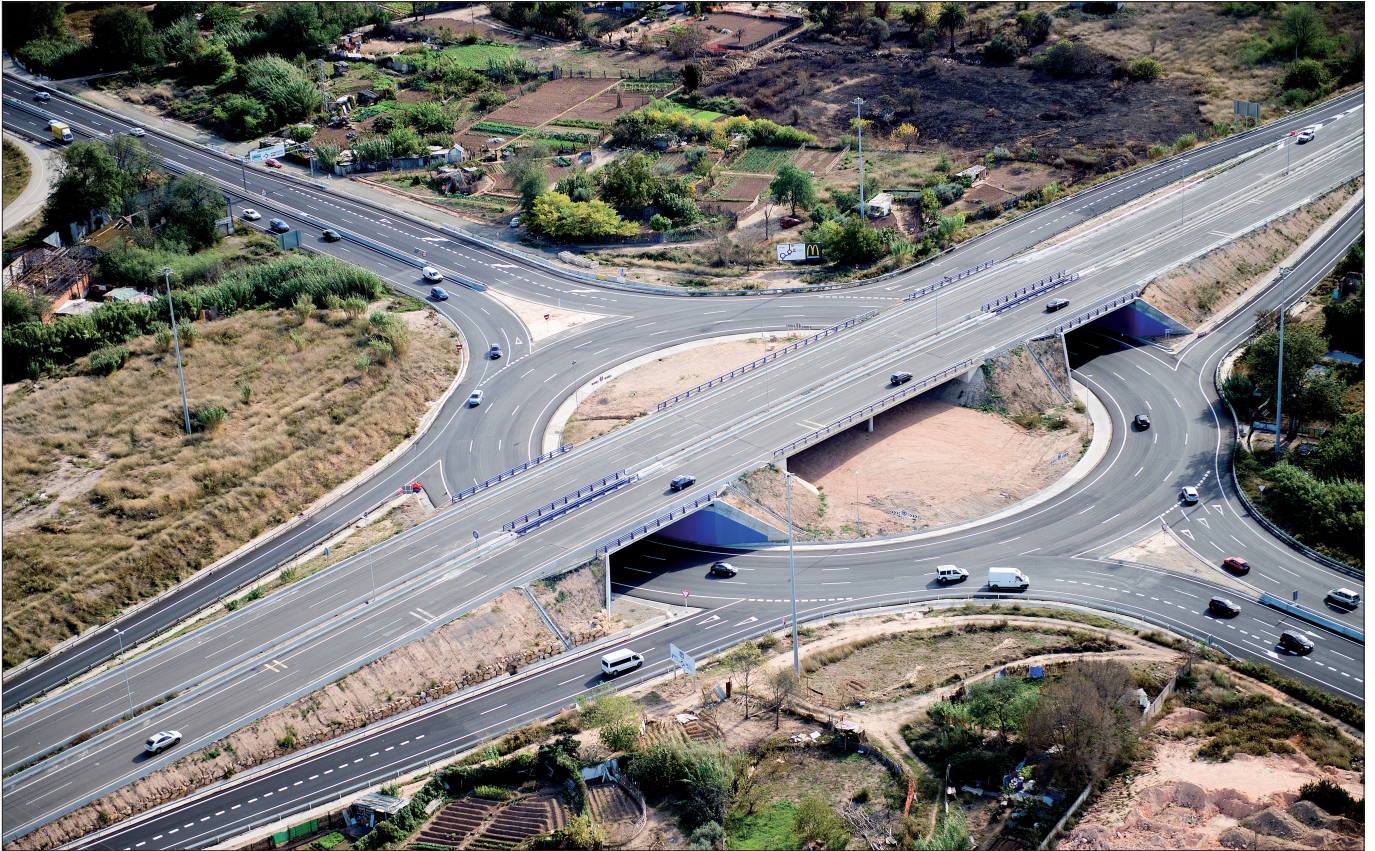
► Enlace de la T-11 con la autovía A-27, ya en la ciudad de Tarragona, consistente en una glorieta a distinto nivel.
