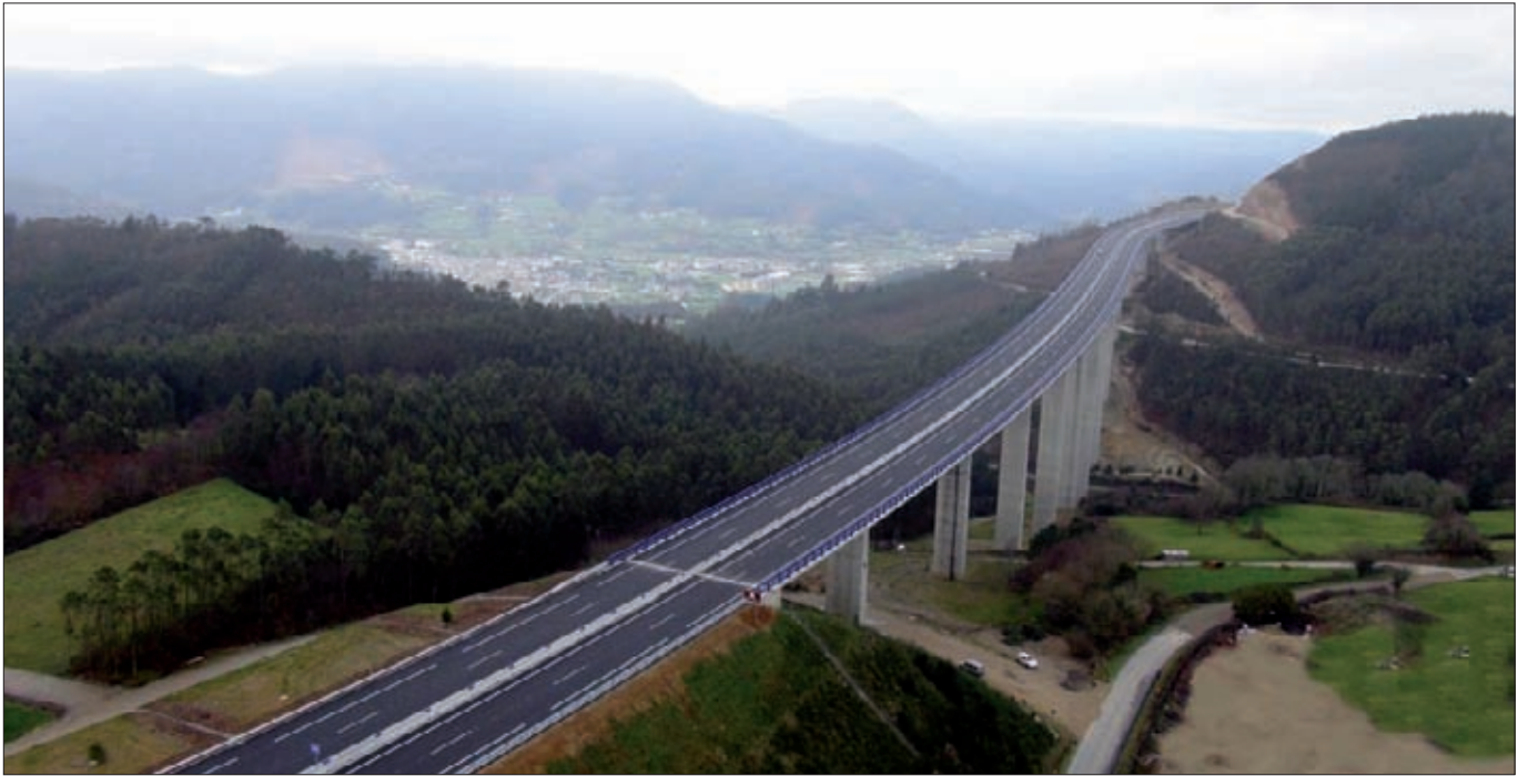
► El viaducto de Lindín (757 metros de longitud y 103 metros de altura máxima de pila) es la principal estructura de ingeniería del tramo Mondoñedo-Lindín.
