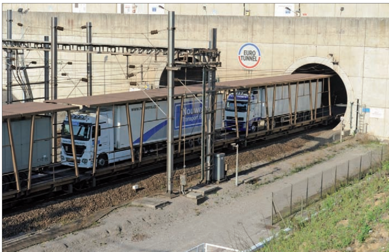
► Arriba, transporte de camiones a través del túnel en una lanzadera. Debajo, entrada de turismos en una lanzadera.
