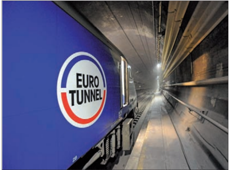
▶ Locomotora en el interior del Eurotúnel y mapa del mismo.
