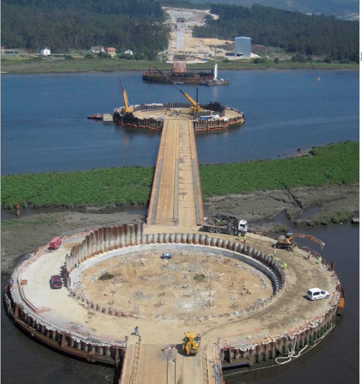
► Islas artificiales en el cauce del río Ulla para la cimentación en seco de los pilares centrales del viaducto.
