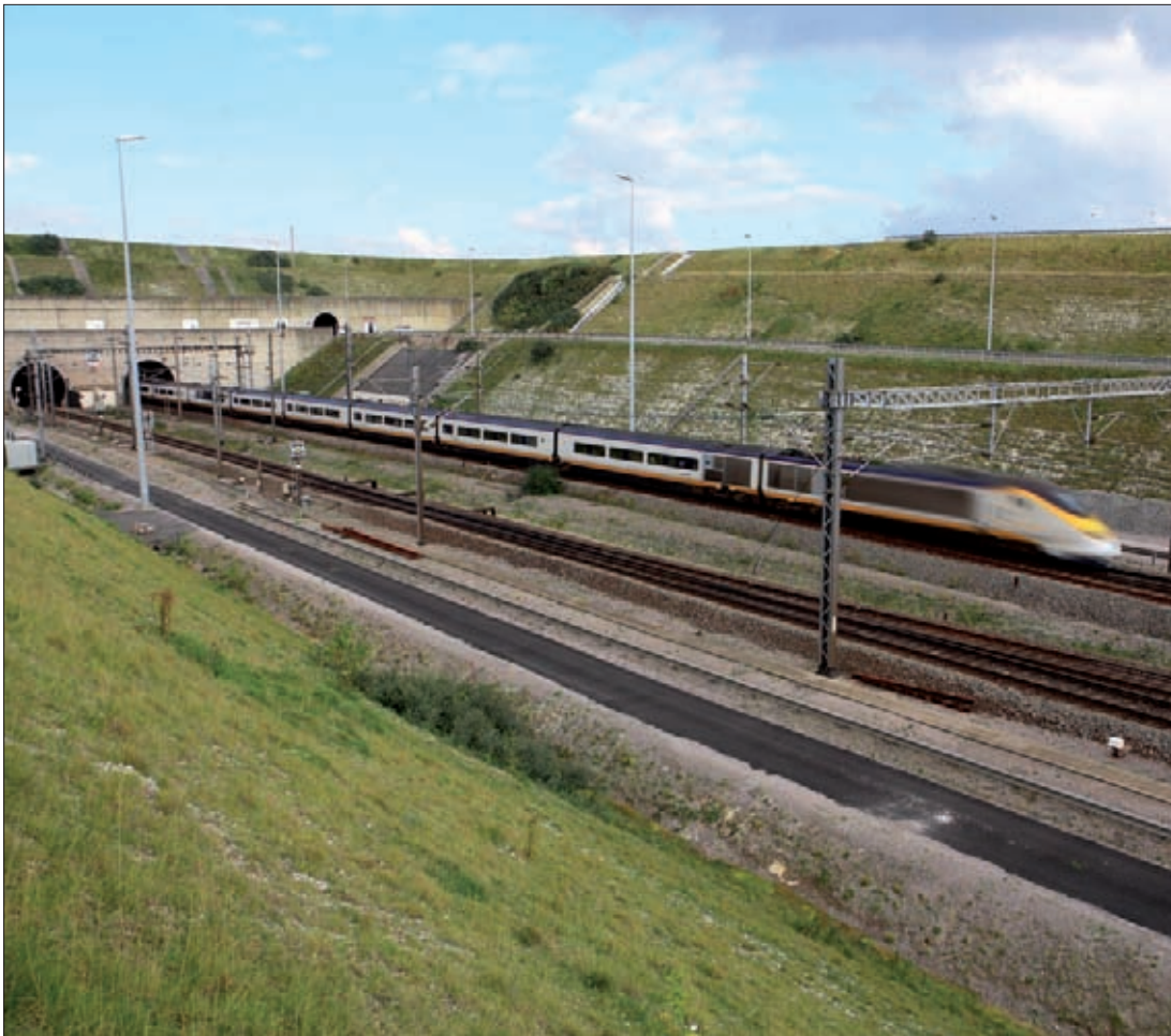
► Tren de pasajeros de alta velocidad Eurostar en una de las bocas del túnel. Debajo, trabajos de mantenimiento en el subterráneo.
