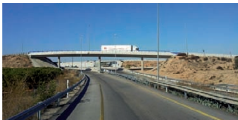
► Paso superior E-3, que elimina los trenzados de los movimientos Madrid-Alicante y Loriguilla -Valencia.
