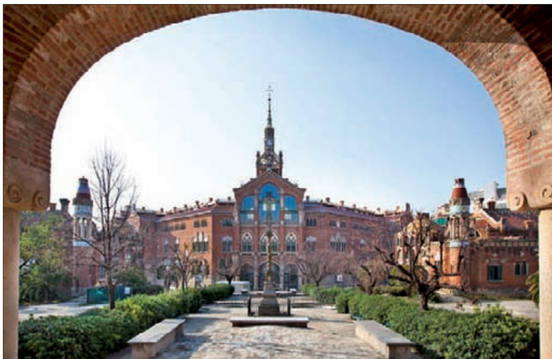
► Tras la rehabilitación, la fachada del pabellón de la Administración ha recuperado sus colores originales.
