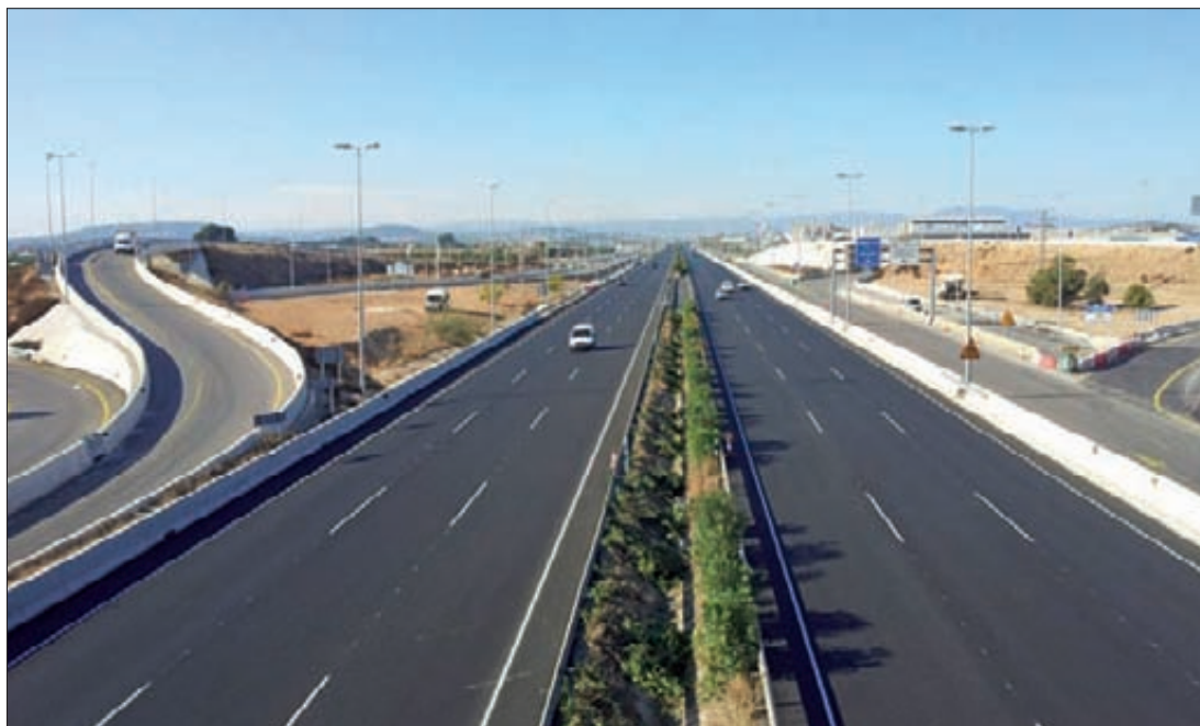
► Tronco actual de la autovía A-3, con tres carriles (izquierda) y tronco antes de las obras, con dos carriles (debajo).
