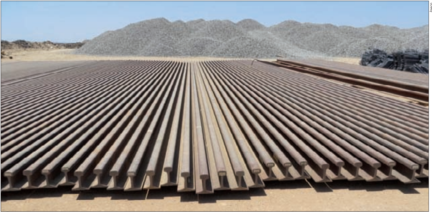
► Acopio de balasto y carril, los dos elementos de la superestructura más perjudicados por la arena y el polvo.
