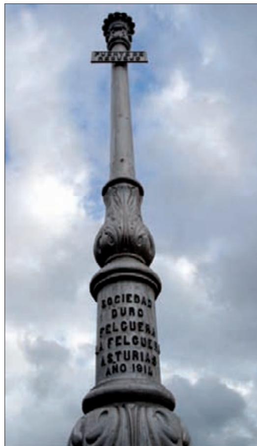
► Hito que recuerda a la empresa constructora.
