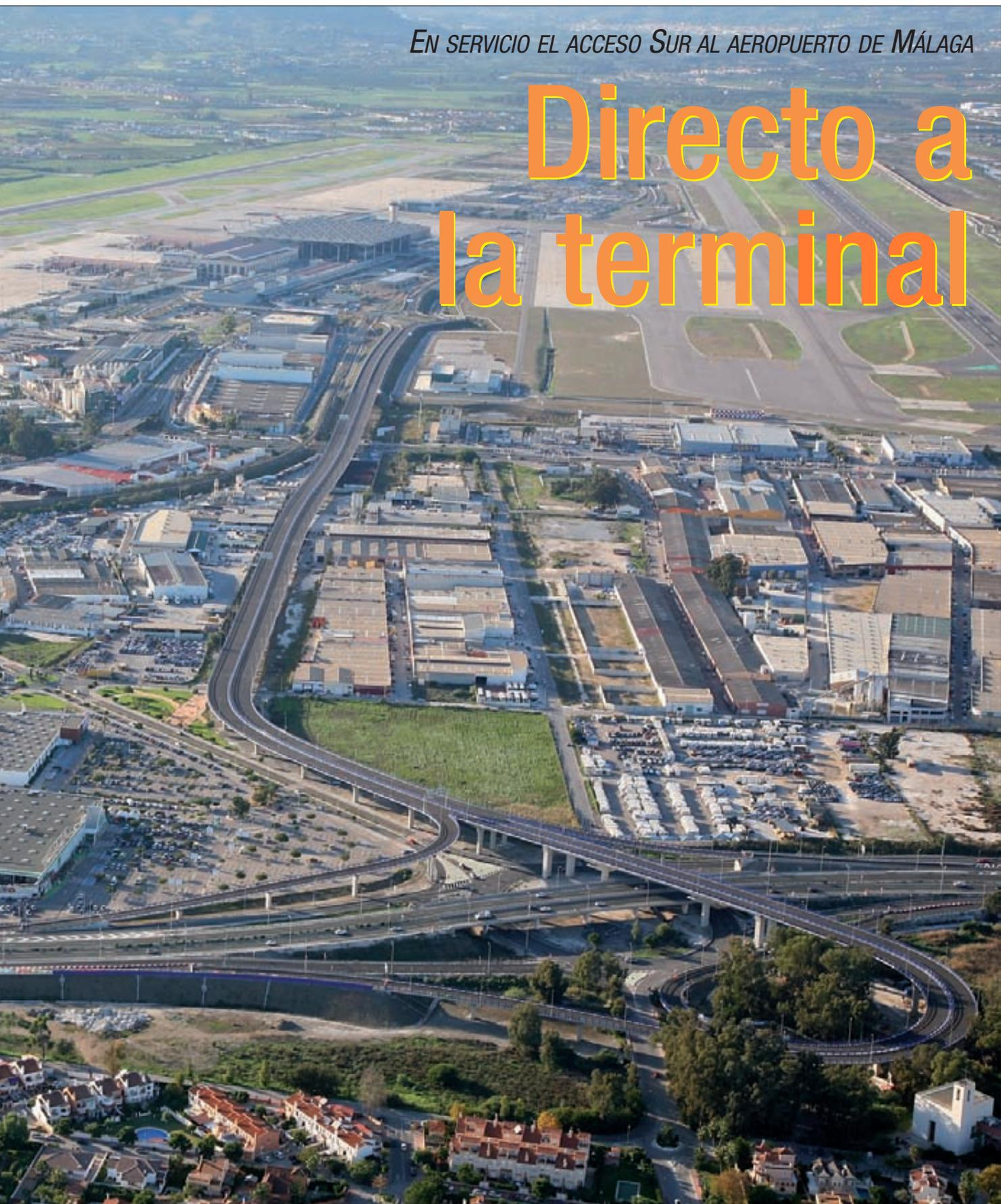
0,5 metros y mediana de 0,4 metros. El firme está compuesto por una subbase de 25 centímetros de suelocemento sobre la que se disponen 30 centímetros de mezclas bituminosas (22 centímetros de capa base G-25, 5 centímetros de capa intermedia D-20 y 3 centímetros de capa de rodadura M-10).
