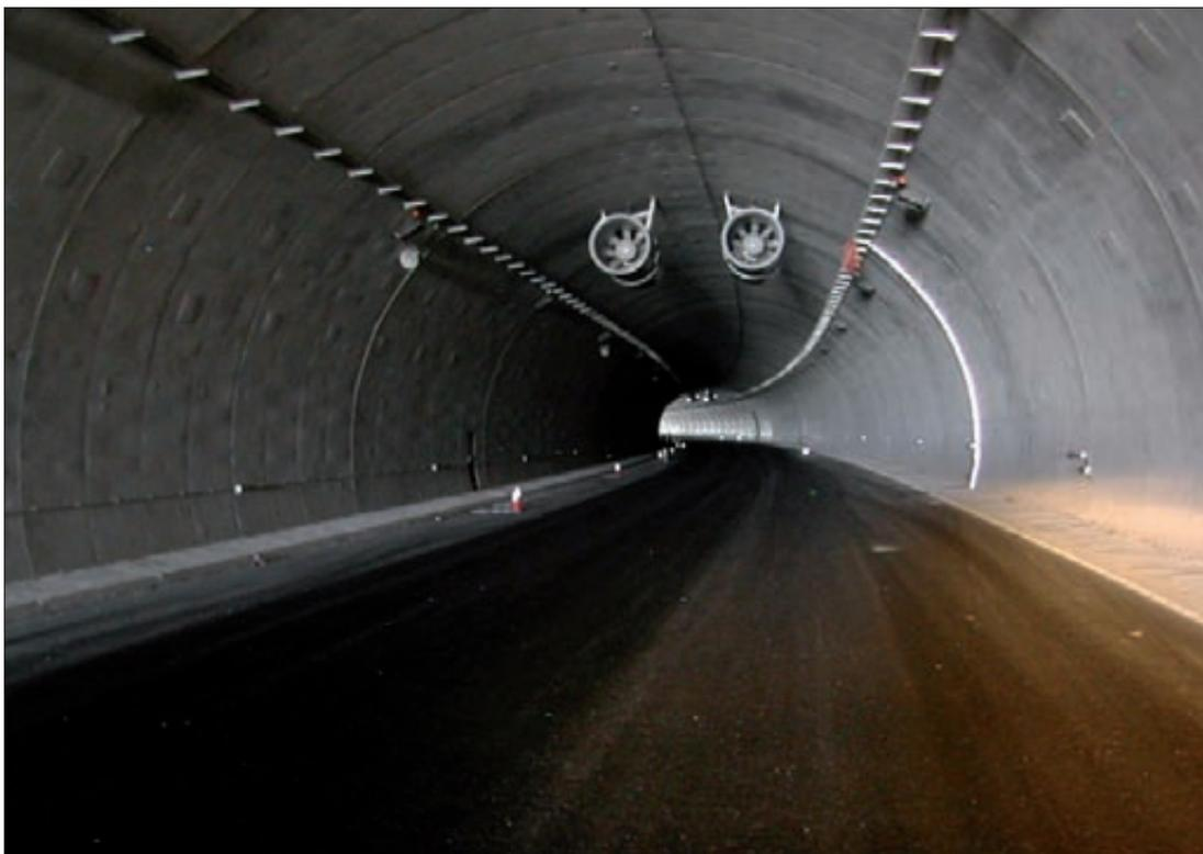
► Interior de uno de los túneles, con sección de 80 m<sup>2</sup>, antes de la puesta en servicio.
