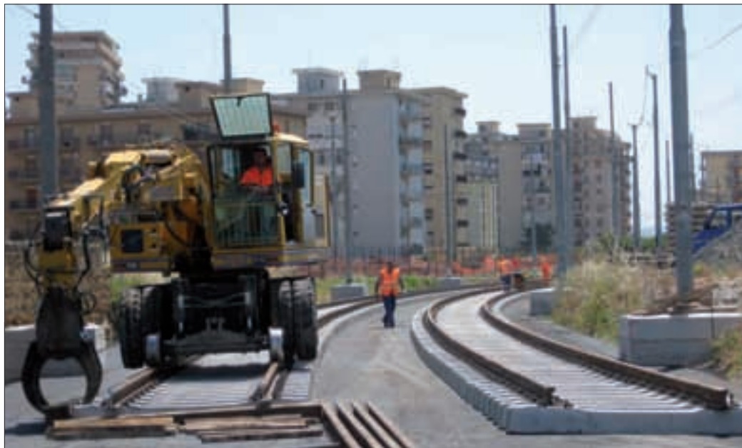
► Montaje de vías para el metro ligero de Palermo (Italia).
