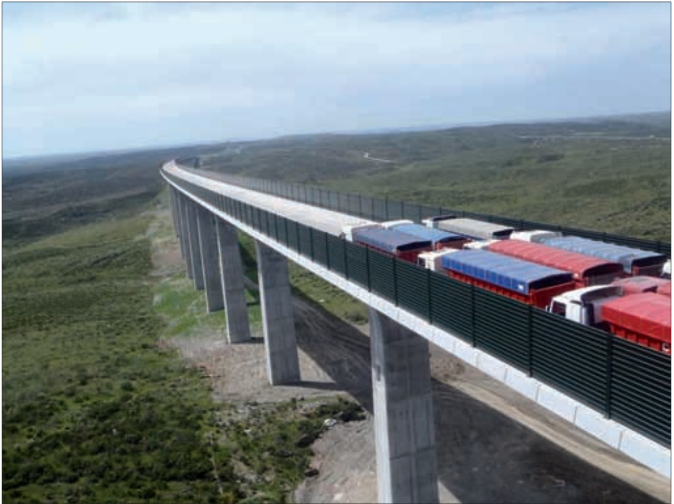
► En la prueba de carga participaron un total de 24 camiones.
