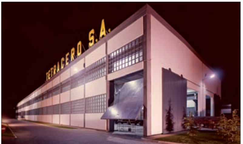
► Detalle de escalera y una de las naves proyectadas para la empresa Tetracero
