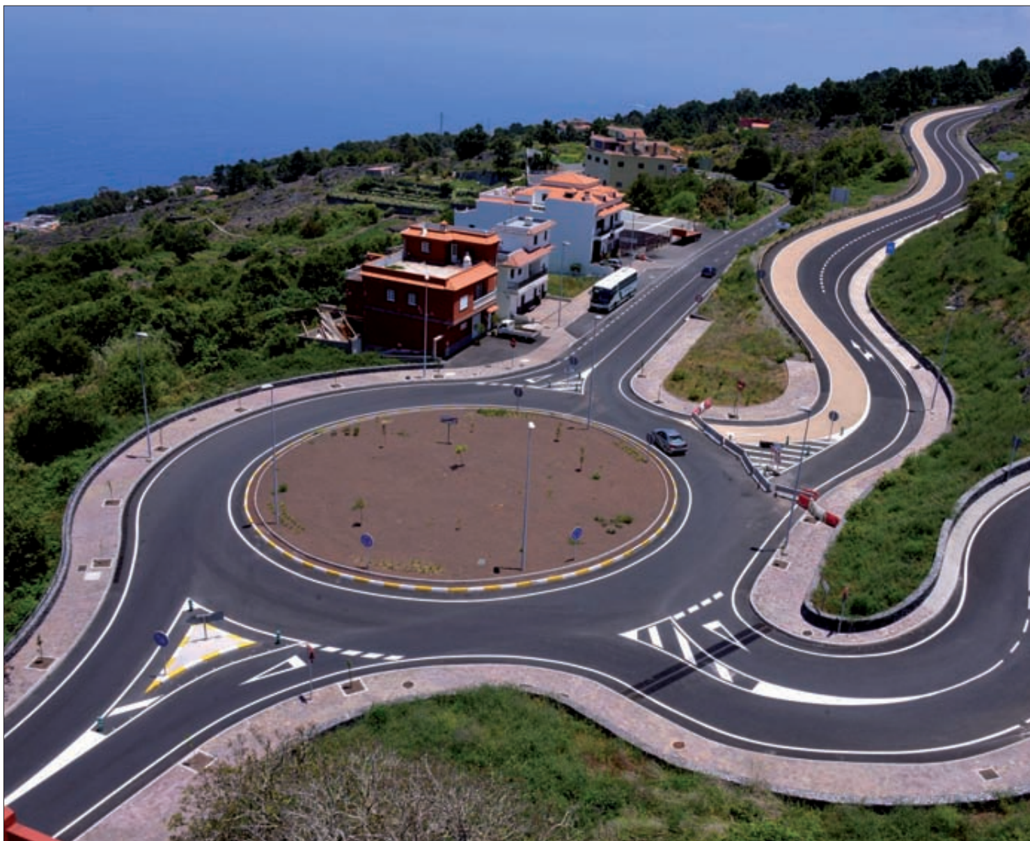
► Glorieta de El Tanque y enlace con la TF-82.
