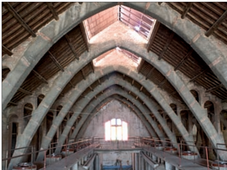
► Interior de la bodega de l' Espluga de Francolí.
