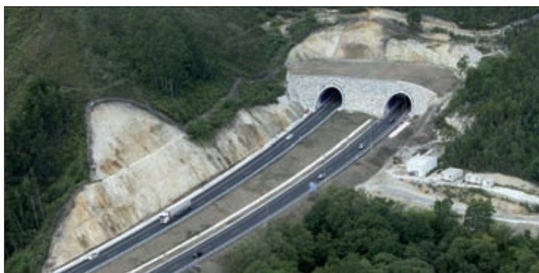
► Bocas del túnel de Santiuste.
