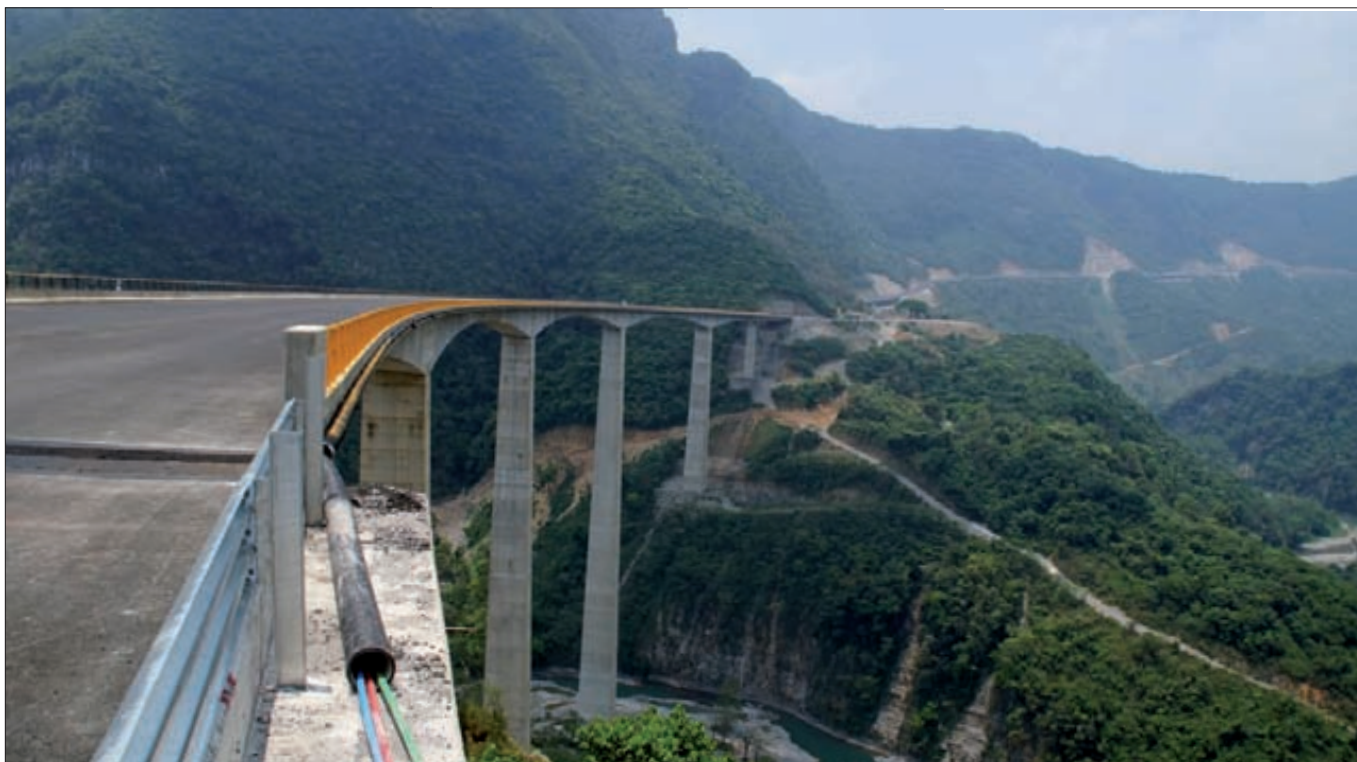
► Dos vistas del viaducto desde el mismo ángulo. Arriba, ya concluido, y debajo, durante la ejecución del tablero.
