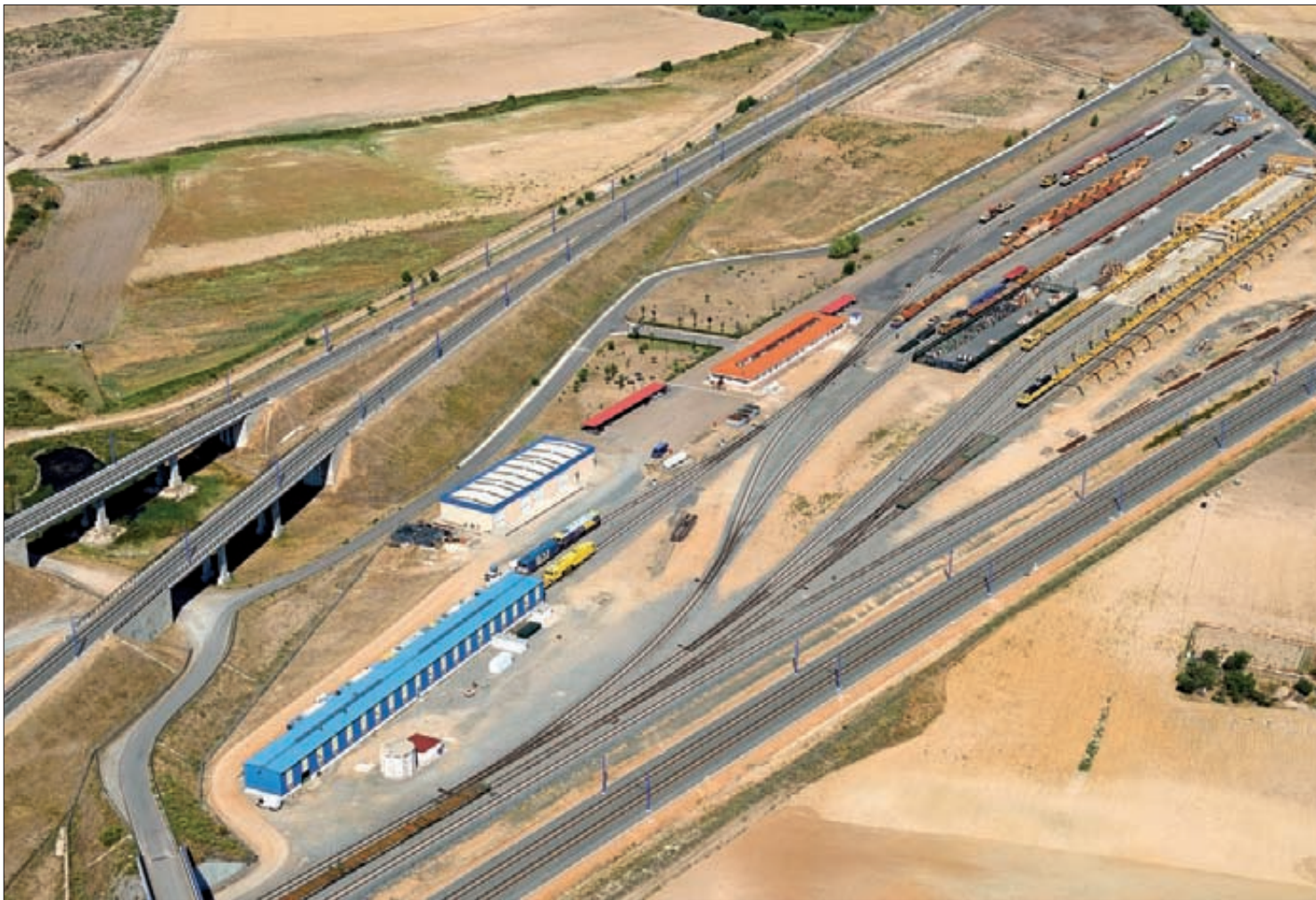
► El tramo arranca en dos ramales que conectan con la LAV Madrid-Valladolid, junto a la base de montaje de Olmedo.
