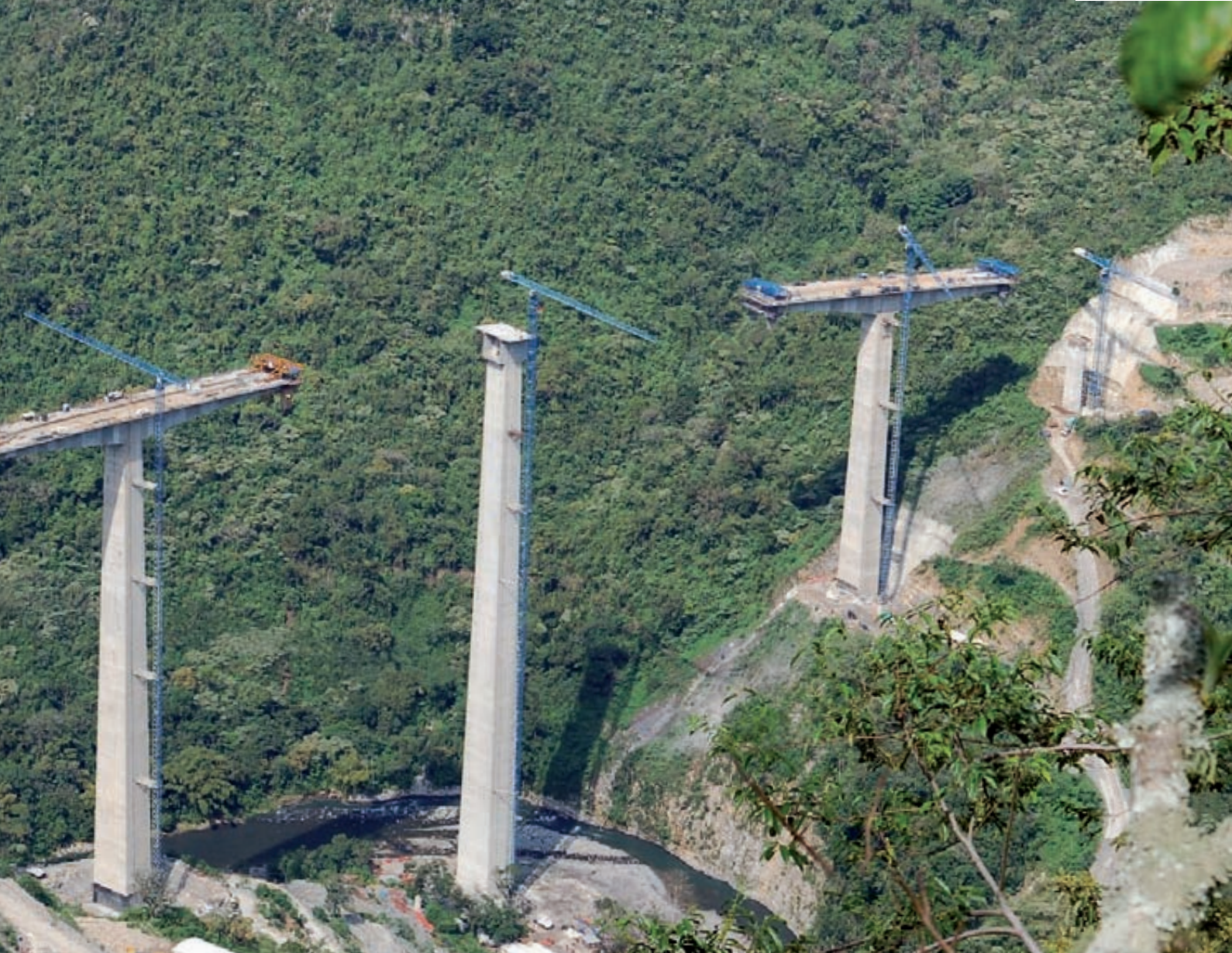
► Ejecución del tablero por voladizos sucesivos. Página opuesta, encofrado autotrepante de la pila 4.
