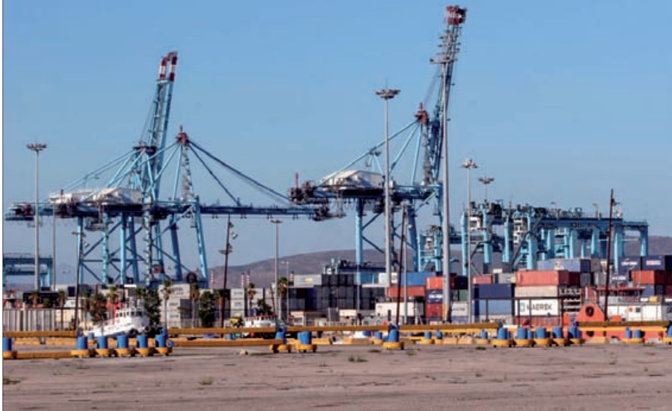
► Terminal del puerto de Algeciras, en el Corredor Mediterráneo.
