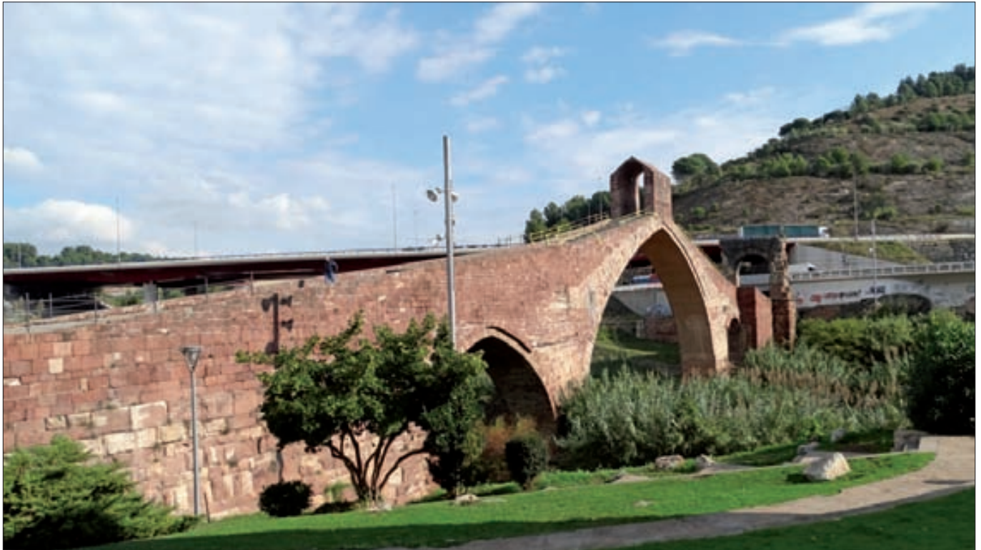
► En la página de la izquierda, arco honorífico del puente del Diablo, en Martorell. Arriba, el mismo puente aguas abajo (margen derecha).
