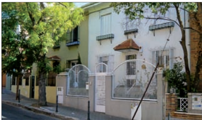
► Chalets adosados de la colonia Iturbe III.
