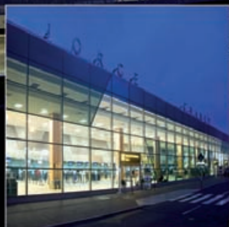
Supervisión de las Obras de Ampliación del Aeropuerto Internacional Jorge Chávez en Lima, Perú
