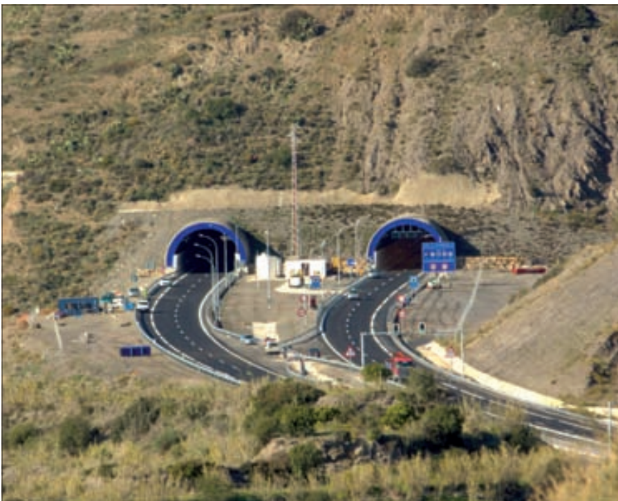
► Bocas del túnel de Los Ramoncillos (700 m), el más largo del tramo.
