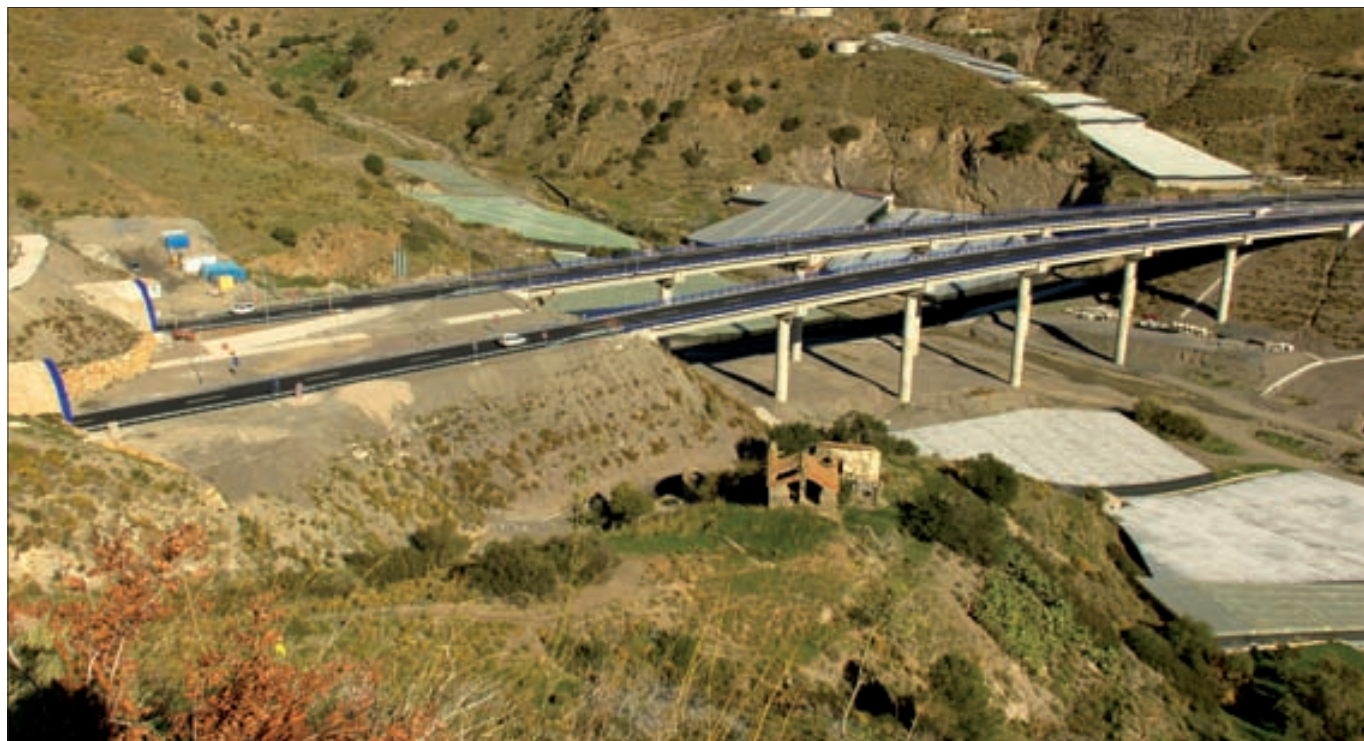
► Viaducto de la Rambla de Cautor y boca del túnel de La Guapa.
