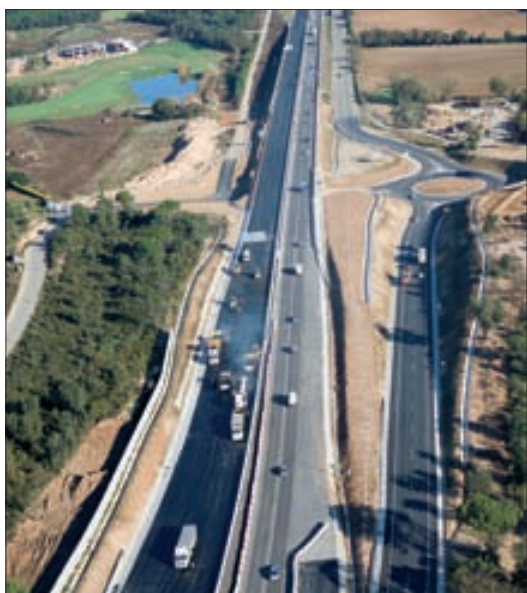
► Extendido del firme sobre la nueva calzada.
