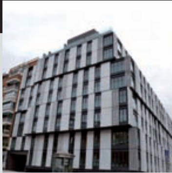
Madrid . 175 viviendas en Mindanao.
