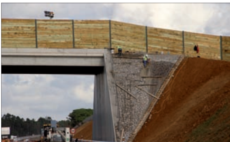
► Vista de la nueva calzada antes de su apertura y trabajos en un paso superior.
