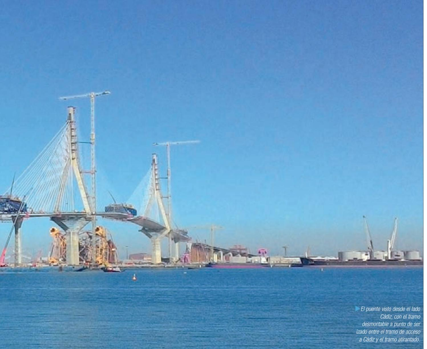
► El puente visto desde el lado Cádiz, con el tramo desmontable a punto de ser izado entre el tramo de acceso a Cádiz y el tramo atirantado.
