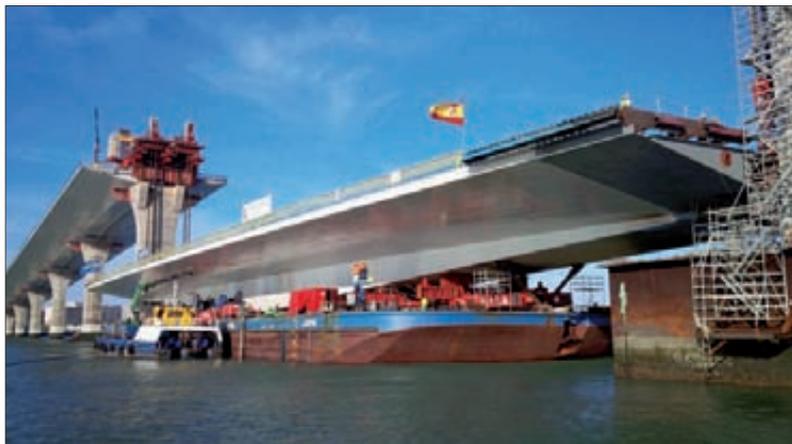
► Izado del tramo desmontable entre las pilas 9 y 10.
