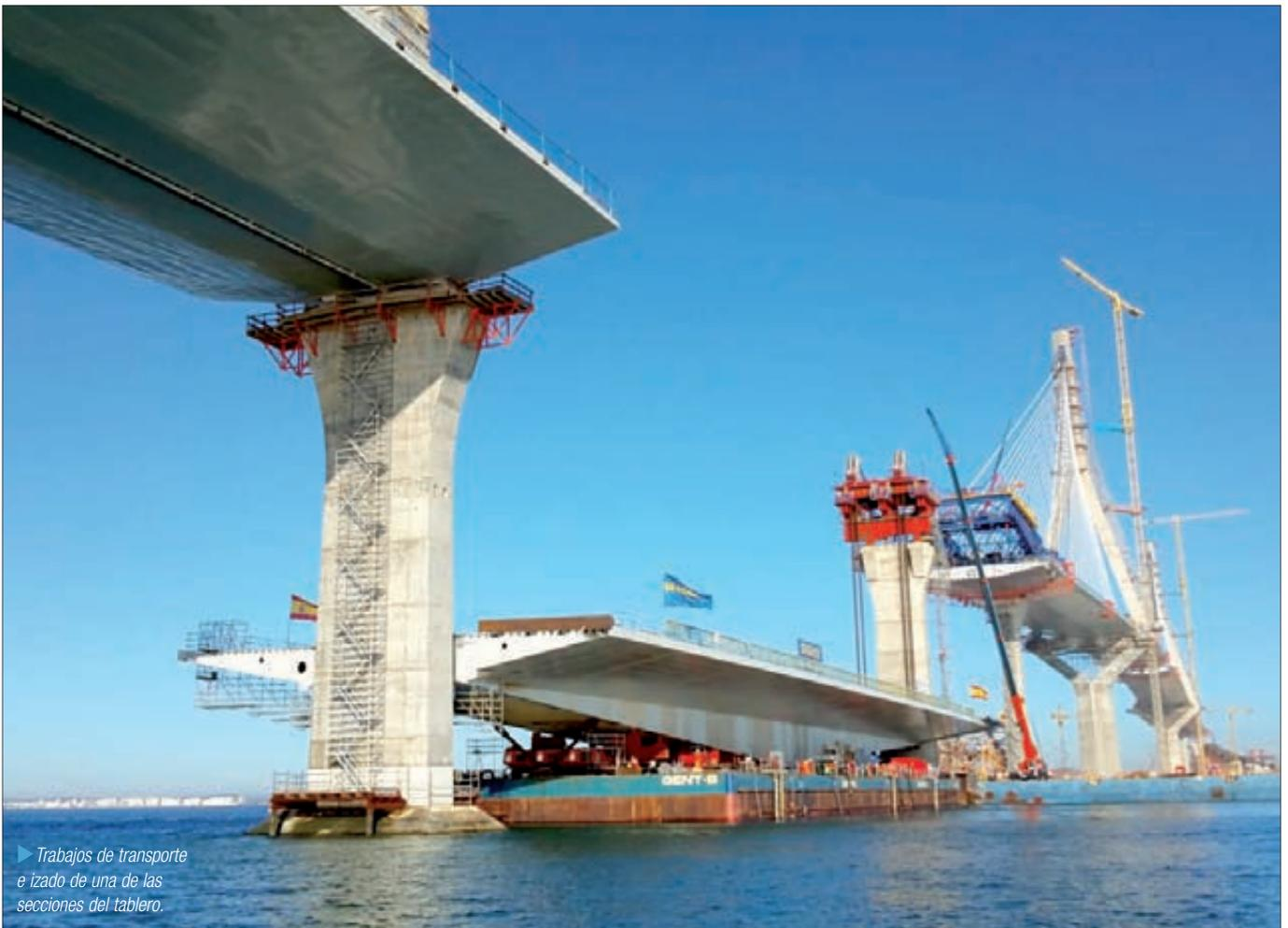
► Trabajos de transporte e izado de una de las secciones del tablero.
