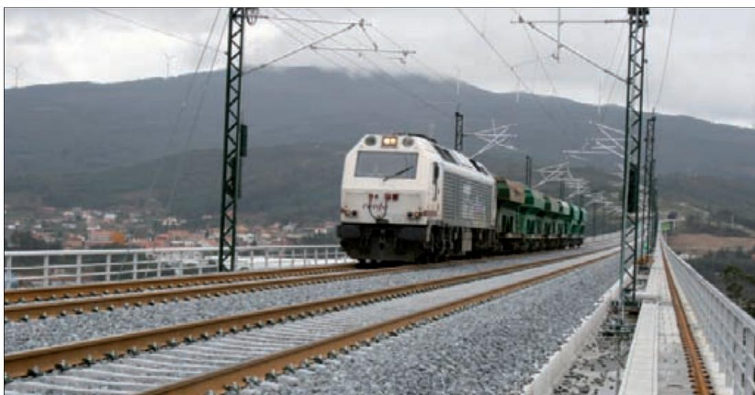
► Las pruebas de carga han permitido comprobar, entre otros vectores, el comportamiento del viaducto frente a acciones dinámicas.
