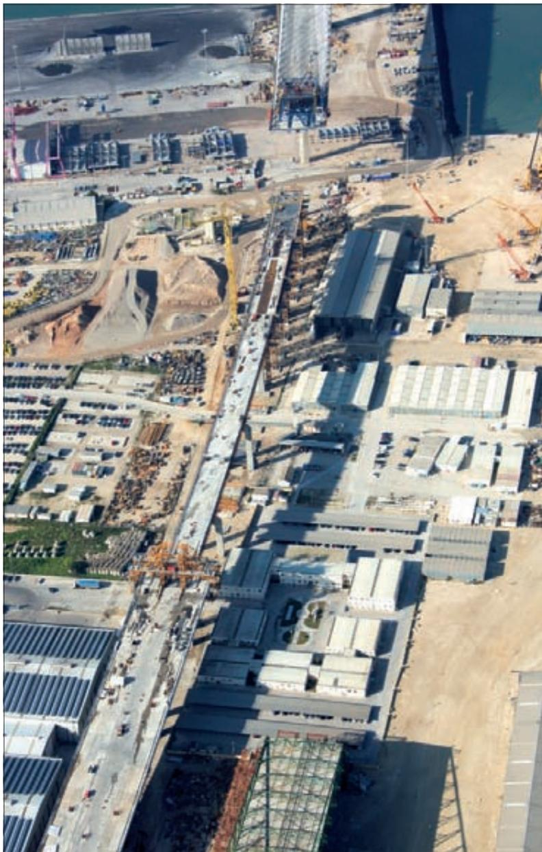
► Construcción del tablero y los voladizos del tramo de acceso a Puerto Real.
