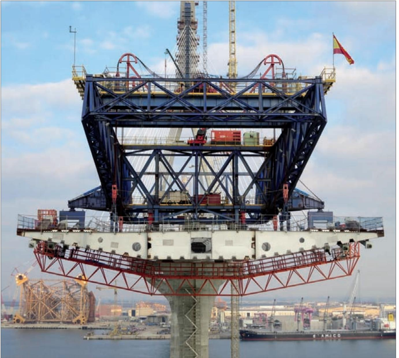
► Vista frontal de la sección de una dovela del tramo atirantado y carro de izado.
