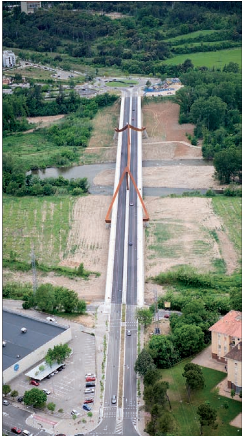
► Vista del puente desde el lado Este.
