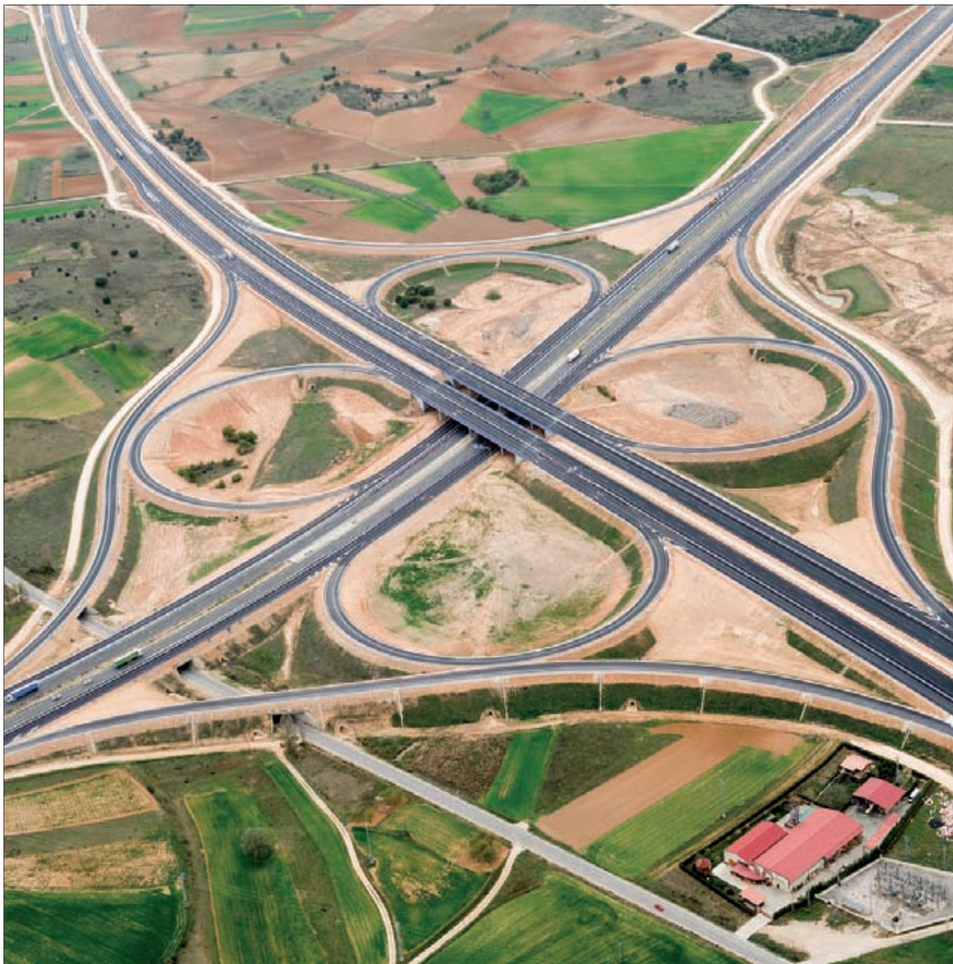
► Enlace de trébol completo con la autovía A-1, principal elemento de la variante.
