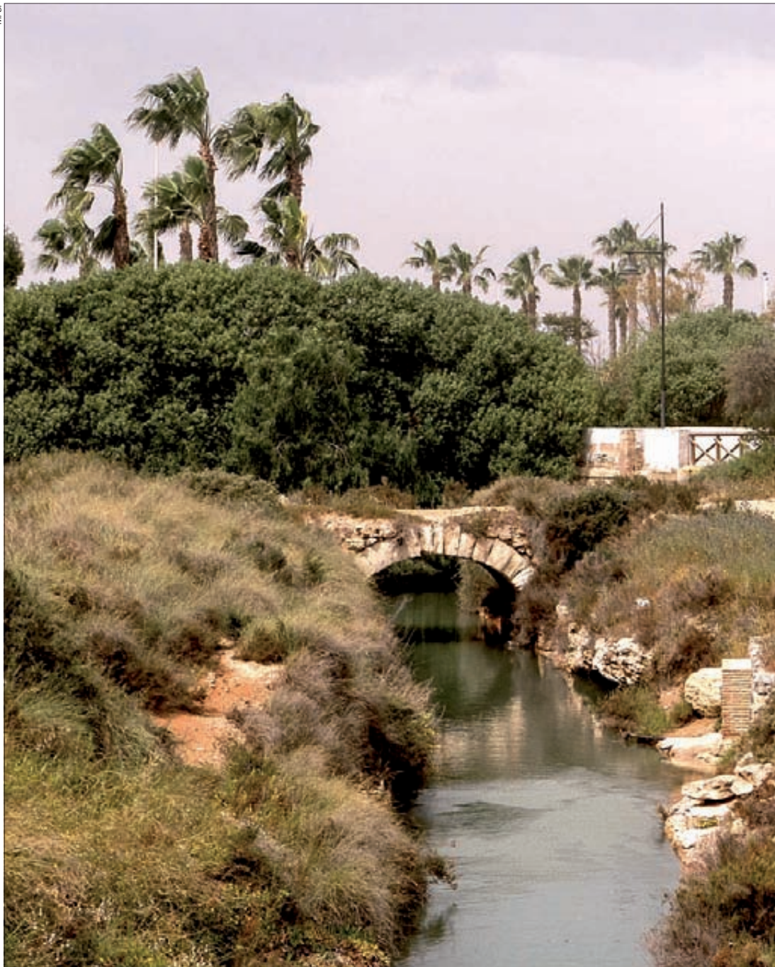
► Puente sobre el Acequión, canal finalizado en 1509 para llevar el agua de mar al interior de la laguna de Torrevieja. En la página opuesta, carguero atracado en el puerto de Torrevieja.
