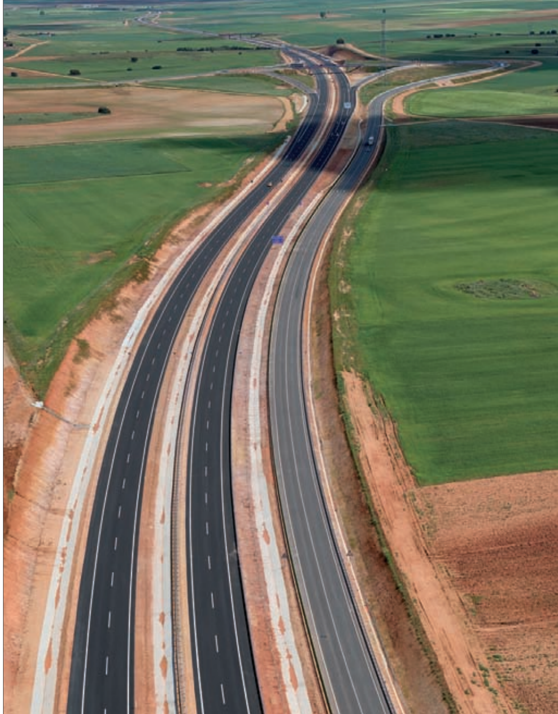
► La autovía A-66 discurre en paralelo a la carretera N-630 en buena parte del trazado. Al fondo, enlace de Fontanillas de Castro.
