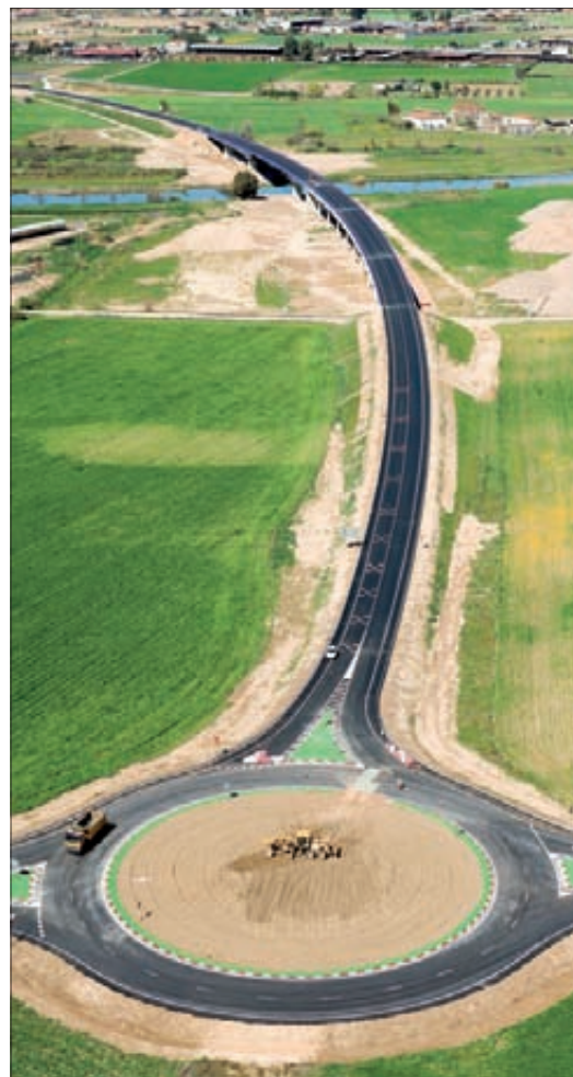
► Glorieta de conexión con la N-502.
