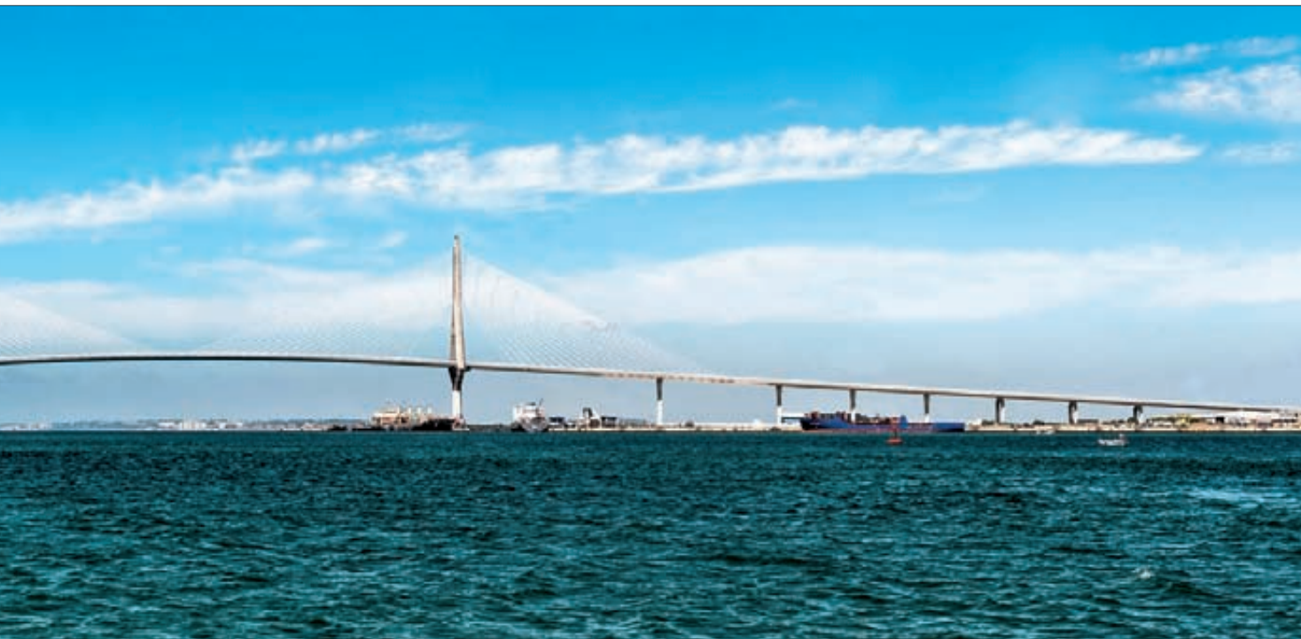
► Vista frontal del puente desde la bahía (arriba) y detalle del tablero y de las torres de atirantamiento.
