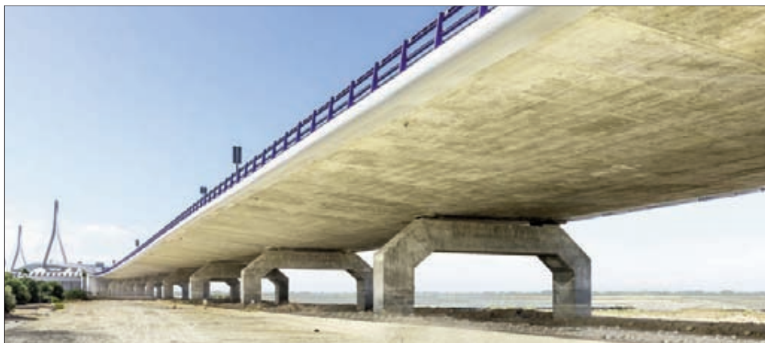
► Vista parcial del tramo atirantado (arriba) y viaducto de acceso a Puerto Real, con pilas tipo pórtico.
