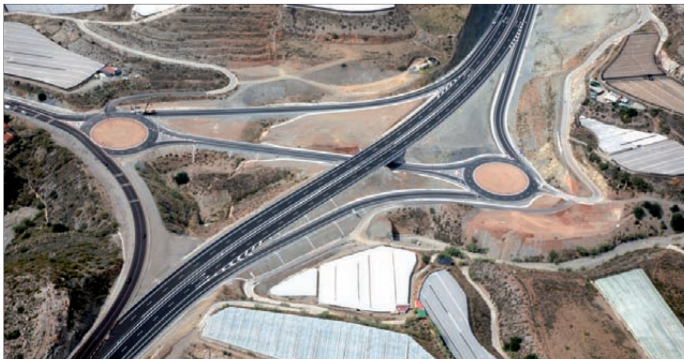
► Enlace de Castell de Ferro, final del tramo.
