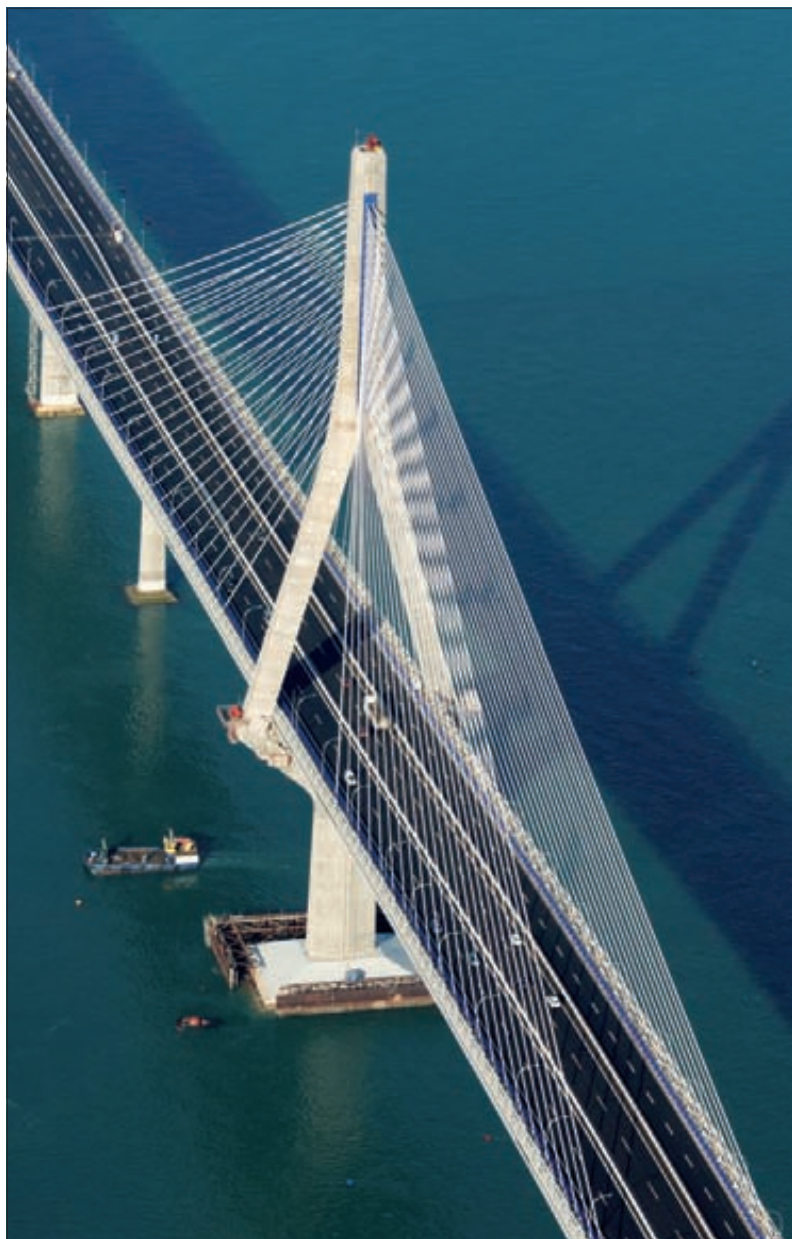
► Vista parcial del tramo atirantado (arriba) y viaducto de acceso a Puerto Real, con pilas tipo pórtico.
