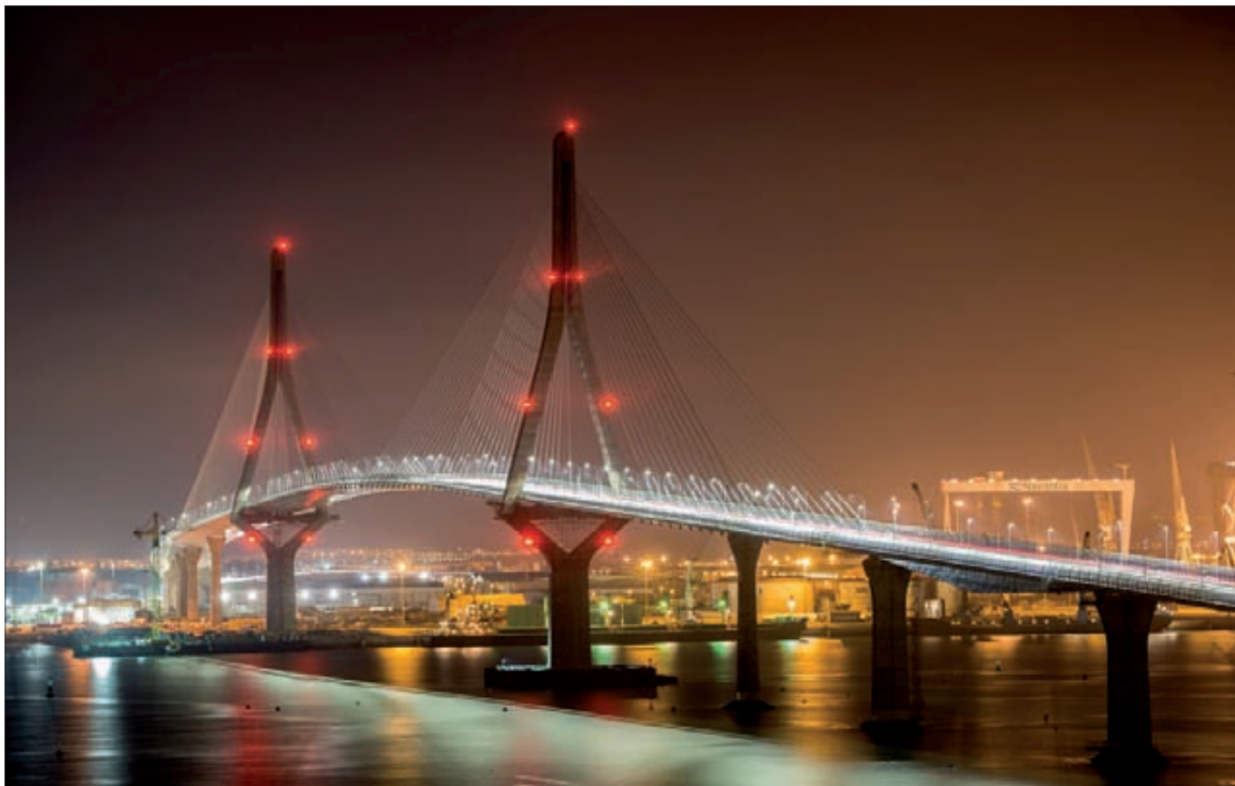
► Detalle de los tirantes anclados a una de las torres de atirantamiento (página opuesta) y vista nocturna del nuevo puente.
