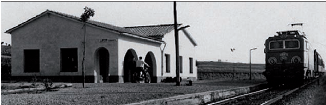
► Sobre estas líneas, estación de Lavern-Subirats. Debajo, estación de Torredembarra.
