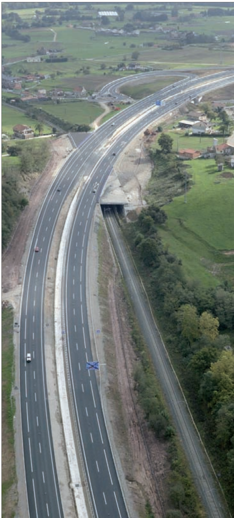
► Paso superior en pérgola sobre el ferrocarril Palencia-Santander, cerca de Zurita.
