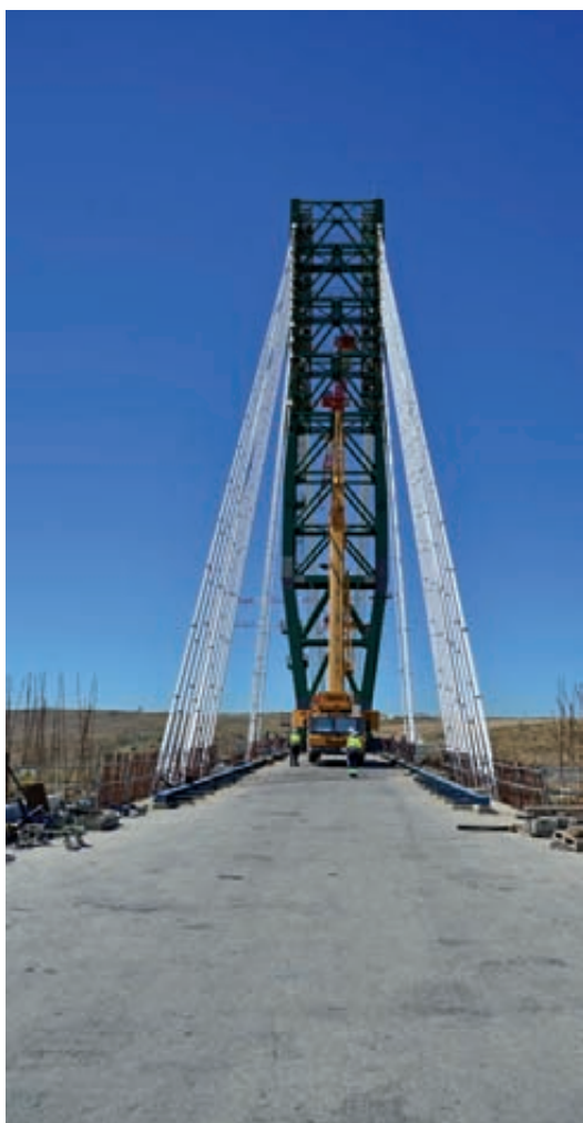
► Trabajos de atirantamiento provisional en el tablero.
