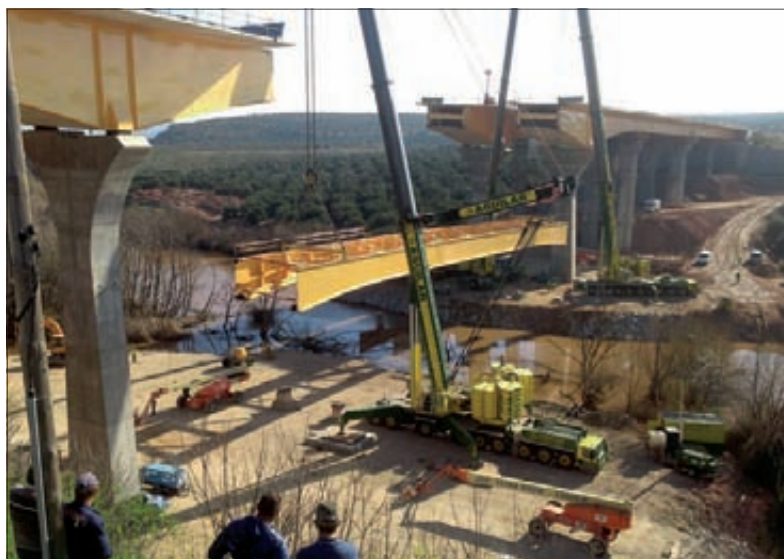
► Izado de viga metálica del viaducto sobre el río Guadalimar.
