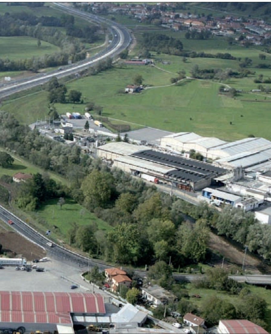
► Enlace de La Penilla, con tipología de diamante con pesas, y cruce sobre el río Pisueña.
