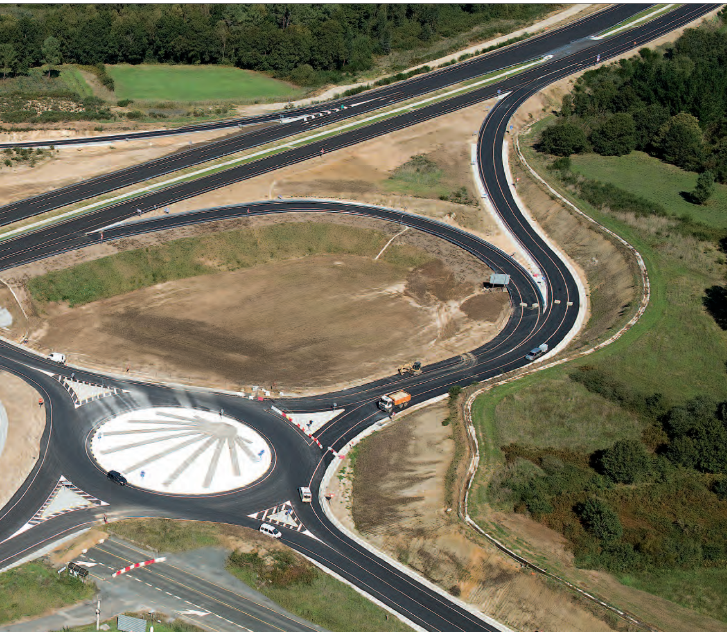
► El enlace de Palas de Rei (Oeste), con tipología de trébol parcial, es el final del tramo.
