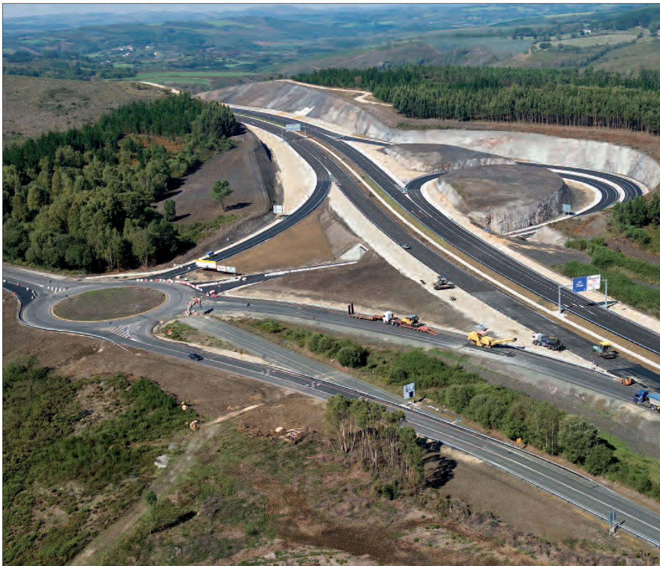
► Enlace de Guntín se sitúa en el inicio de la obra, conectando con la glorieta existente en la carretera N-547 y facilitando el acceso a la carretera N-540 (Ourense).
