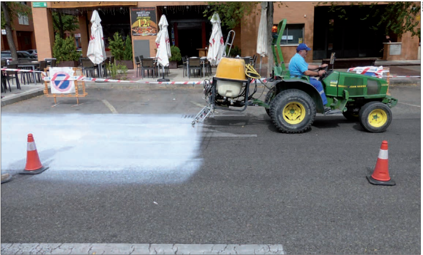
► Página opuesta y arriba, aplicación de producto fotocatalítico sobre asfalto de una calle de Alcobendas, en el marco del proyecto LIFE MINOX-STREET.
