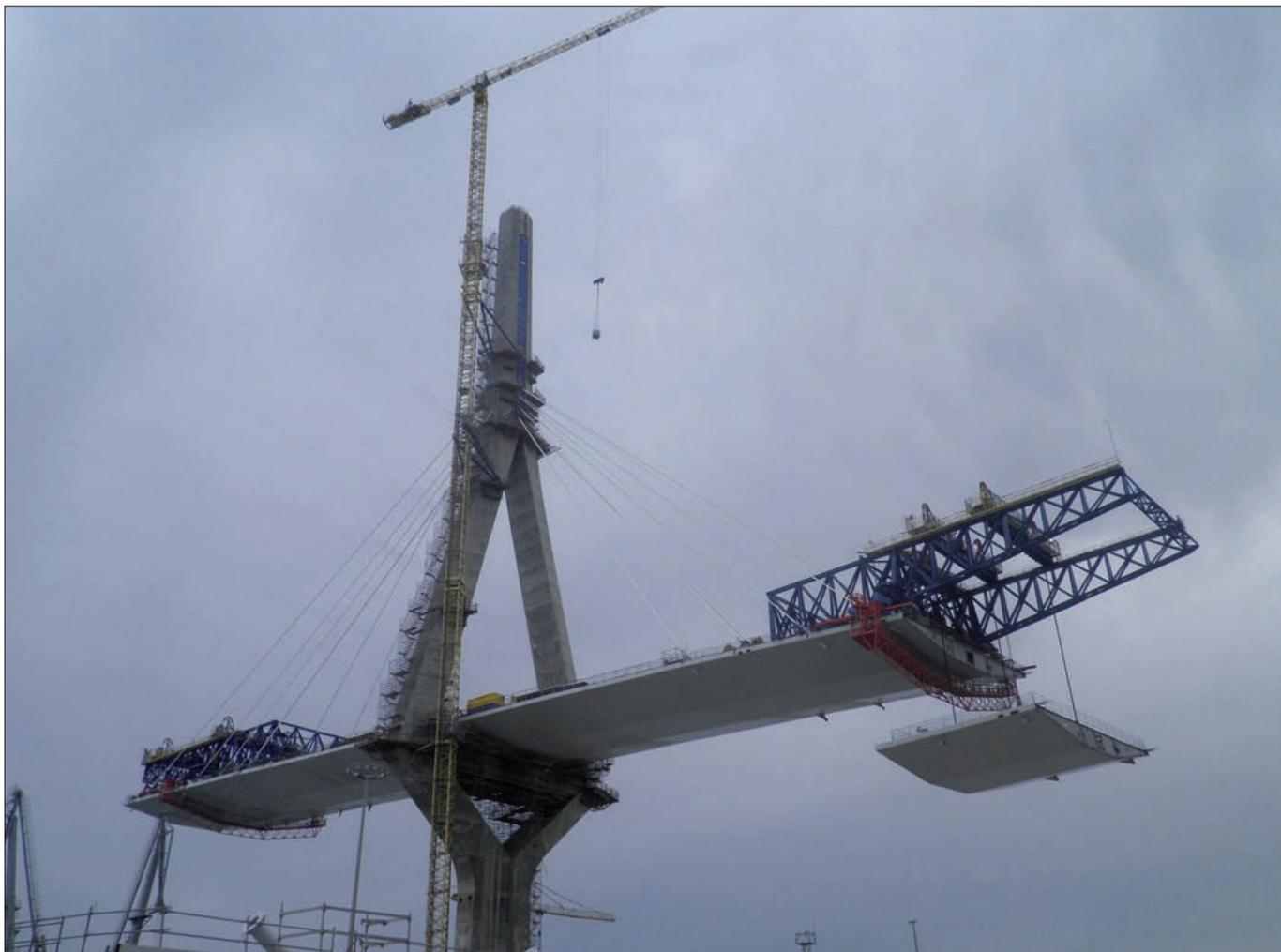
► Izado de una de las dovelas del tramo atirantado.
