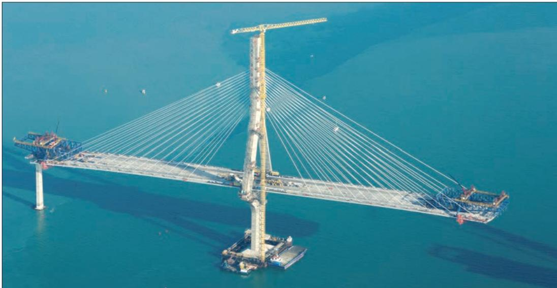
► Construcción del tramo atirantado mediante avance en voladizo, un sistema respetuoso con las aguas de la bahía.
