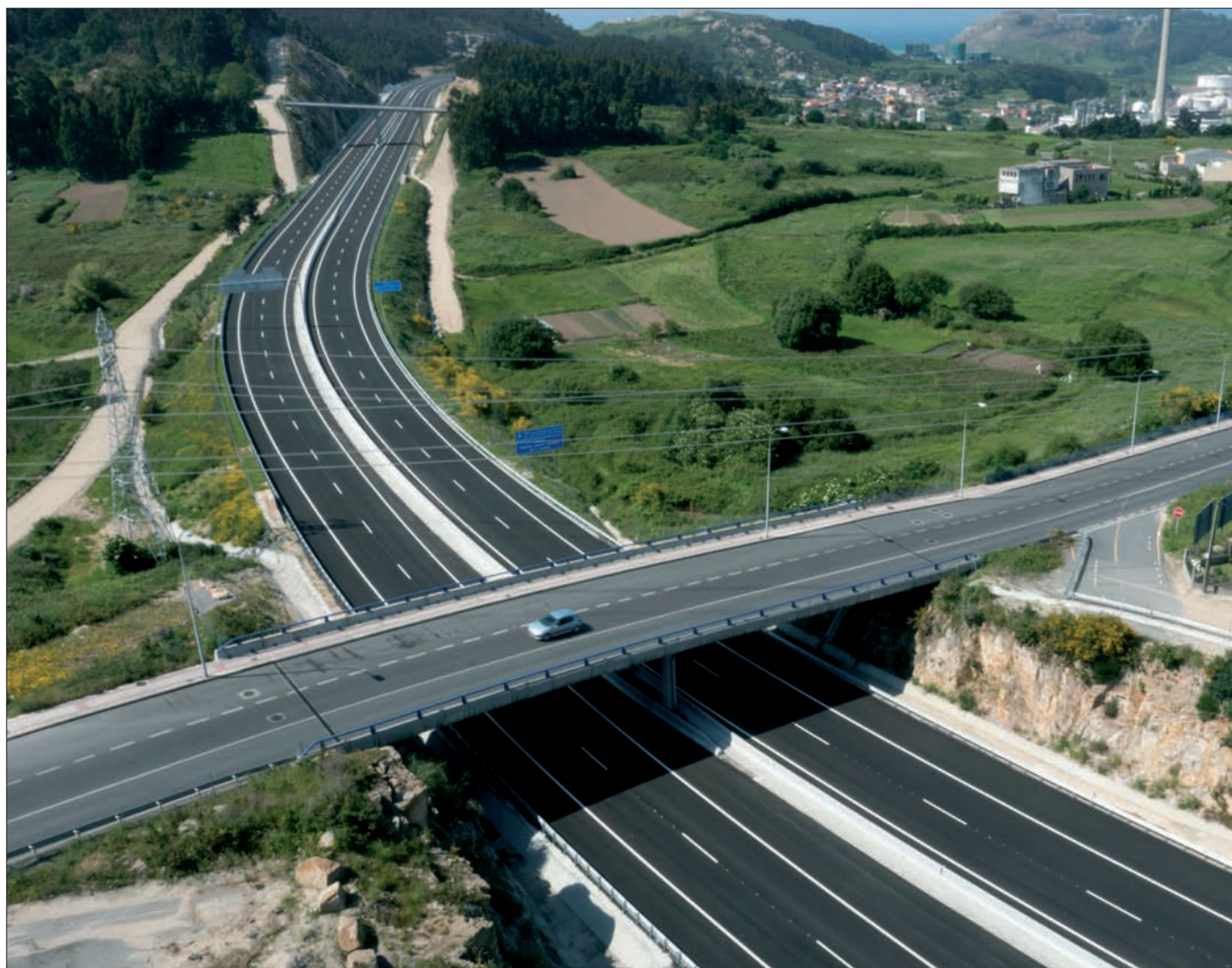
► Paso superior de la carretera autonómica AC-415 sobre la autovía AC-15.
