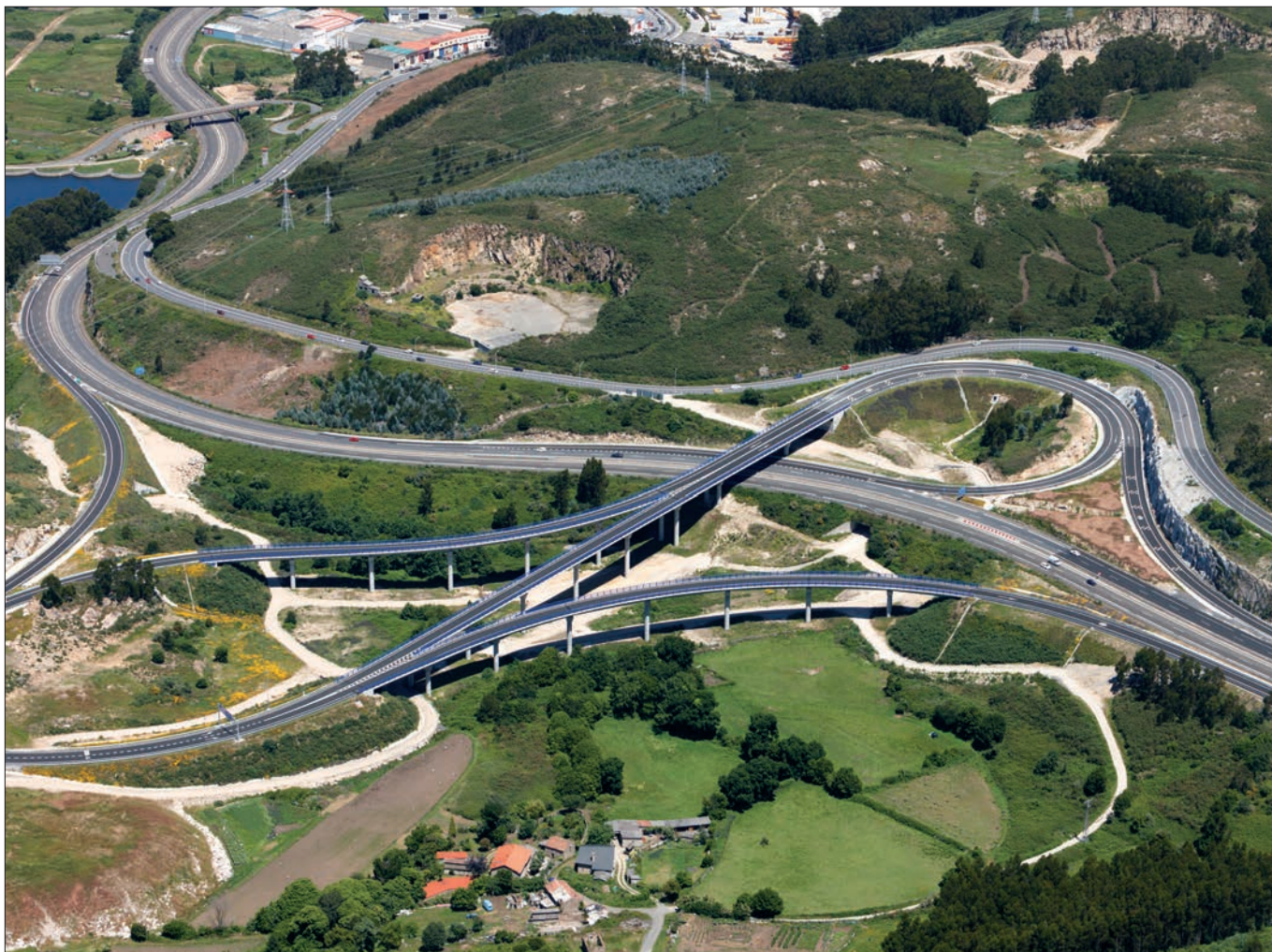
► Enlace de la autovía AC-15 con la autopista AG-55 en la zona de Furoca, que incluye tres nuevos viaductos y un lazo de conexión.
