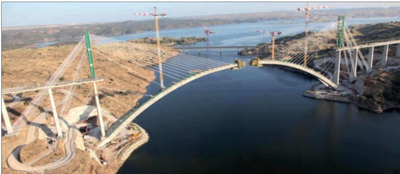
► Fase final de la construcción del arco, con el sistema de atirantamiento montado, en una imagen de agosto de 2015.
