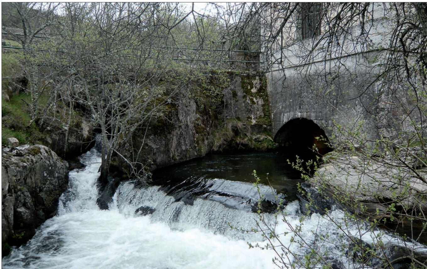
► Azud de la central de Santa Isabel (arriba) y escala salmonera de la presa del Salto del Olvido.
