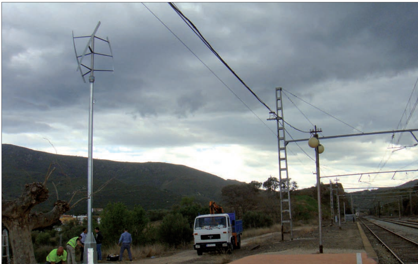
► La energía eólica obtenida mediante aerogeneradores alimenta parte de las instalaciones de una estación. En la imagen, aerogenerador de eje vertical en la estación de Llançà (Girona).
