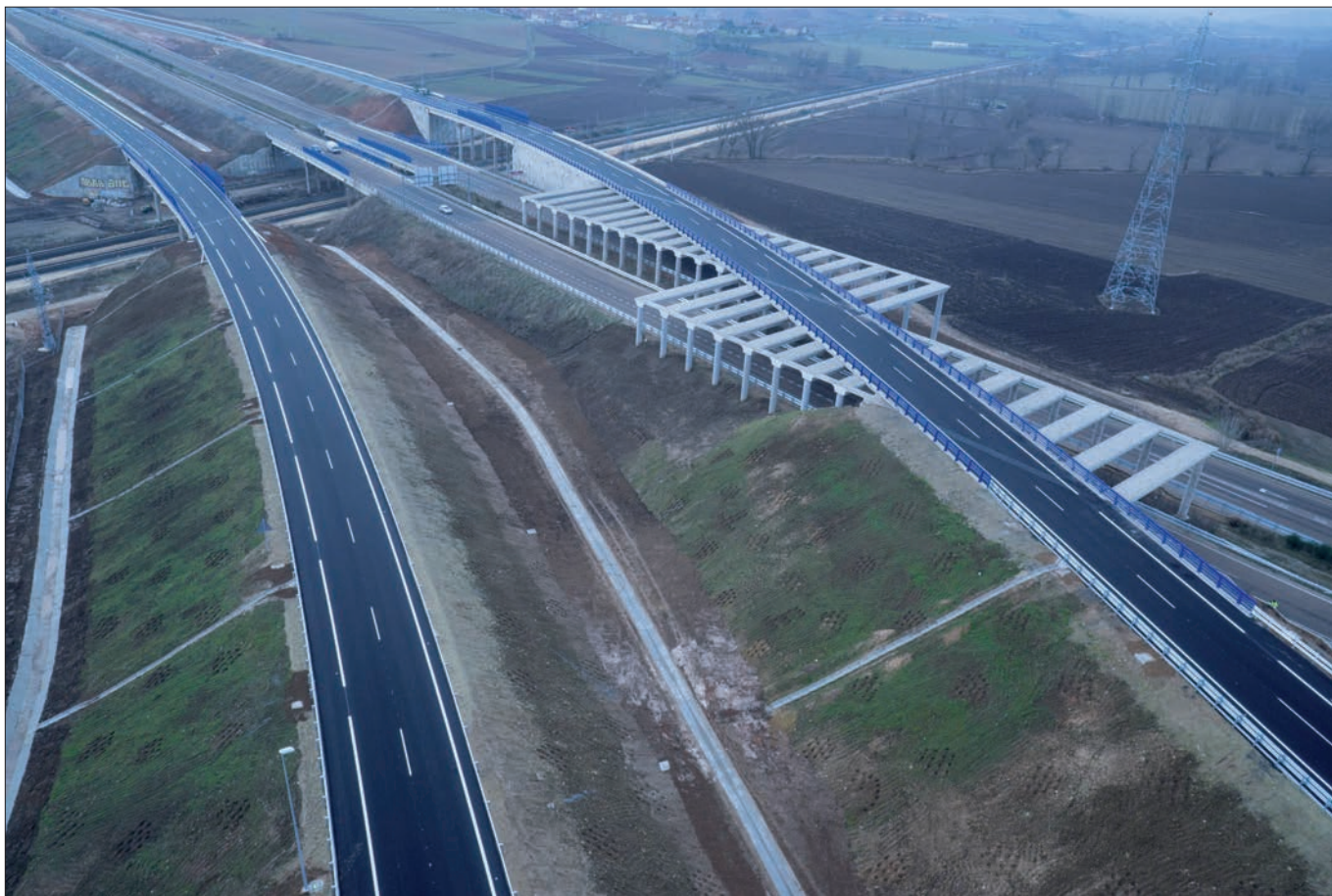
► Calzadas separadas al inicio del tramo, con sendas estructuras sobre la vía del ferrocarril Madrid-Hendaya y estructura en pérgola sobre la autovía A-231 en la calzada derecha.
