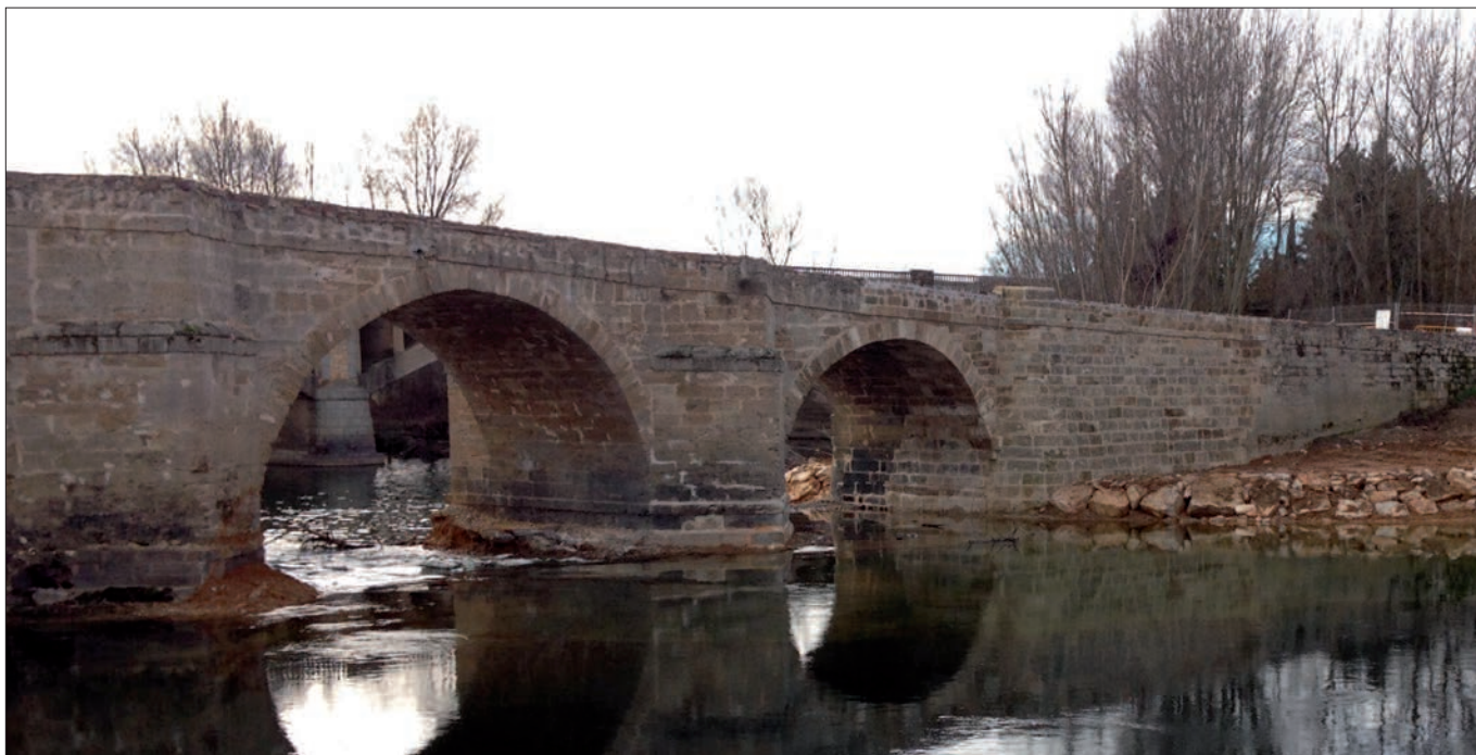
► Vista de la zona del puente una vez rehabilitado, en febrero pasado.
