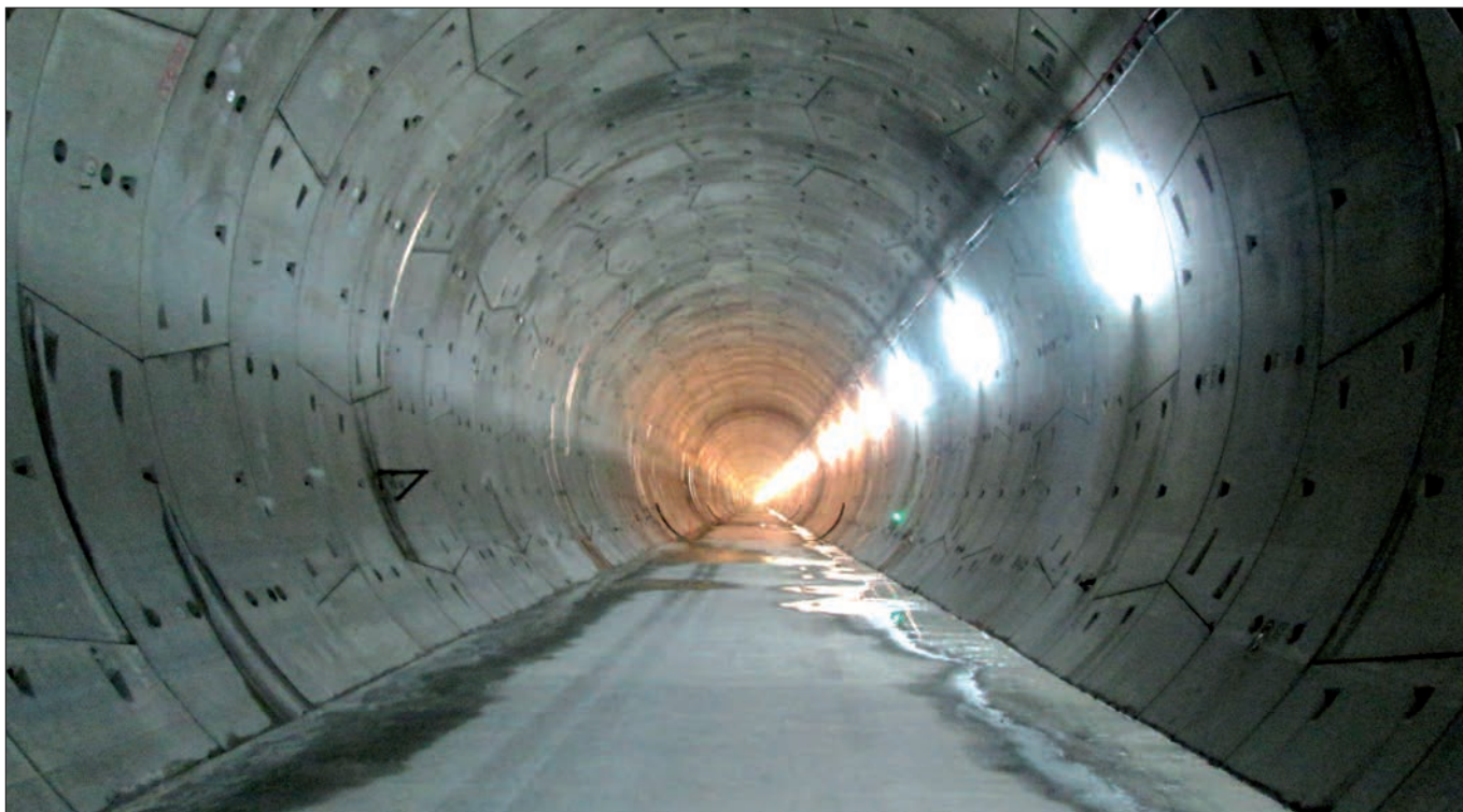
► Interior del túnel de vía derecha, con sección libre de 52 m 2 y revestido con dovelas trapezoidales.
