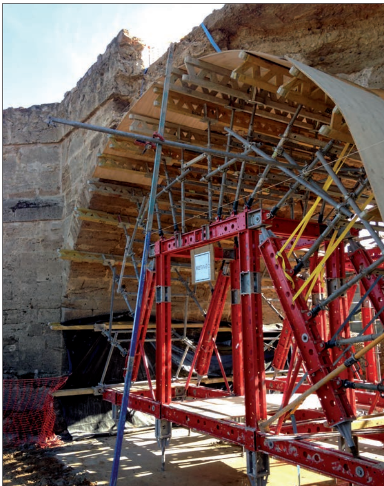
► Arriba, cimbra bajo la bóveda dañada, destinada a apoyar su reconstrucción. Derecha, reconstrucción del muro del estribo.
