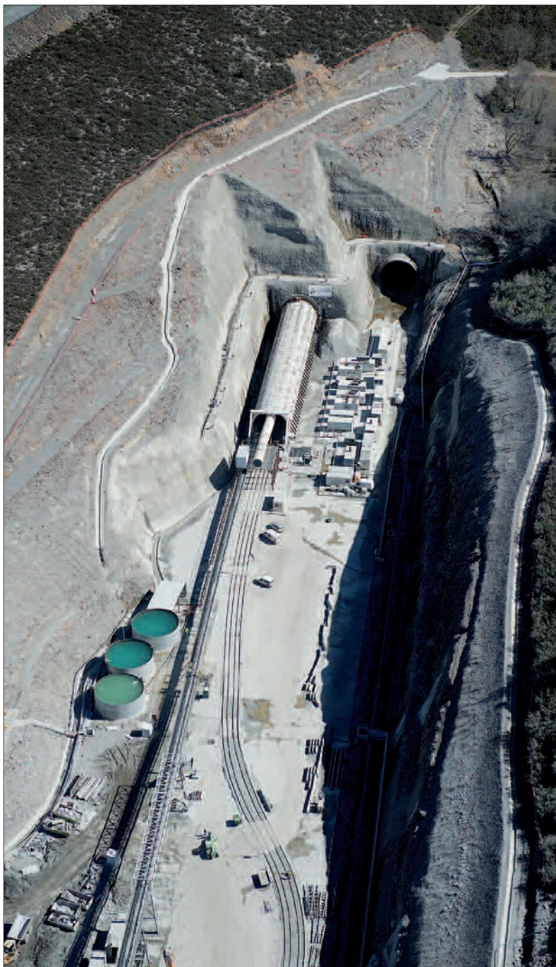
► Vista aérea de la boca del lado Campobeceros, lugar de ataque de ambos tubos.
