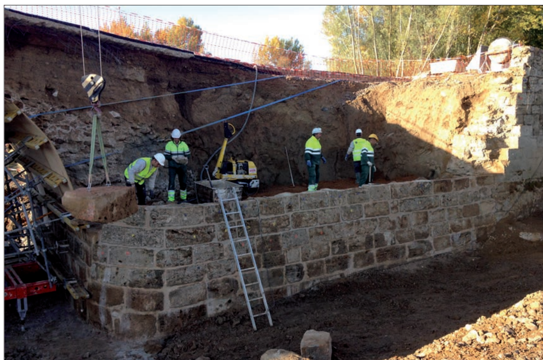
► Arriba, cimbra bajo la bóveda dañada, destinada a apoyar su reconstrucción. Derecha, reconstrucción del muro del estribo.
