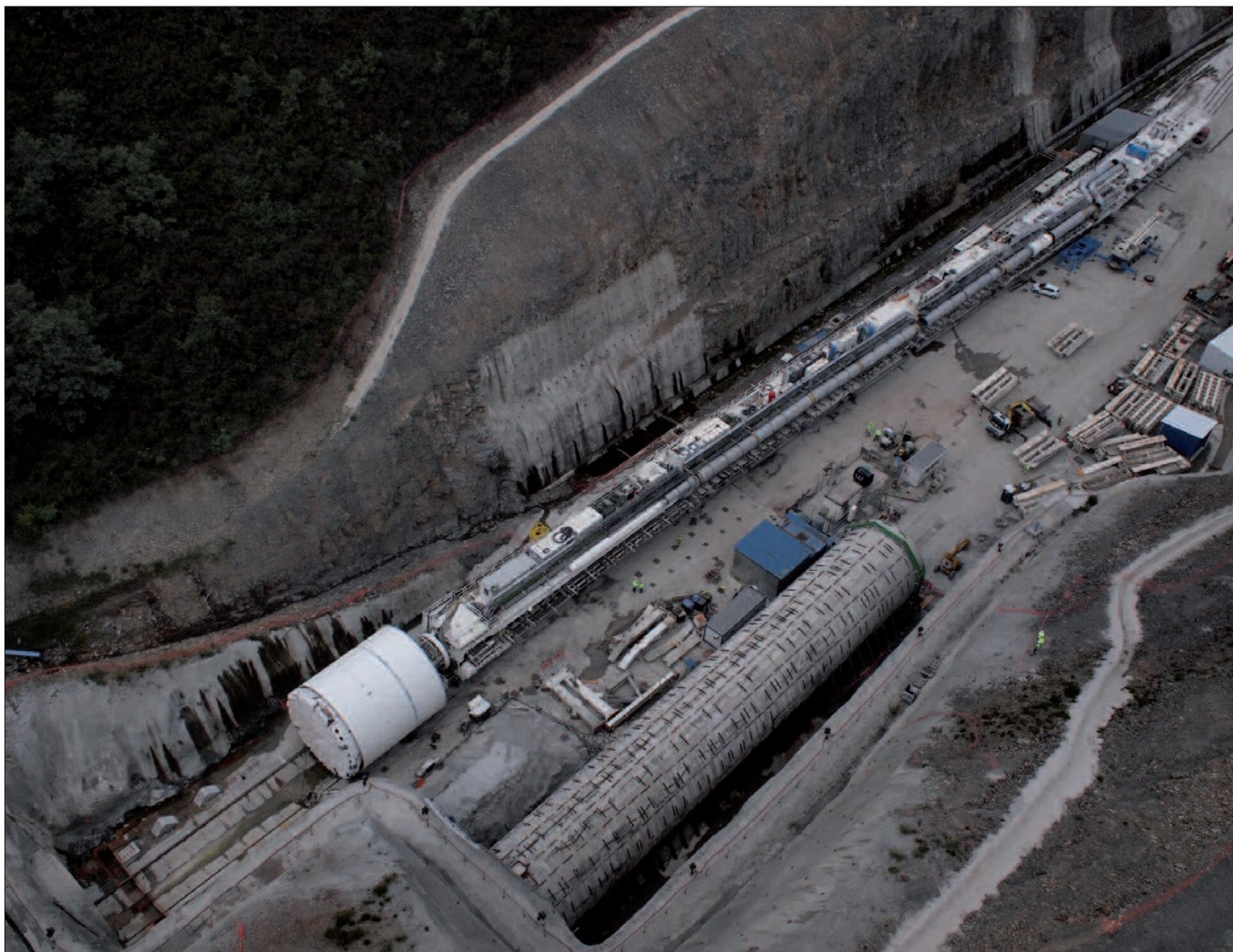
► Vista aérea de La Peregrina, con su back-up de más de 100 metros de longitud, poco antes de atacar el túnel de vía izquierda.
