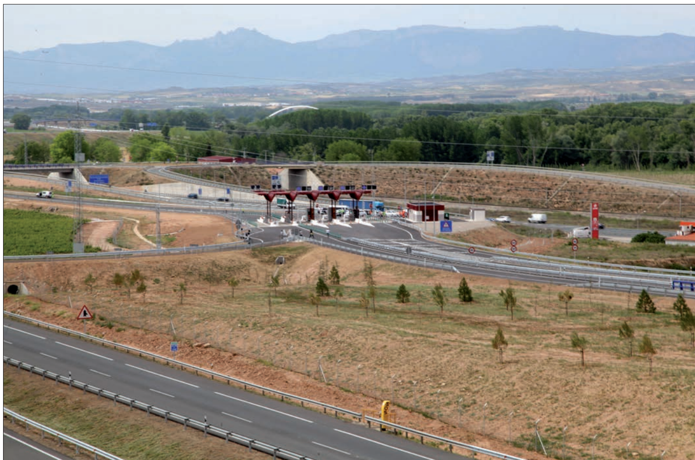
► Playa de peaje, situada entre la autopista AP-68 y la autovía LO-20.
