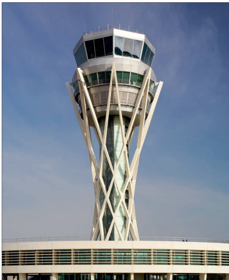
► Torre de control del aeropuerto de Barcelona-El Prat.
