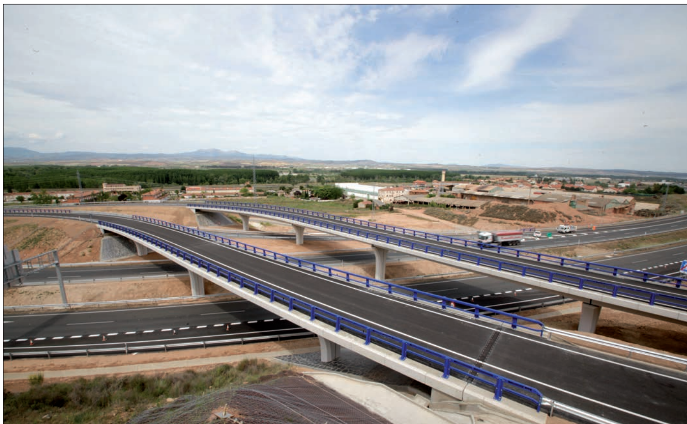
► Estructuras de los ramales del enlace sobre la autopista AP-68.
