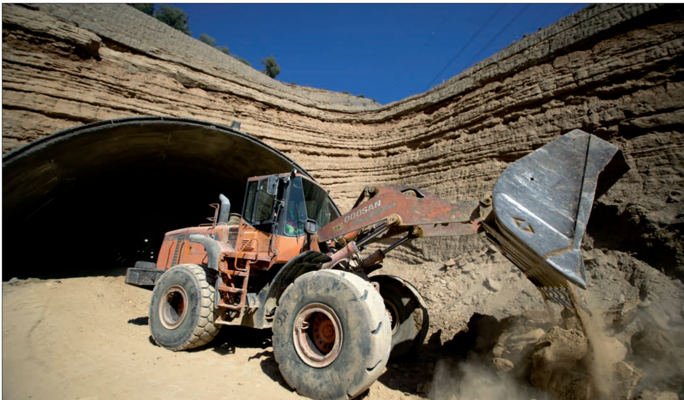
► La construcción del túnel de Olesa supone más del 50% del presupuesto de obra del tramo.
