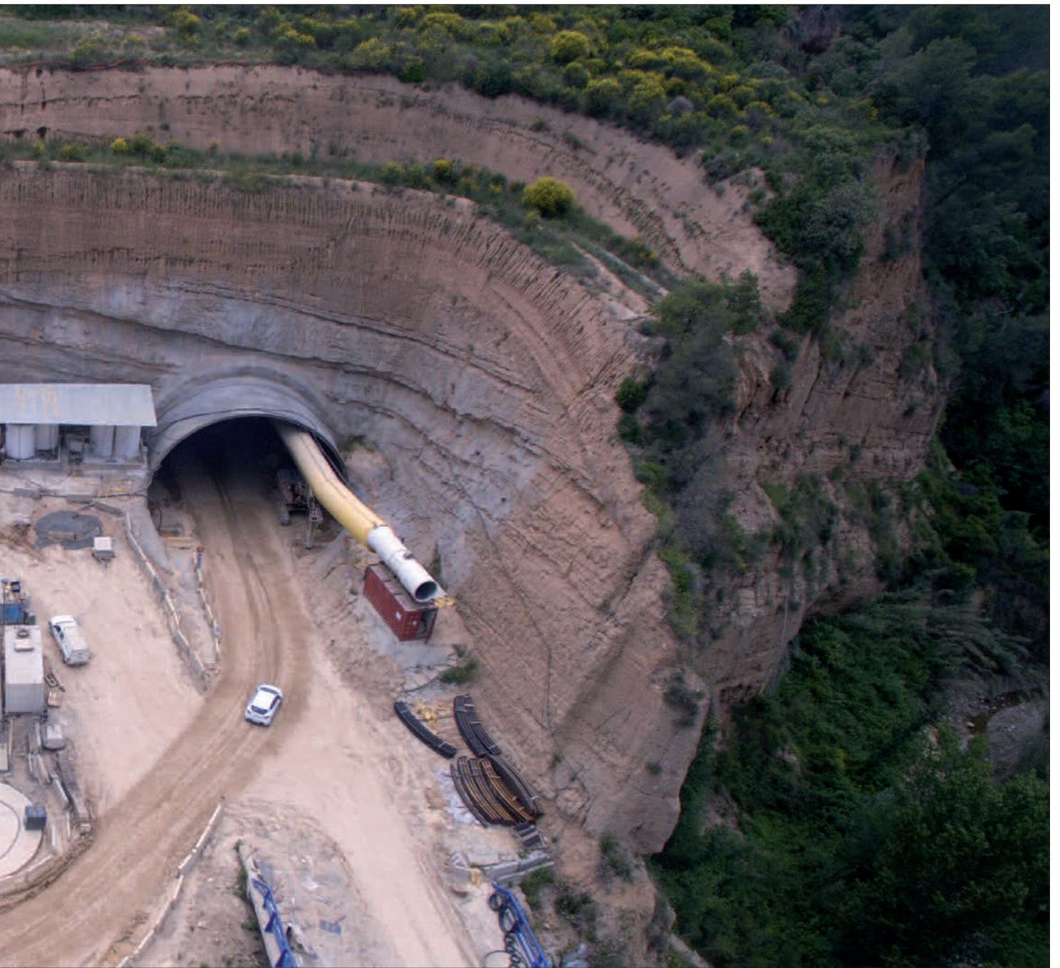
► Bocas del túnel de Olesa en el lado Terrassa.
