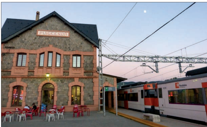
► Estación de Puigcerdà
