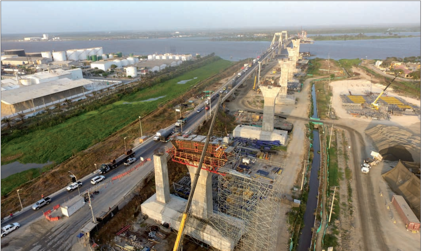
► Pilas levantadas en una orilla del Magdalena junto al actual puente Pumarejo. Debajo, la gigantesca autocimbra empleada para la ejecución del tablero.
