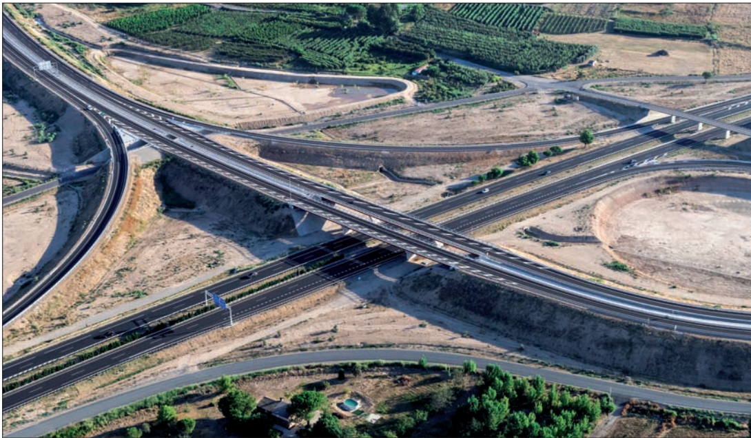
► Detalle de los dos viaductos sobre la A-2 correspondientes al enlace donde nace el tramo Lleida-Rosselló de la A-14.
