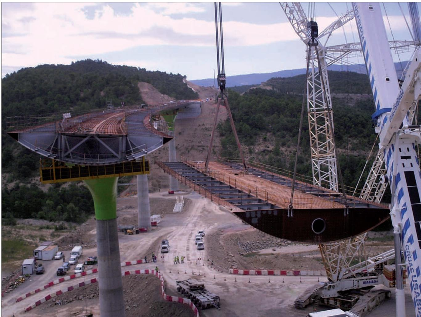
► Colocación de uno de los tramos metálicos del tablero.
