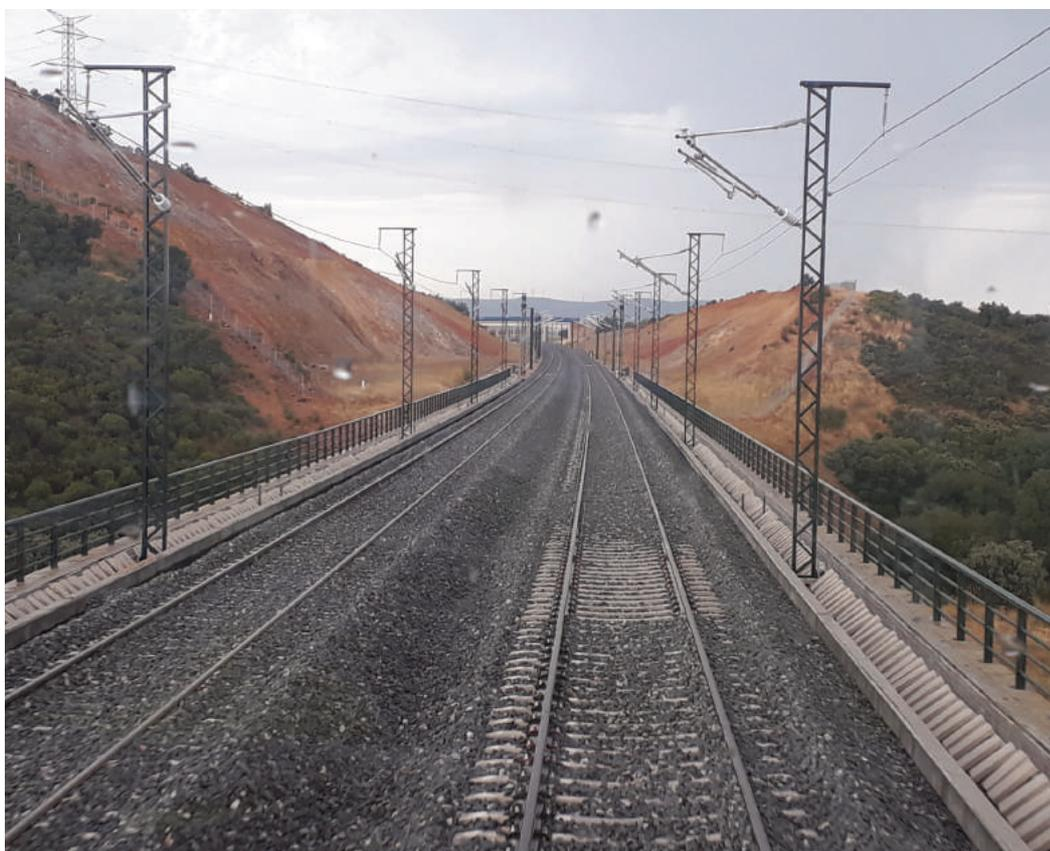
► Plataforma con vía montada y electrificación instalada en el subtramo Perilla de Castro-Otero de Bodas, en Zamora.
