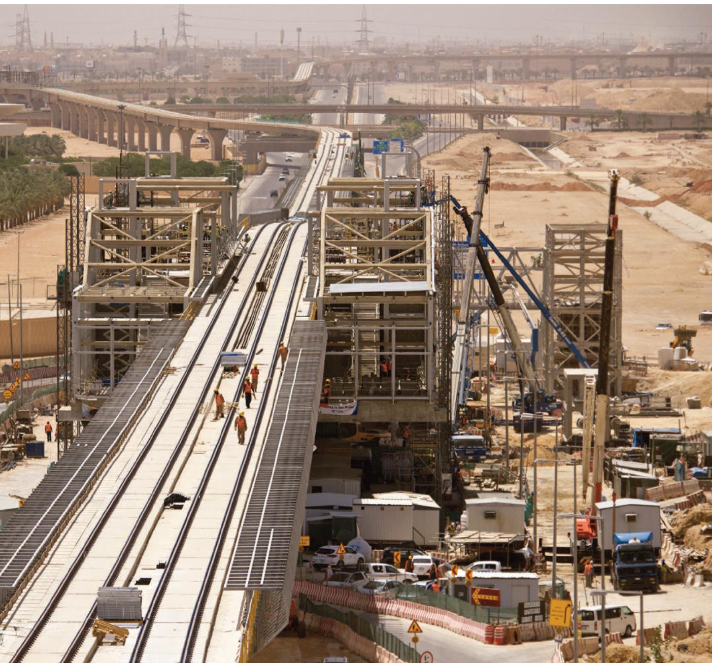
► Tramo en viaducto con estación elevada y las vías ya instaladas en la línea 6.
