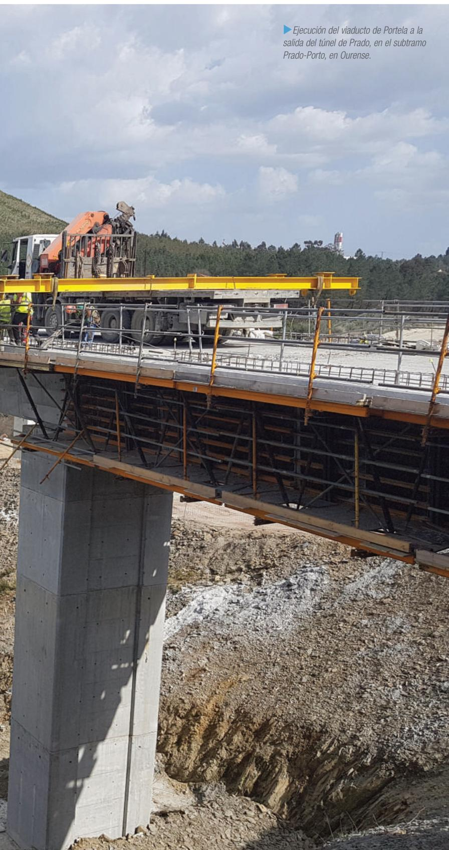
► Ejecución del viaducto de Portela a la salida del túnel de Prado, en el subtramo Prado-Porto, en Ourense.
