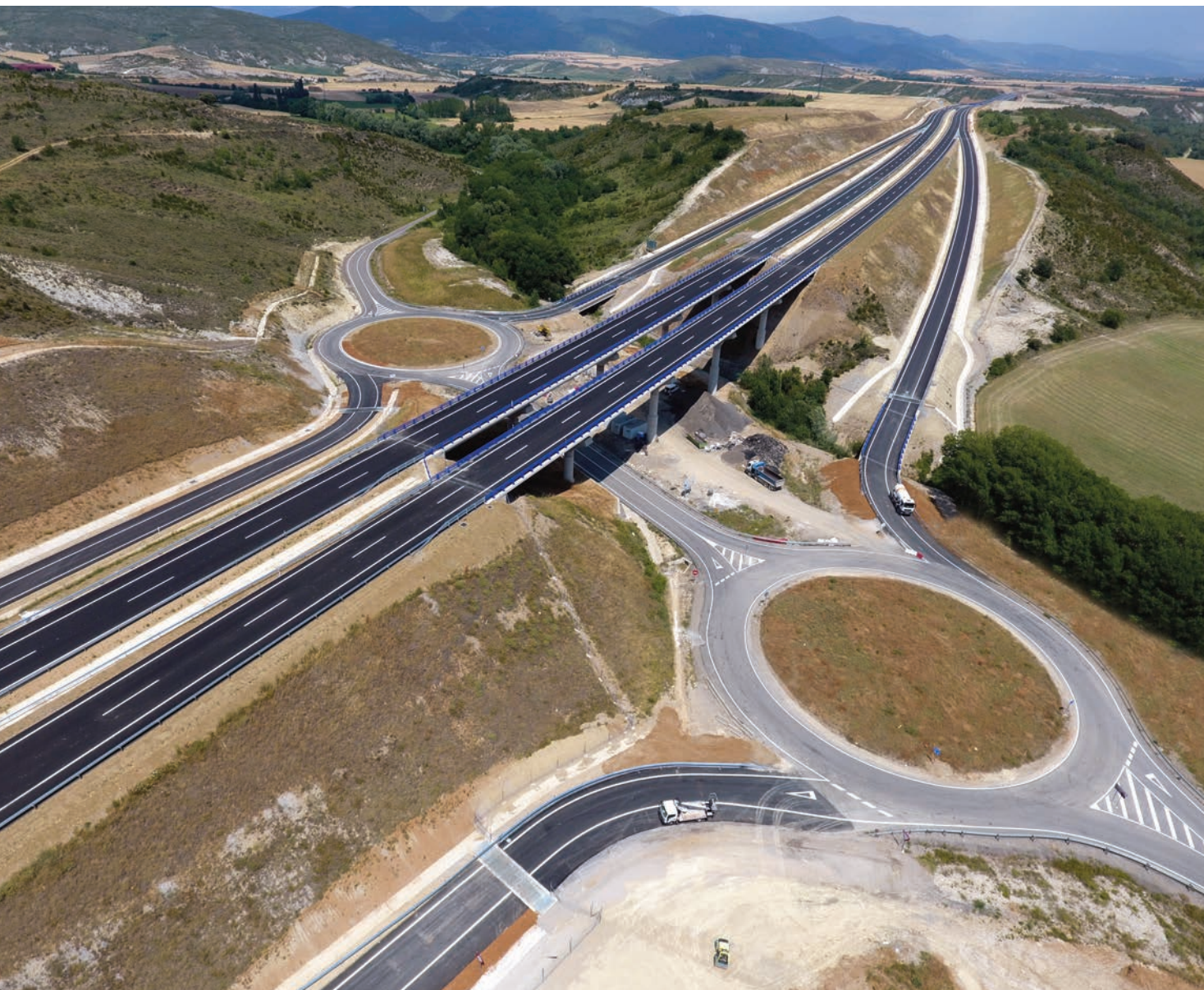
► Enlace de Ascara, con tipología de diamante con pesas y un viaducto que cruza sobre el barranco de la Fuente.
