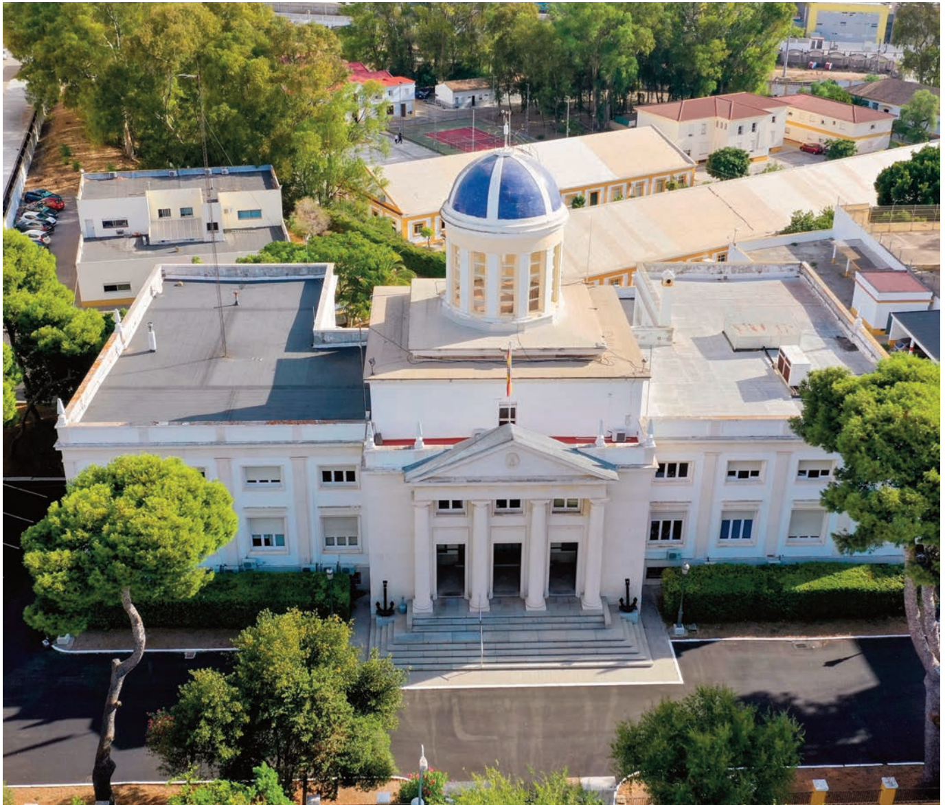
► Vista aérea del edificio principal del Instituto Hidrográfico de la Marina.
