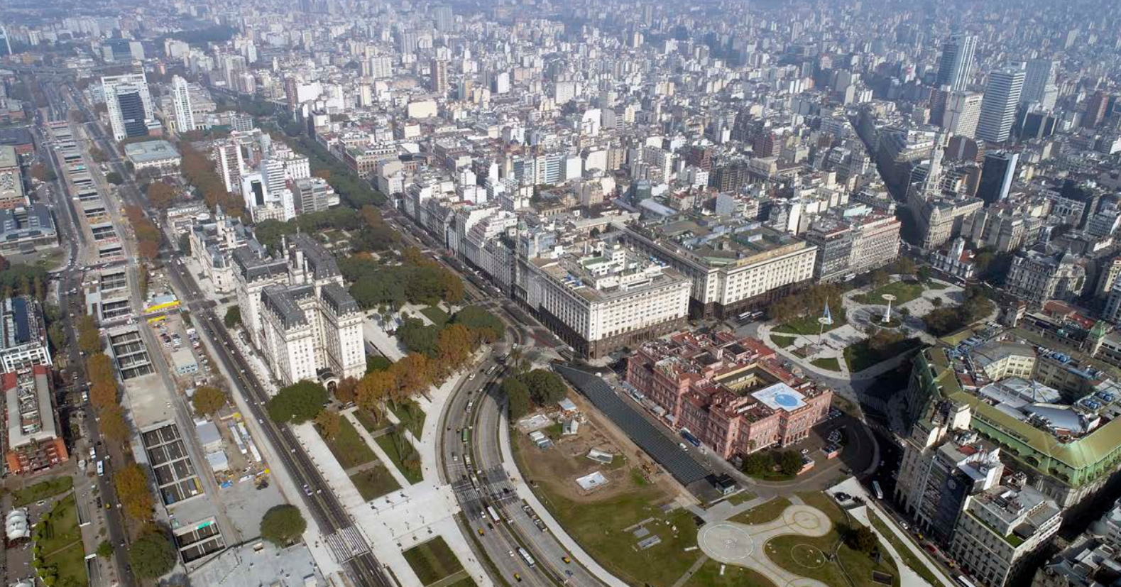
AMÉRICA DEL SUR: Vista del nuevo Paseo del Bajo de Buenos Aires. Ineco se ha encargado de la inspección de obra de uno de los tramos de esta obra civil que ha transformado la movilidad urbana en la capital argentina.
