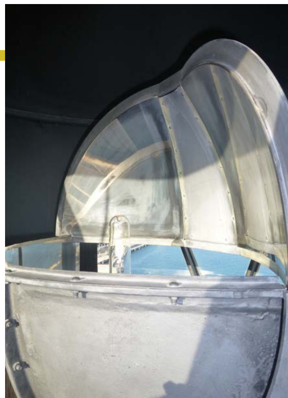
Sistema actual de pantallas reflectoras en el faro de Porto Pi
