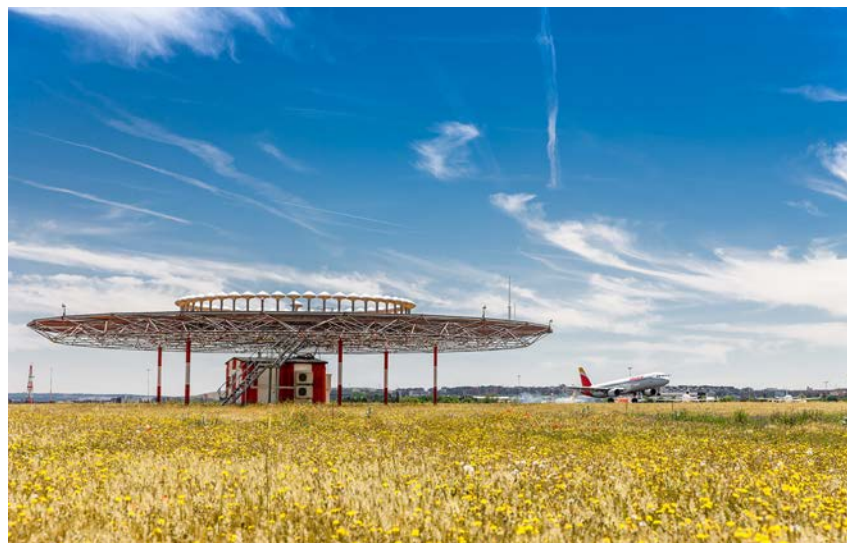
Instalación VOR de ENAIRE en Madrid
