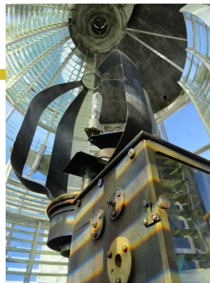
Óptica y sistema de pantallas de ocultaciones originales en el faro de Maspalomas
